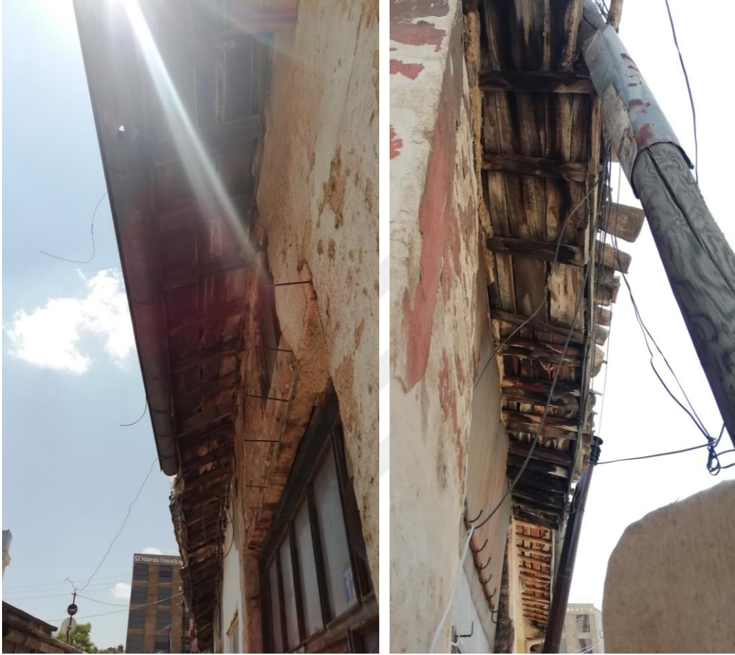
Şekil 5.12. Gevraki Han Saçak-Çatı Durumu
