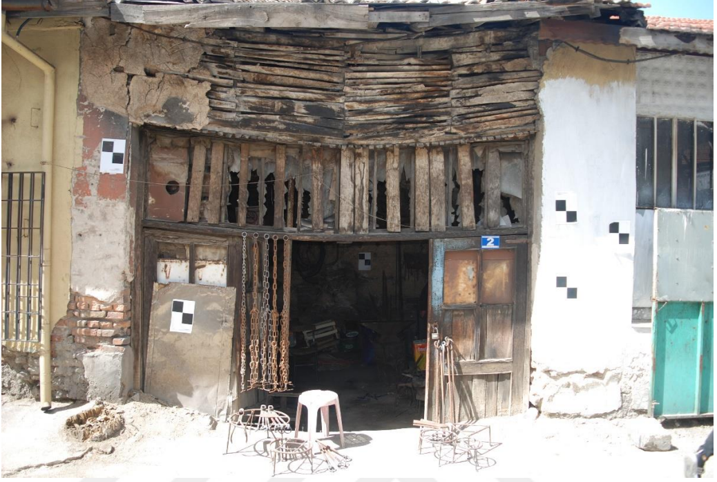
Şekil 5.17. Cepheye Yerleştirilmiş Hedef Noktaları
