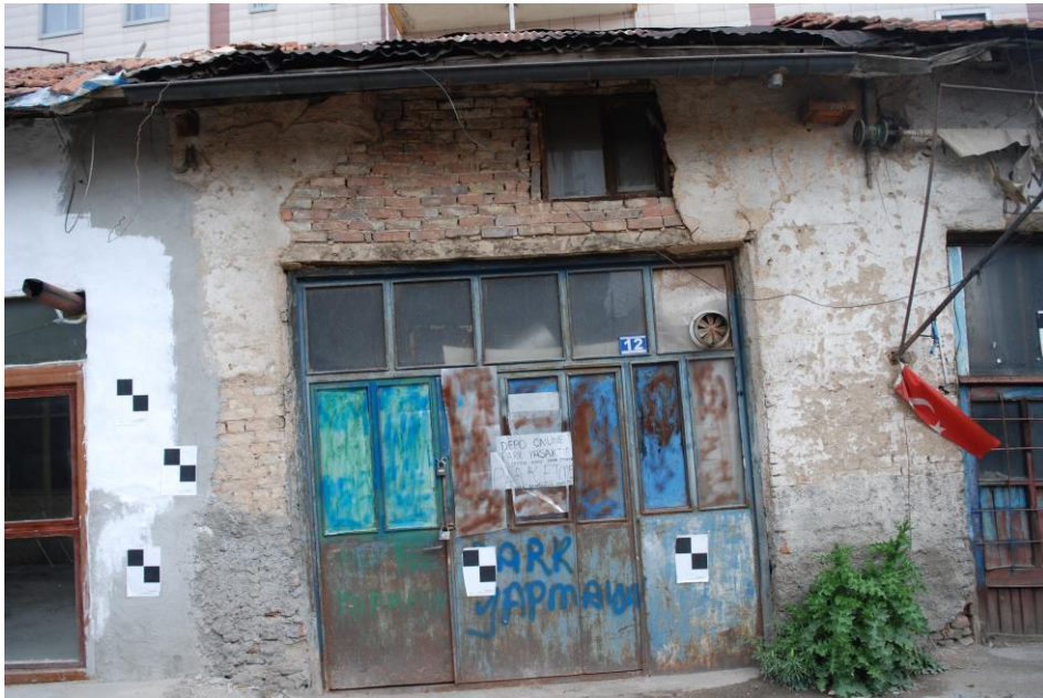
Şekil 5.11. Gevraki Han Dükkan Cepheleri-Giriş Kapıları
