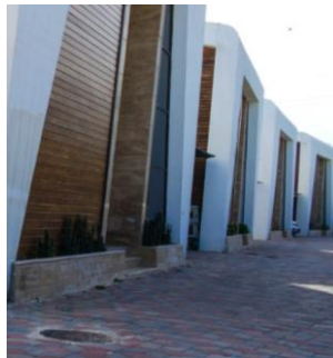
Şekil 4.44. Kuğupark Konakları site içi yolları
