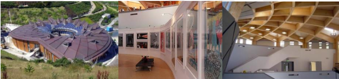
Şekil 2.18. Core Eğitim Binası-Eden (Anonim, 2019)
