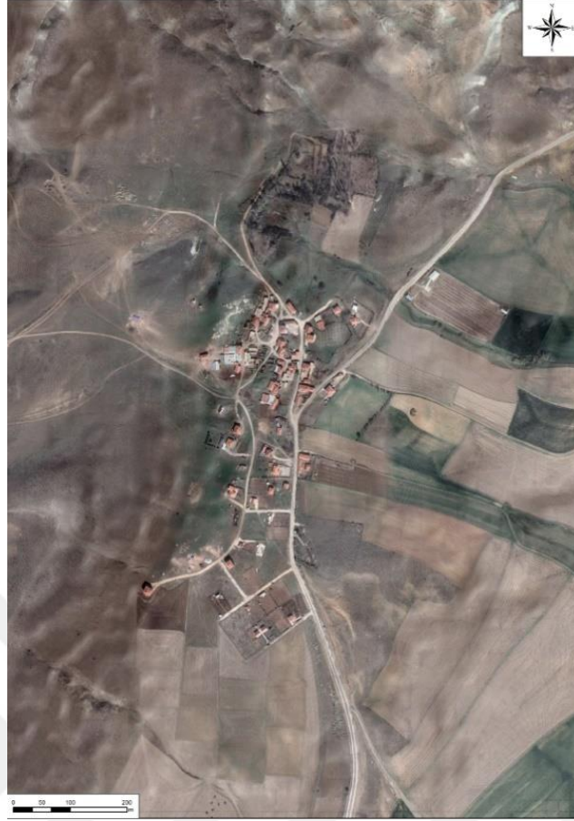
Fotoğraf 4. 39. Yağmurbaba Köyü 2019 Yılına Ait Hava Fotoğrafı, (HGM, (2019)).
