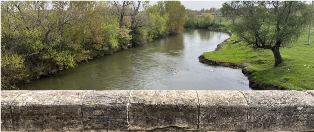
Şekil 5.37. Ergene Nehri Manning pürüzlülüğü için yapılan arazi tarama işlemi: Sanat Yapısı-7 / Lüleburgaz yakınları
