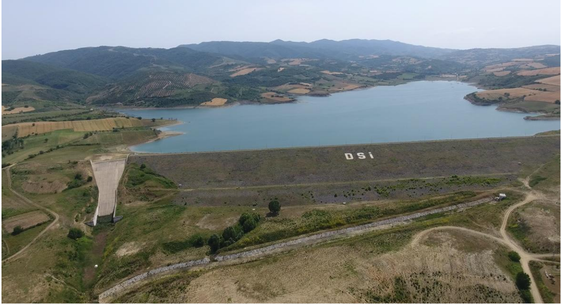
Şekil 6.88. Taşkından koruma faydası olan baraj örneği: Naipköy Barajı
