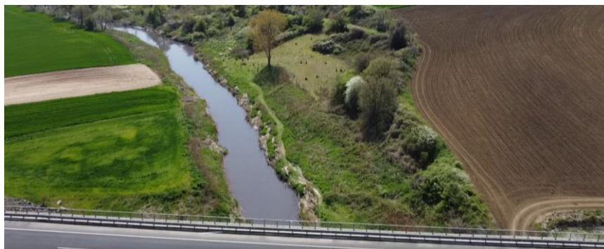
Şekil 5.34. Ergene Nehri Manning pürüzlülüğü için yapılan arazi tarama işlemi: Sanat Yapısı-4 / Karamusul civarı (Drone fotoğrafı)
