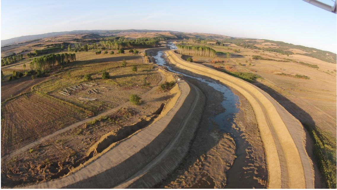
Şekil 2.2. Q10 (kil) seddesi imalatı (Edirne İli, Keşan İlçesi dolayları)
