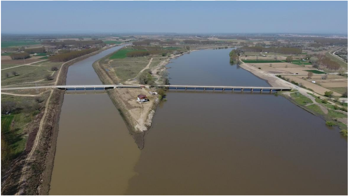
Şekil 6.87. Taşkın kanalı örneği; Kanal Edirne (Drone fotoğrafı)
