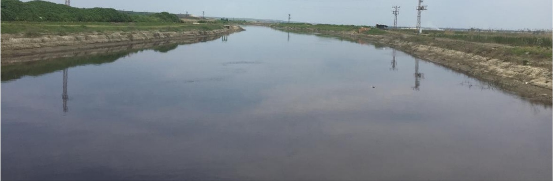
Şekil 5.44. Ergene Nehri Manning pürüzlülüğü için yapılan arazi tarama işlemi: Sanat Yapısı-17 / Hayrabolu-Pehlivanköy İlçe, Tekirdağ-Kırklareli İl Sınırı
