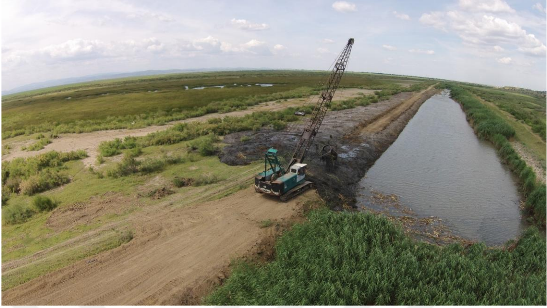
Şekil 2.1. Kırkkavak Deresi'nde rüsubat kontrolü, yatak temizliği
