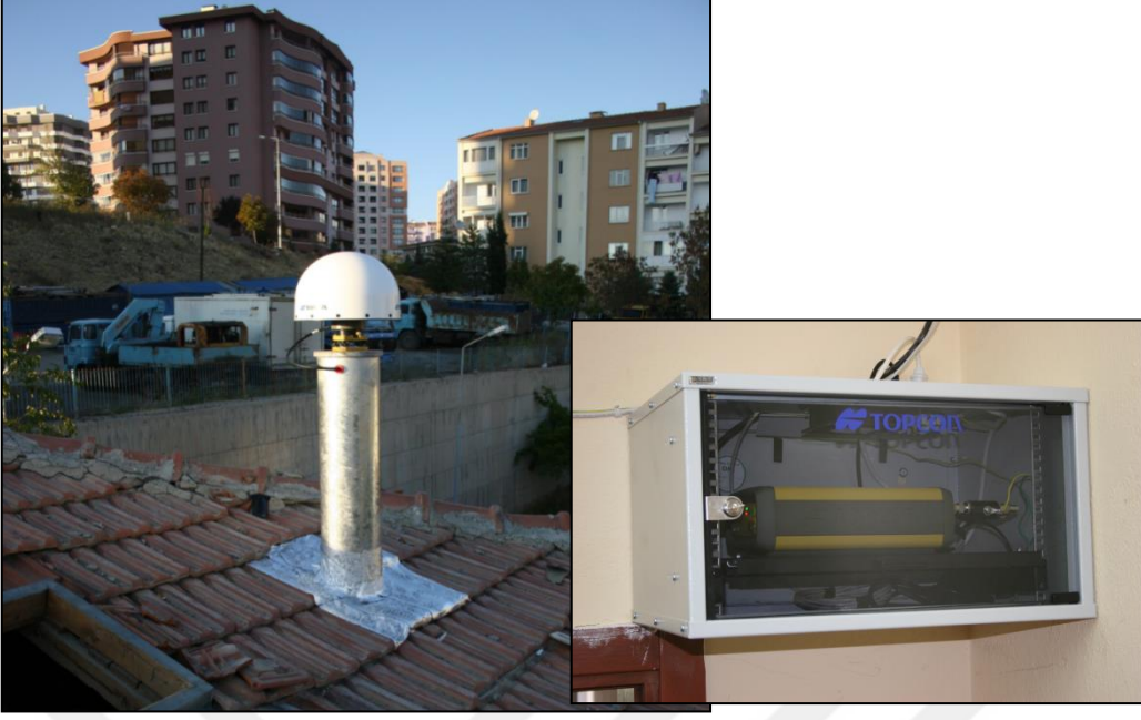
Şekil 4.1. Çayyolu Sabit İstasyonu Ümitköy ASKİ Şube Binası - 2008
