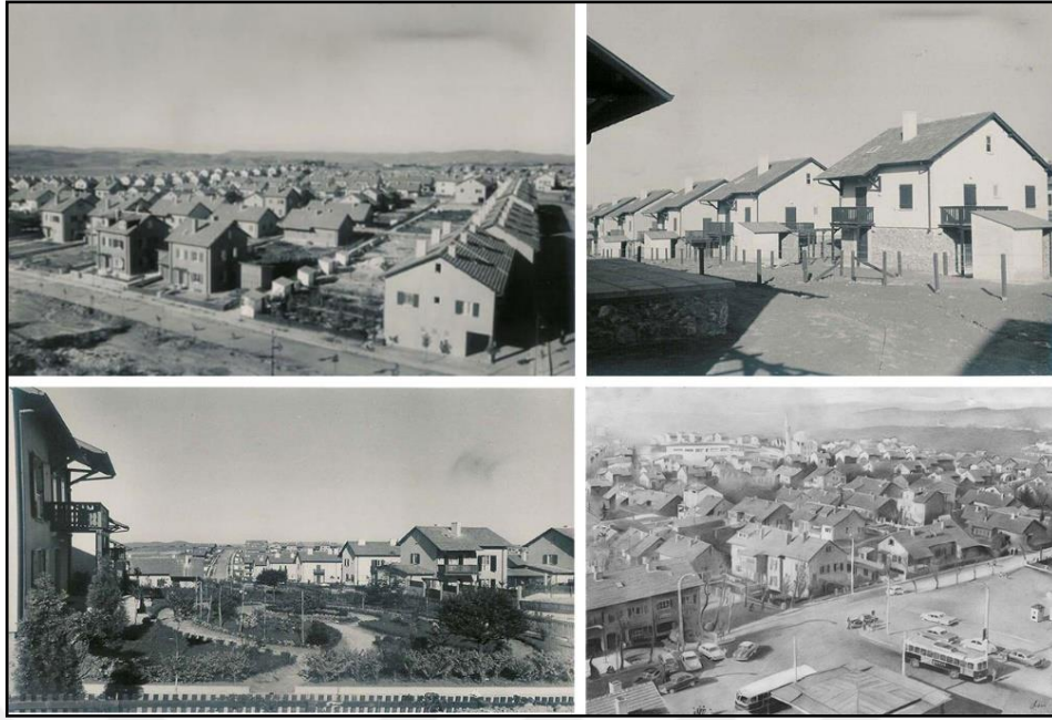
Şekil 2.19. Levent Mahallesi sosyal konutlarına ait görüşler (URL12)
