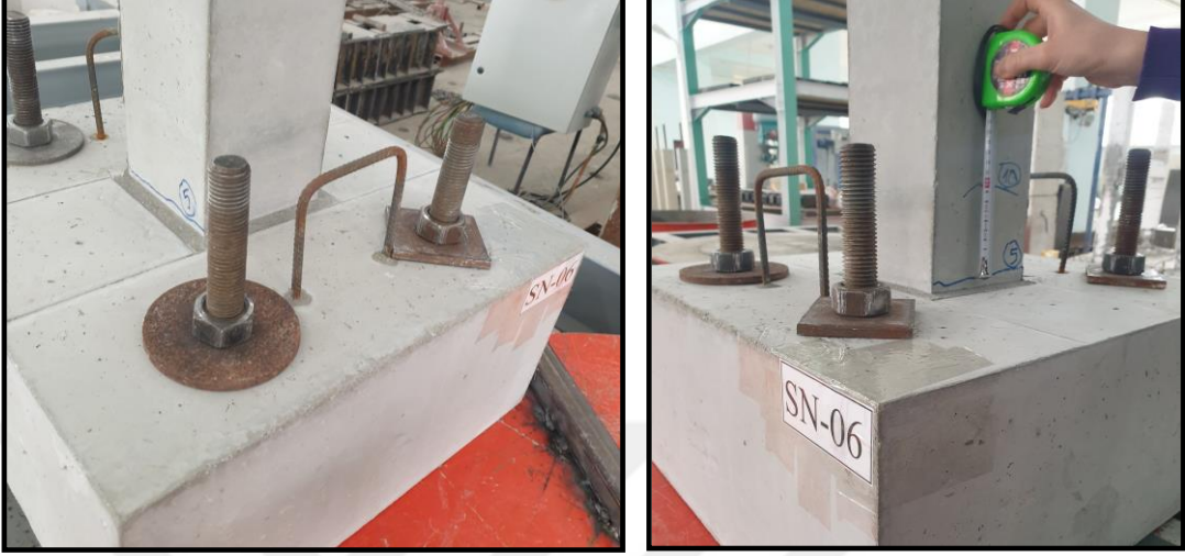
Şekil 6. 16 SN-06 numunesinde oluşan mikro çatlaklar
