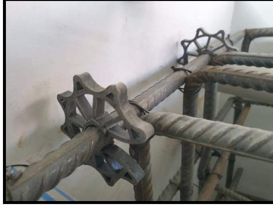
Şekil 5. 24 Kalıp ve demir arasında paspayı bırakılması
