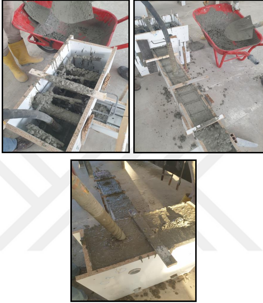
Şekil 5. 42 Betonun vibratör yardımı ile düzgün şekilde yerleşimi
