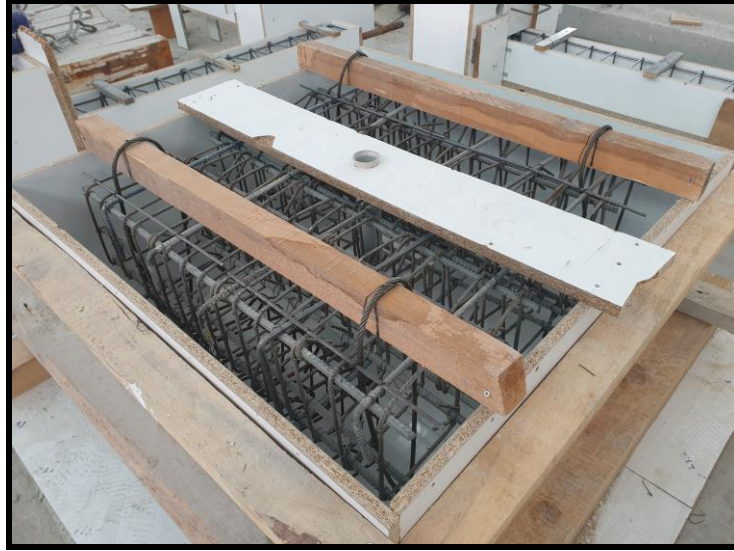
Şekil 5. 27 Kütlenin beton dökümü için hazır görünüşü
