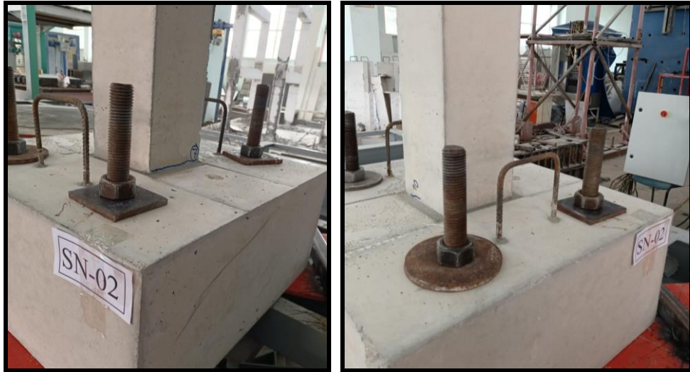
Şekil 6. 7 SN-02 numunesinde 10. Çevrim sonucu oluşan mikro çatlaklar
