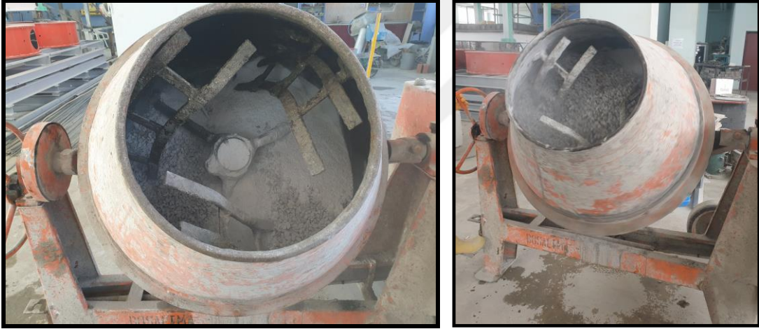
Şekil 5. 40 Betoniyerde 5 farklı beton karışımının yapılması
