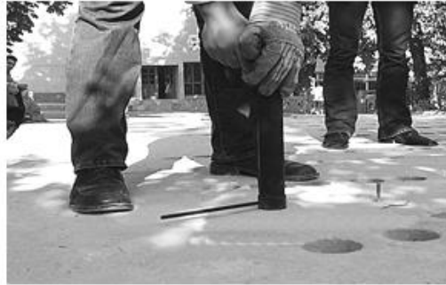
Şekil 3. 3 Penetrasyon deneyinin uygulanması (Erdal ve Şimşek,2006)
