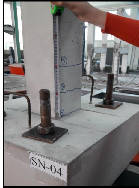
Şekil 6. 11 5. çevrim sonucu etriye yüzeylerinde oluşan kılcal çatlaklar
