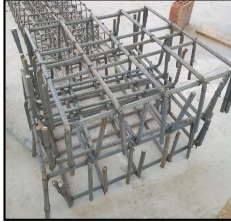
Şekil 5.22 Temel donatılarının birleştirilmiş hali
