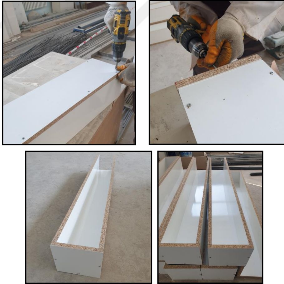
Şekil 5. 14 Kolon kalıplarının çakılması
