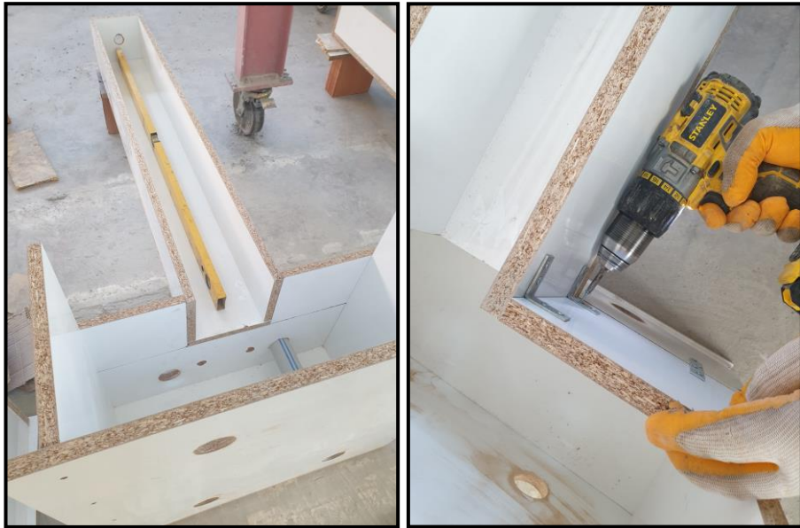
Şekil 5. 19 Su terazisi kullanılarak kalıpların yüzeye paralel olacak şekilde sabitlenmesi
