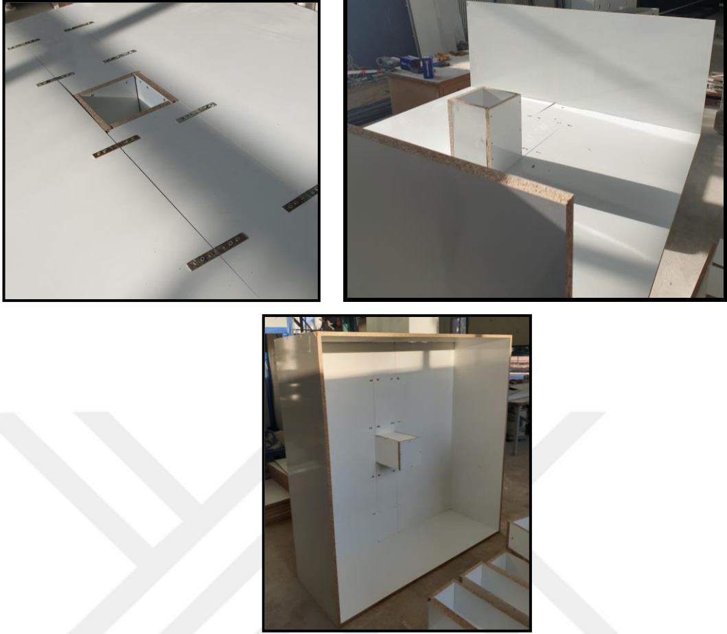
Şekil 5. 18 Beton kütle kalıbının çakılması
