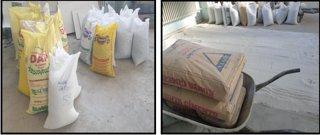
Şekil 5. 39 Beton karışımları için malzemelerin tartılması ve karışıma hazır hale getirilmesi
