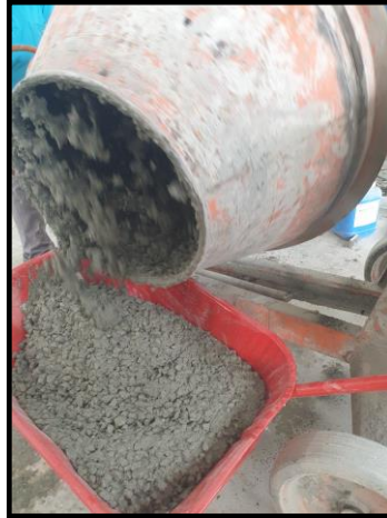
Şekil 5. 41 Homojen karışım elde edilen betonun el arabasına alınması
