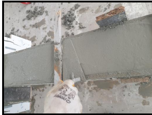
Şekil 5. 43 Mala yardımı ile beton yüzeylerinin düzeltilmesi
