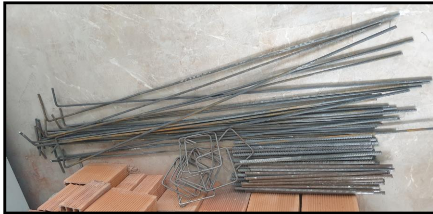
Şekil 5. 21 Hazırlanmış olan boyuna donatılar
