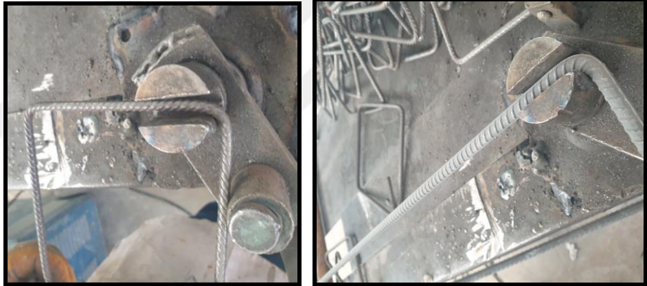
Şekil 5. 20 Donatı ve etriyelerin bükülme işlemleri
