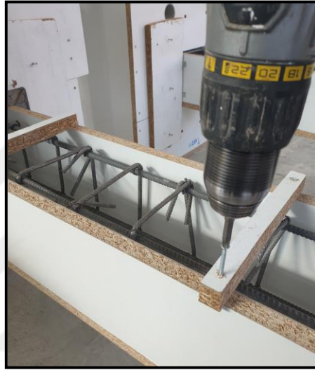
Şekil 5. 25 İnce suntalamlar yardımıyla kalıpların sabitlenmesi
