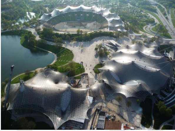
Şekil 2.13. Münih Olimpiyat Stadyumu, çatı strüktürünün görünümü (URL 10)
