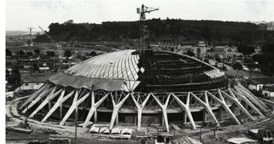
Şekil 2.12. Palazzetto dello Sport'un yapısal strüktürü (URL 9)
