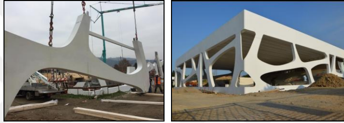
Şekil 2.64. Bergamo Carvico Spor Salonu fotokatalitik prefabrik cephe elemanları montaj aşaması (Grillini, 2020)
