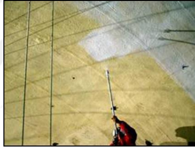
Şekil 2.31. Çimento esaslı fotokatalitik boya ile püskürtmeli uygulama yöntemi (Guerrini, 2012)
