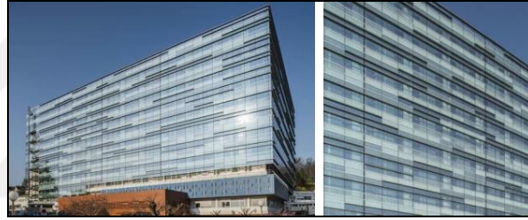
Şekil 2.13. Yenileme çalışmalarından sonra Brive-la-Gaillarde Hastanesi (Ćurćić, 2018)
