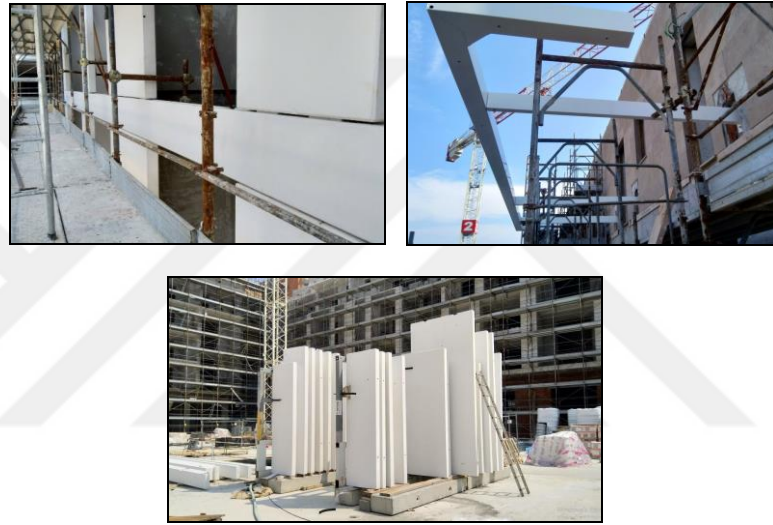
Şekil 2.61. NövAmpère Konut Projesi fotokatalitik cephe panelleri montaj aşaması (Dalila ve Ingeino, 2020)
