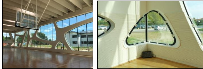
Şekil 2.65. Bergamo Carvico Spor Salonu fotokatalitik prefabrik cephe elemanları uygulama sonrası (Grillini, 2020)
