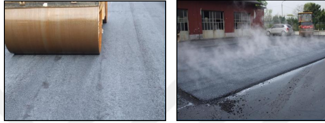
Şekil 2.18. TiO_2 sıcak uygulama (Crispino, 2010)
