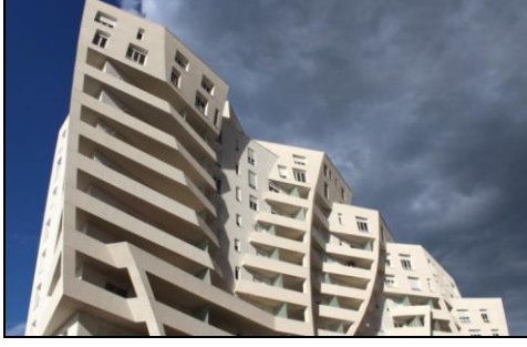
Şekil 2.72. Magnet Konut Merkezi (HeidelbergCement Group, 2022a)
