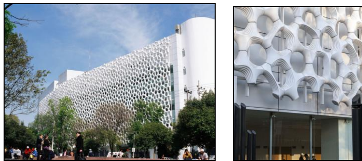
Şekil 2.17. Manuel Gea Gonzalez Hastanesi ve cephe modülleri (Prosolve370e, 2022)
