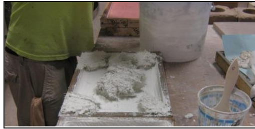
Şekil 2.37. GRC numunenin ikinci katmanının yerleştirilmesi
