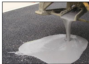
Şekil 2.29. TiO_2 karıştırılmış çimento harcının ve asfalt tabakaya dökümü (Crispino, 2010)
