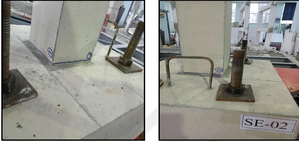
Şekil 6.9. SE-02 deney numunesinde test sonucunda oluşan çatlaklar
