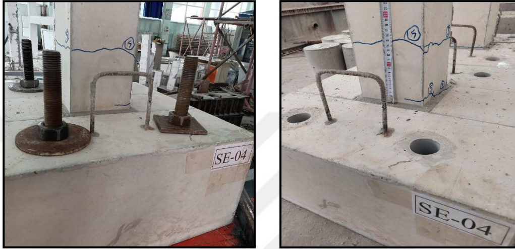
Şekil 6.23. SE-04 deney numunesinde test sonucunda oluşan çatlaklar
