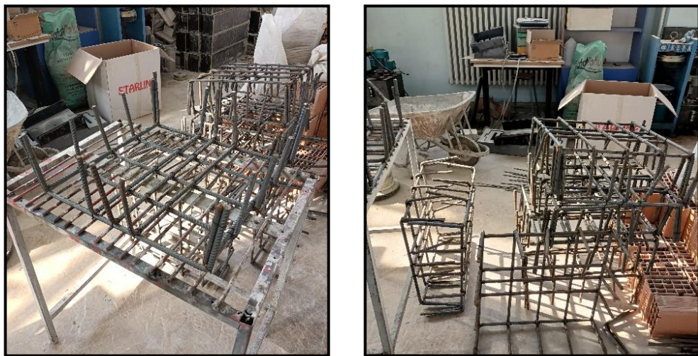
Şekil 5.12. Nervürlü ve nervürsüz temel donatıları
