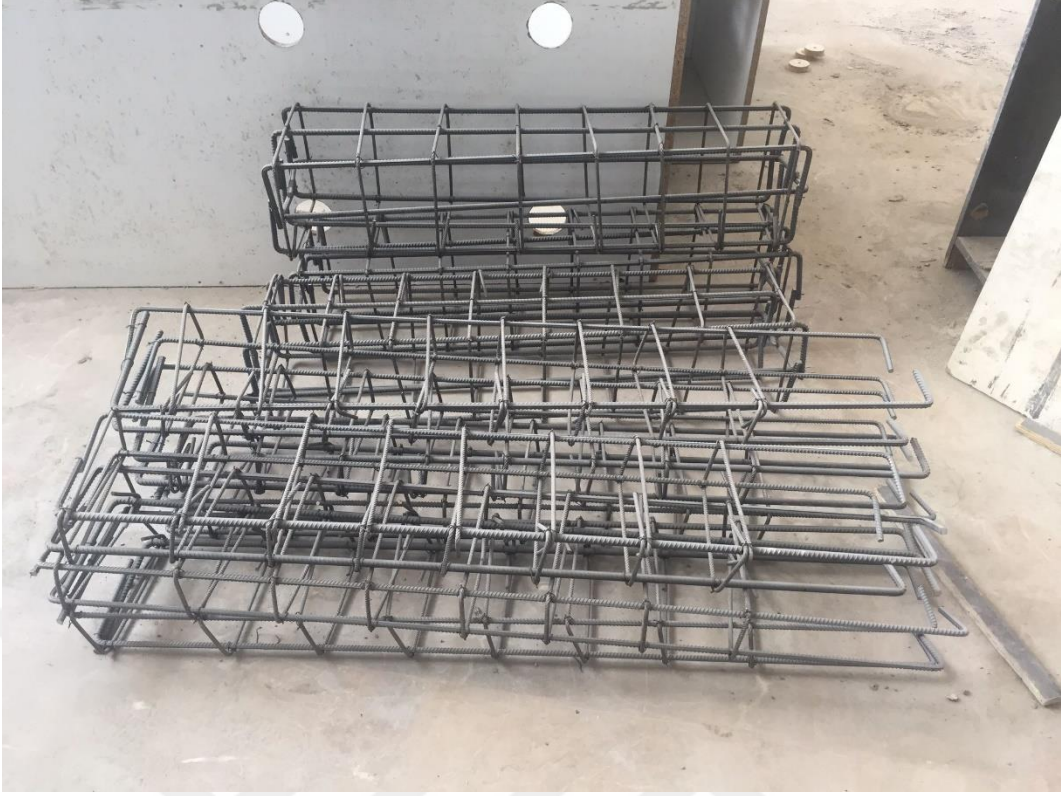
Şekil 3.11. Kolon ve kiriş donatılarının hazırlanması
