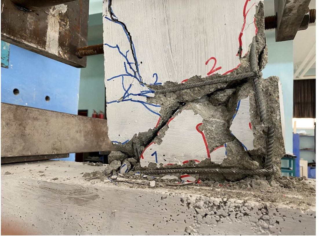
Şekil 4.13. Kirişin sağ kısmında donatı kopması
