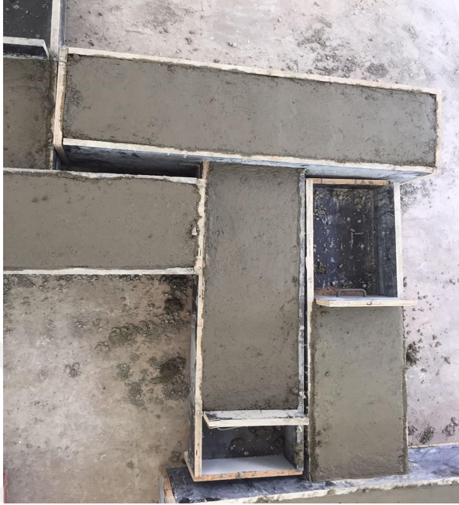
Şekil 3.15. Beton kalıplara yerleştirilmesi
