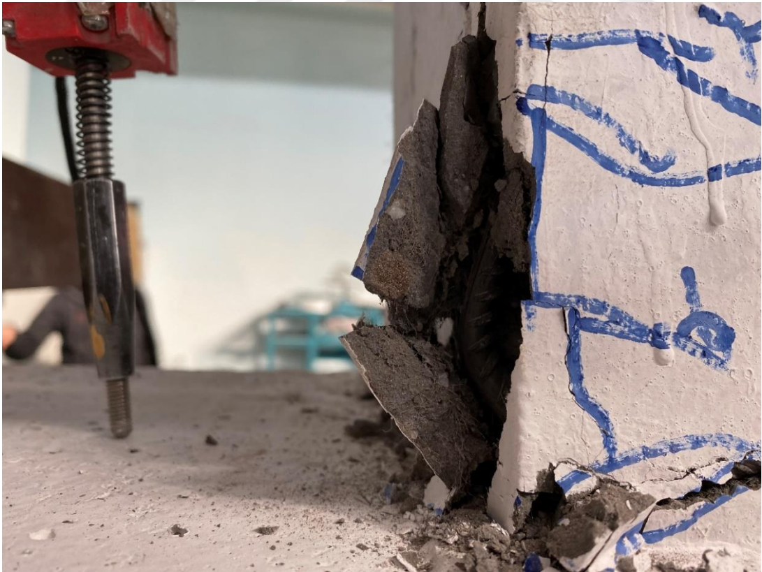
Şekil 4.66. AD2-ECC1-R1 elemanın deney sonundaki hasarları
