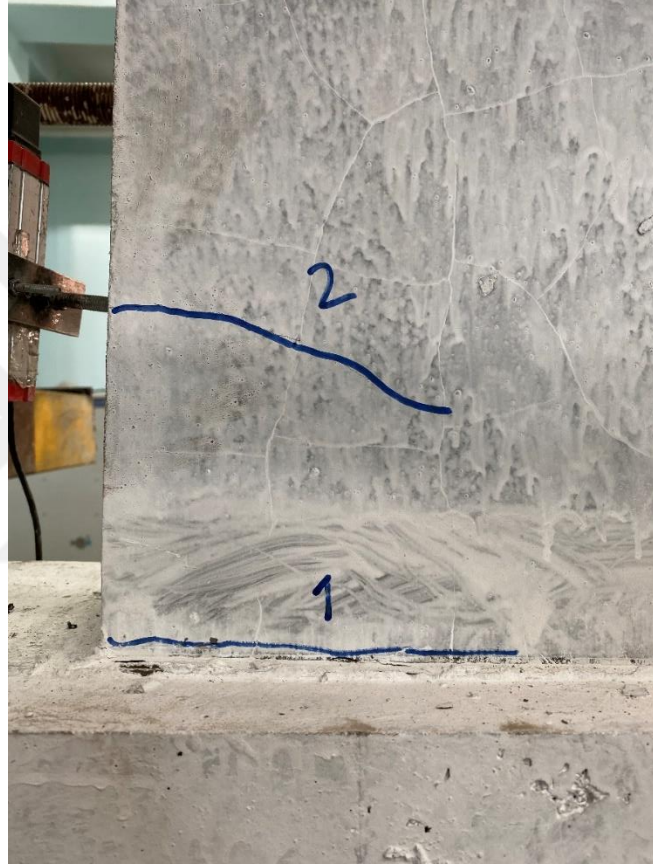
Şekil 4.38. AD2-ECC1-R0 deney elemanında oluşan ilk çatlaklar
