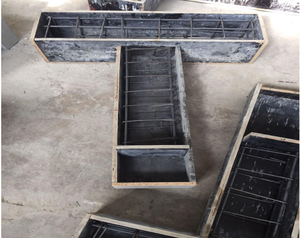
Şekil 3.12. Kolon ve kiriş donatılarının kalıplara yerleştirilmesi
