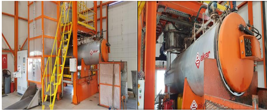
Şekil 4.10. Tıbbi atık sterilizasyon tesisi üniteleri (Anonim, 2021)
