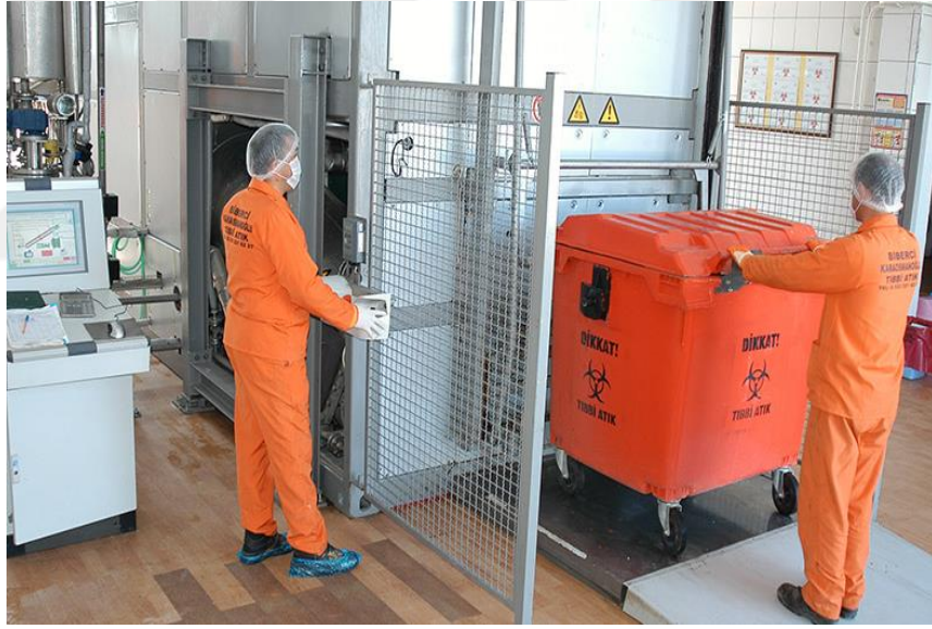
Şekil 4.4. Tıbbi atık sterilizasyon tesisi konteyner örneği (Biberici, 2017)
