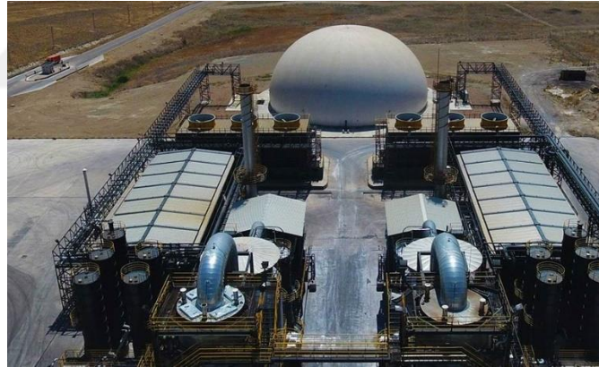
Şekil 4.12. Ankara yakma tesisi genel görünüm (Itc, 2020)
