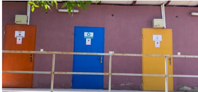
Şekil 4.16. Tehlikeli atık, evsel atık ve tıbbi atık geçici deposu
