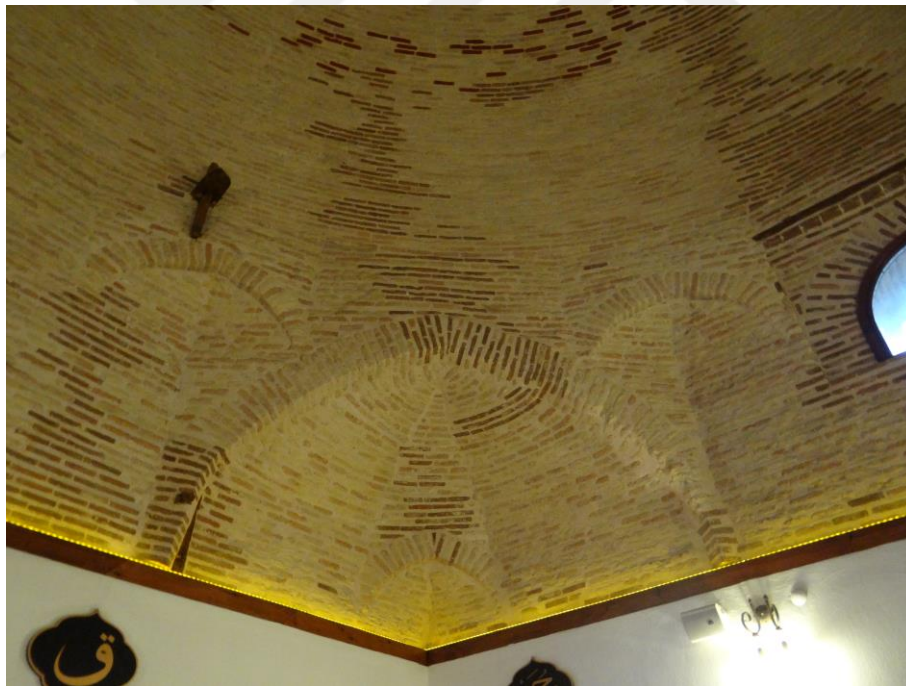
Şekil 5.5. Kubbeye geçişi sağlayan tonoz bingiler
