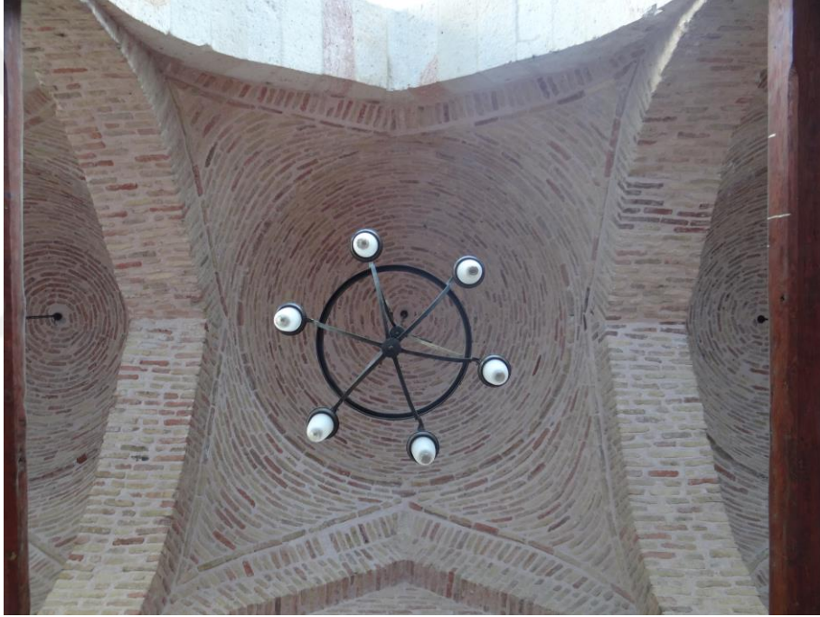
Şekil 5.11. Son cemaat mahfilinde ortada bulunan kubbe, pandantif ve kemerler
