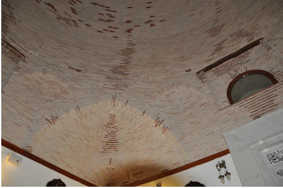
Şekil 5.21. Tromp ve trompçuklardaki tuğla dokusu
