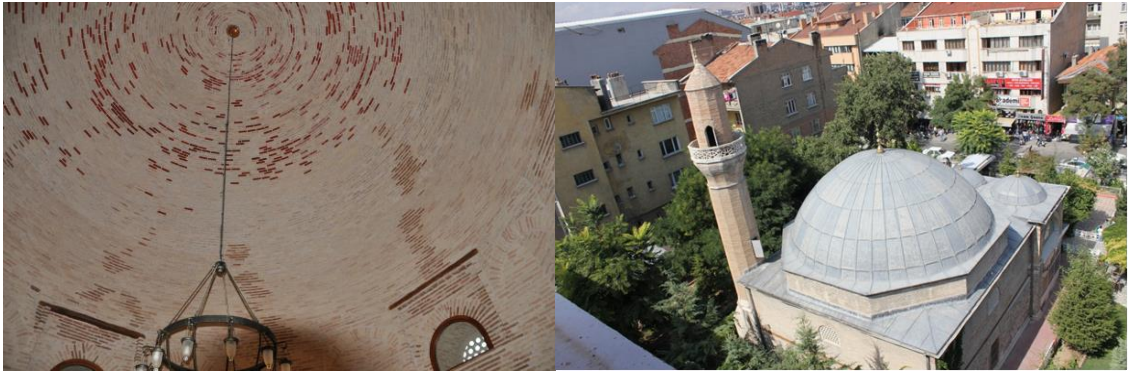
Şekil 5.10. Kubbenin içten ve dıştan görünüşü (Art & Dem Mimarlık, 2012b)
