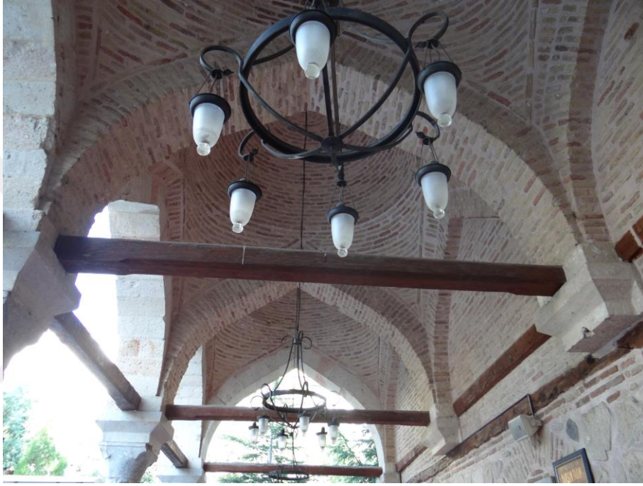
Şekil 5.45. Son cemaat mahfili ve giriş cephesinde bulunan güçlendirme elemanları
