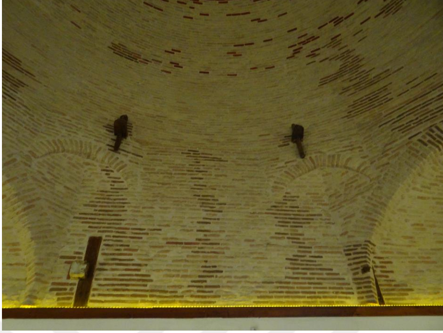
Şekil 5.46. Giriş kapısı üzerinde yer alan ve son cemaat mahfilini cami duvarına sabitleyen ahşap elemanlar
