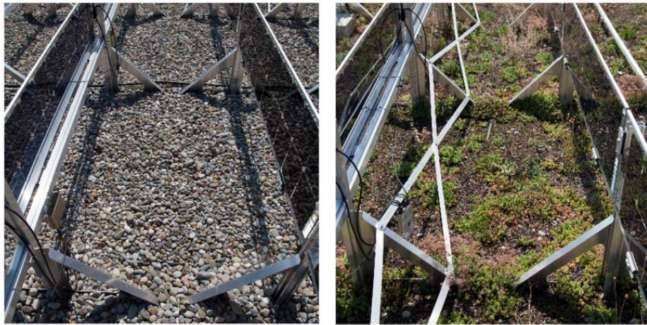
Şekil 2.7. Çatıdaki fotovoltaik panellerin zeminleri (Baumann ve ark. 2019)
