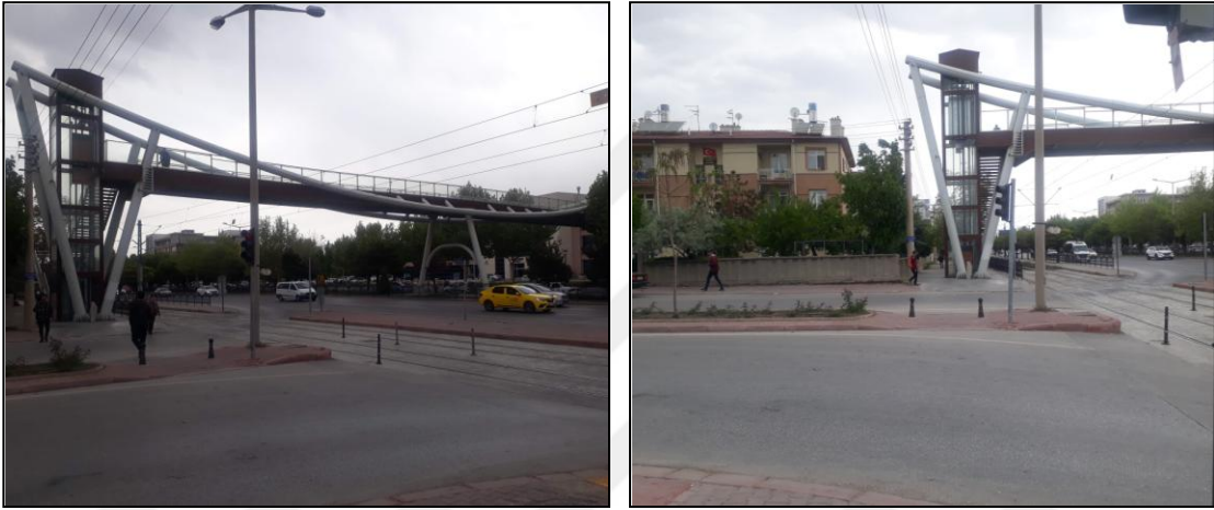
Şekil 4.51. Binkonutlar Mahallesi YÜG2 noktasında bulunan yaya üst geçidi (Kişisel arşiv, 2022).
