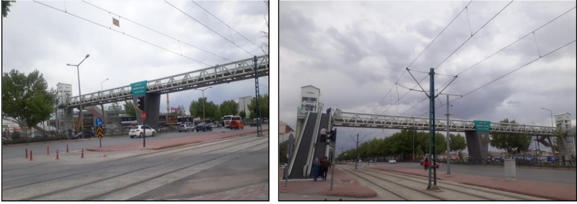
Şekil 4.50. Binkonutlar Mahallesi YÜG1 noktasında bulunan yaya üst geçidi (Kişisel arşiv, 2022).
