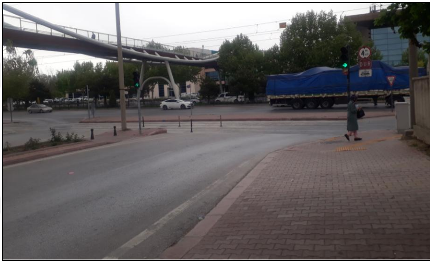
Şekil 4.44. Binkonutlar Mahallesi YG5 noktasında bulunan yaya geçidi (Kişisel arşiv, 2022).
