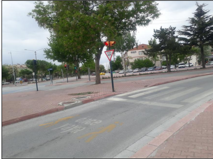
Şekil 4.46. Binkonutlar Mahallesi YG6 noktasında bulunan yaya geçidi (Kişisel arşiv, 2022)
