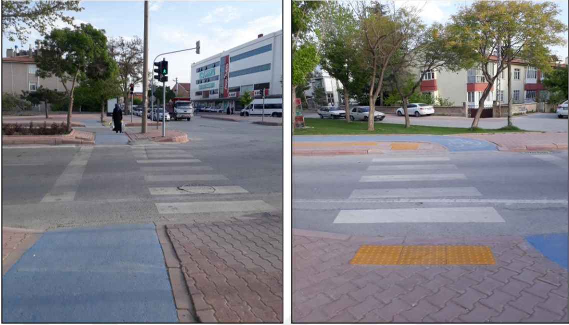
Şekil 4.47. Binkonutlar Mahallesi YG7 noktasında bulunan yaya geçidi (Kişisel arşiv, 2022).
