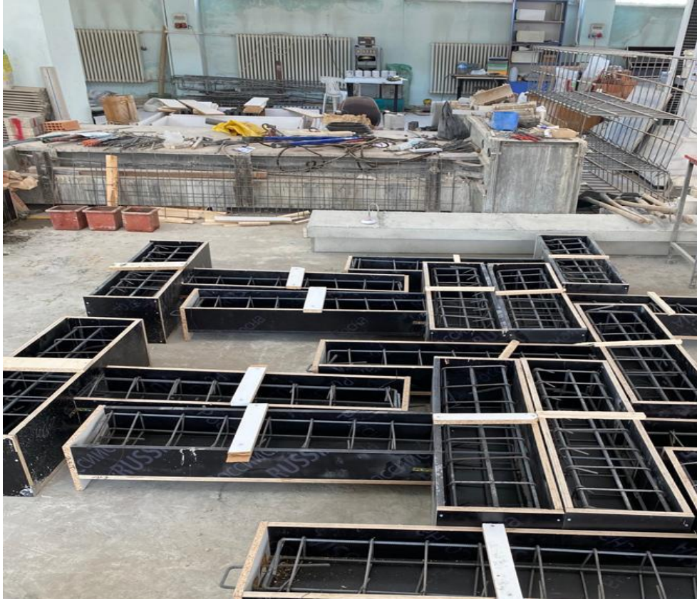
Şekil 3.9. Beton dökümüne hazır konsol kiriş kalıpları
