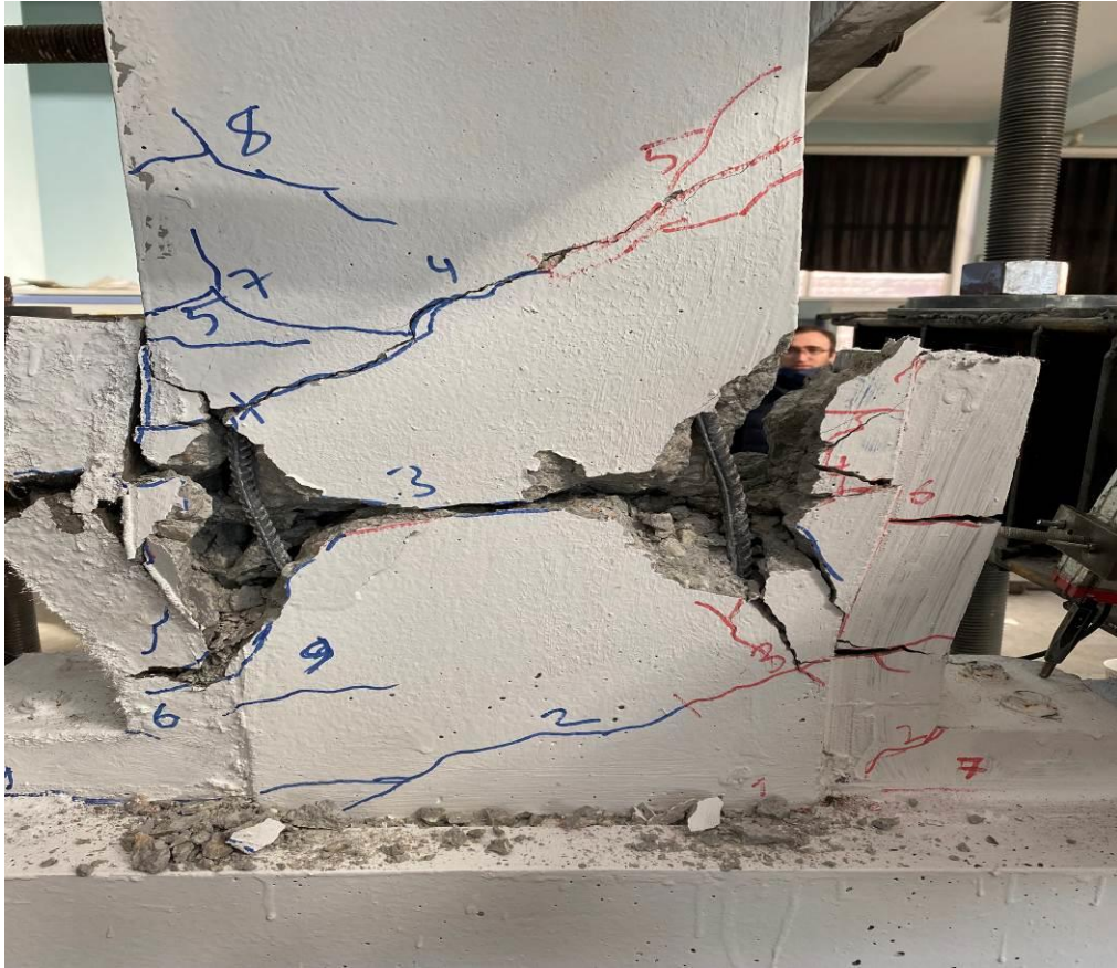
Şekil 4.28. RB-LDB1-SEW elemanın deney sonundaki çatlak dağılımı
