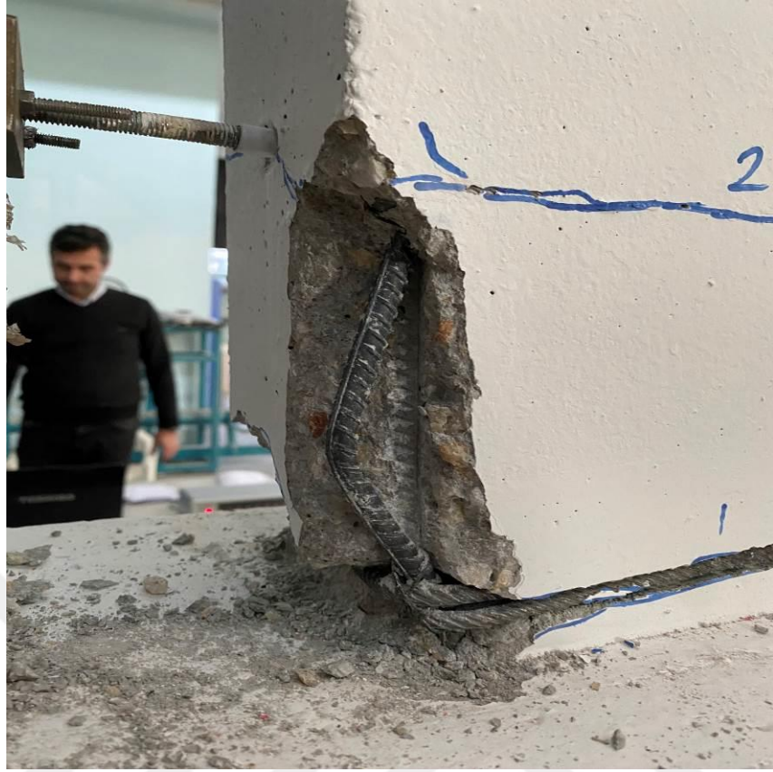
Şekil 4.36. RB-LDB1-LE deney elemanında meydana gelen donatı burkulması
