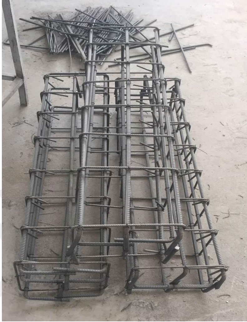
Şekil 3.7. Üretilmiş kiriş donatıları
