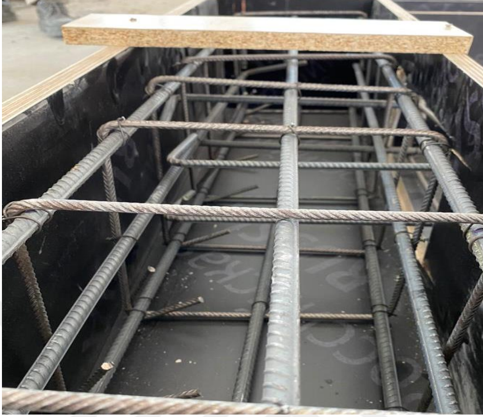
Şekil 3.8. Kalıba yerleştirilmiş donatı
