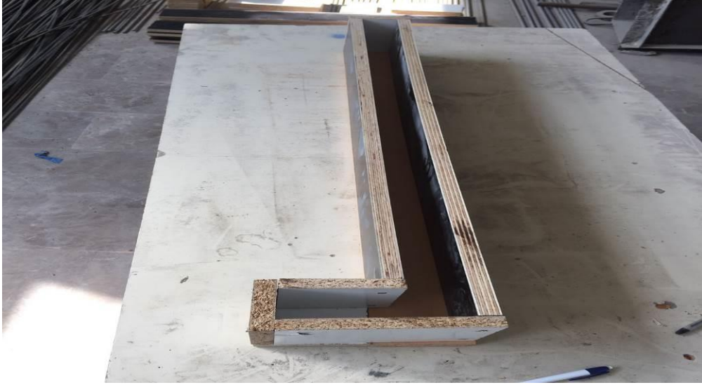
Şekil 3.11 Güçlendirme elemanları için üretilen kalıplar
