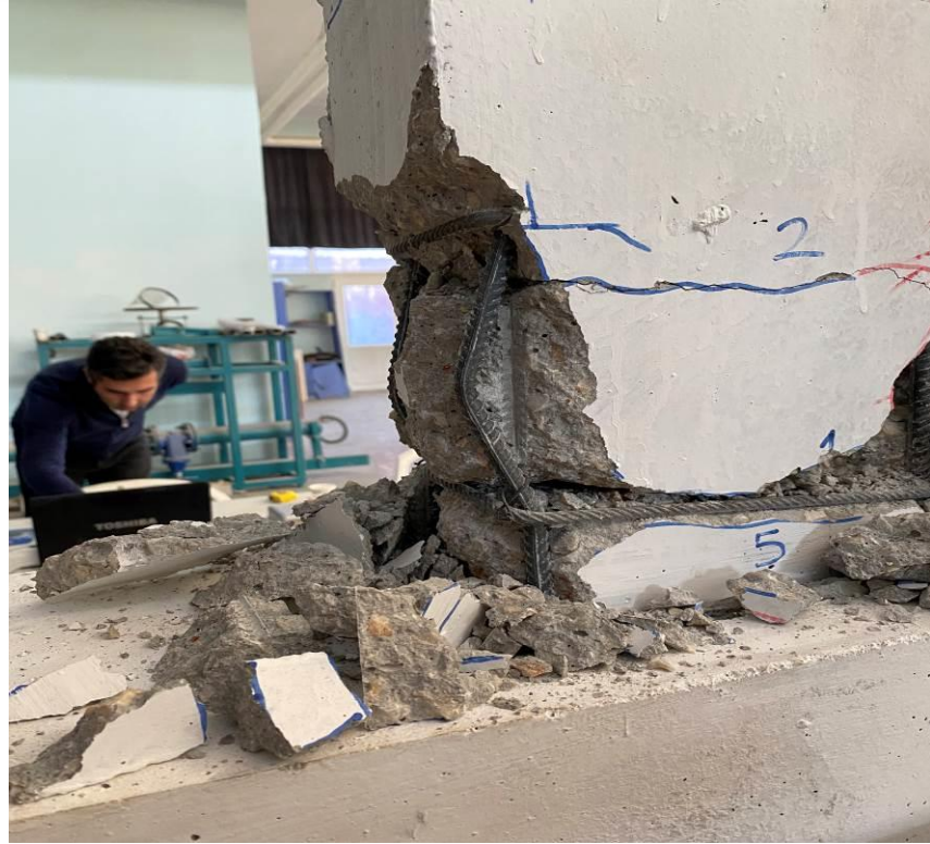
Şekil 4.56. RB- LDB2-SE deney elemanında donatı burkulma
