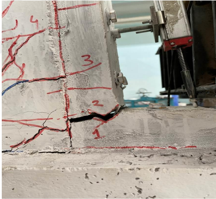
Şekil 4.54. RB- LDB2-SE deney elemanında kullanılan panelde oluşan ayrılma
