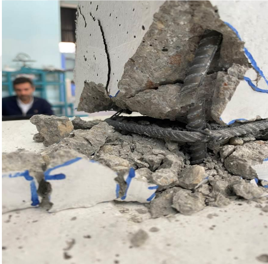
Şekil 4.78. RB- LDB2-LE deney elemanında meydana gelen donatı kopması
