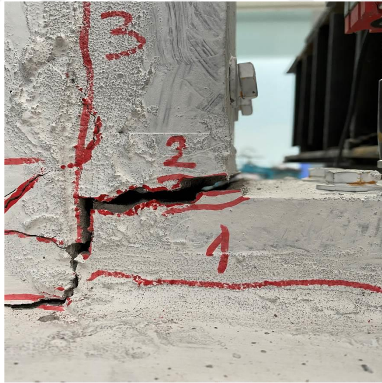
Şekil 4.77. RB- LDB2-LE deney elemanında güçlendirme panelin birleşim yerinde oluşan ciddi hasarlar
