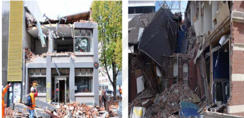
Şekil 3.12. Farklı kütleli çekiçleme etkiyle ciddi hasar almış bir işyeri ve konut (Cole ve ark., 2012)
