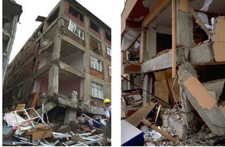
Şekil 3.25. 1999 Kocaeli depreminde zayıf kolon güçlü kiriş tasarımı sonucu yıkılan bina örnekleri (Sezen ve ark, 2000)
