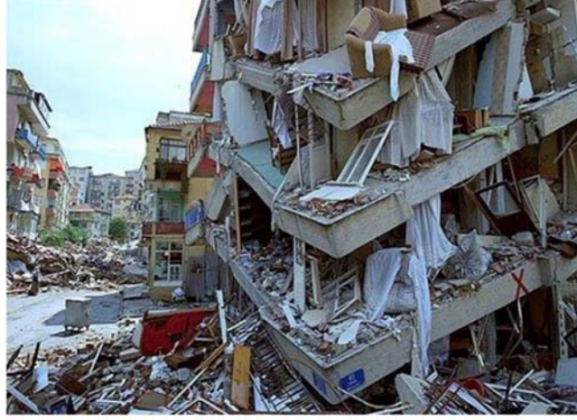
Şekil 3.6. Planda çıkıntı düzensizliği sonucu çöken bir bina (Atabey, 2022)
