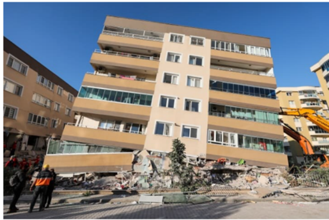
Şekil 3.23. 2020 İzmir depreminde zeminde farklı oturma ve yumuşak kat sorunu yaşayan bir bina (Anonim, 2022)
