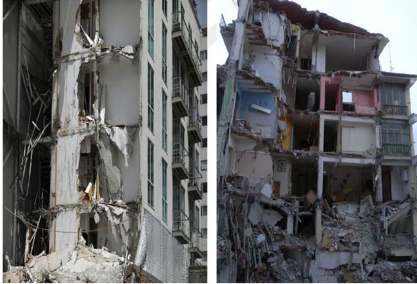
Şekil 3.5. (a) 2017 Meksika depreminde görülen döşeme hasarı (Burke, 2017) (b) 2009 İtalya L'aquila depreminde meydana gelen döşeme hasarı (Lauro, 2009)
