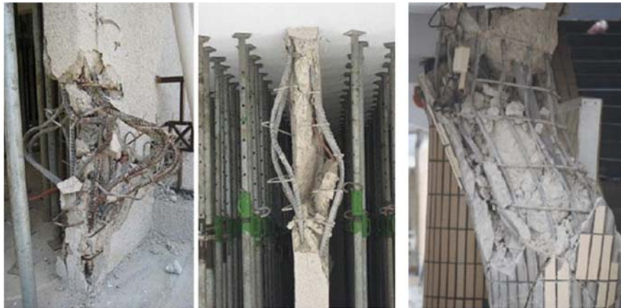
Şekil 3.14. 2010 Şili depreminde yaşanan burkulma hasarları (Harris ve ark., 2011)
