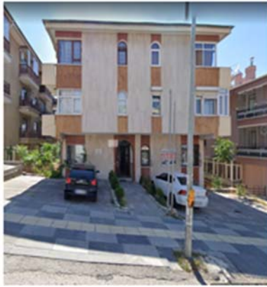
Zemin Eđim Durumu Var
