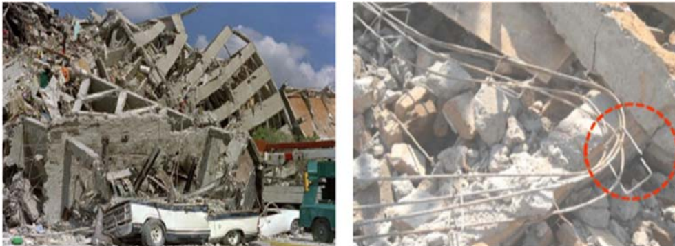
Şekil 3.19. 1985 Meksika depreminde meydana gelen yapı malzemesi kaynaklı hasarlar (Adler, 2015)
