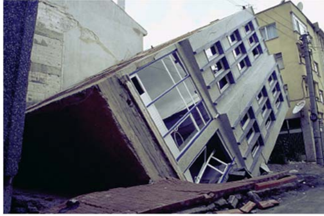
Şekil 3.22. Zemin sıvılaşması problemi sonucu devrilen bir bina (Sezen ve ark, 2000)
