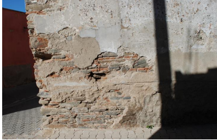
Şekil 4.48. Z0-4 Oda Kuzey Cephe
