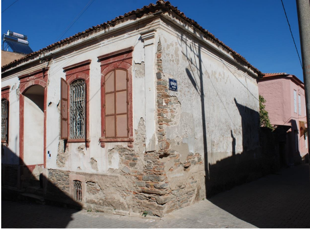
Şekil 4.40. Ahmet Şener Evi Güney Cephesi Genel Görünüm
