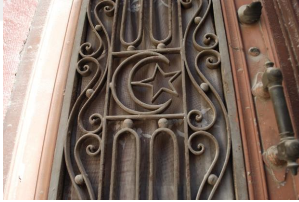
Şekil 4.52. Giriş Kapısı Metal Parmaklık Görünümü
