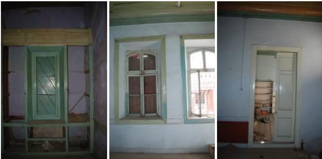
Şekil 4.49. Ahmet Şener Evi Ahşap Malzeme Kullanımları
