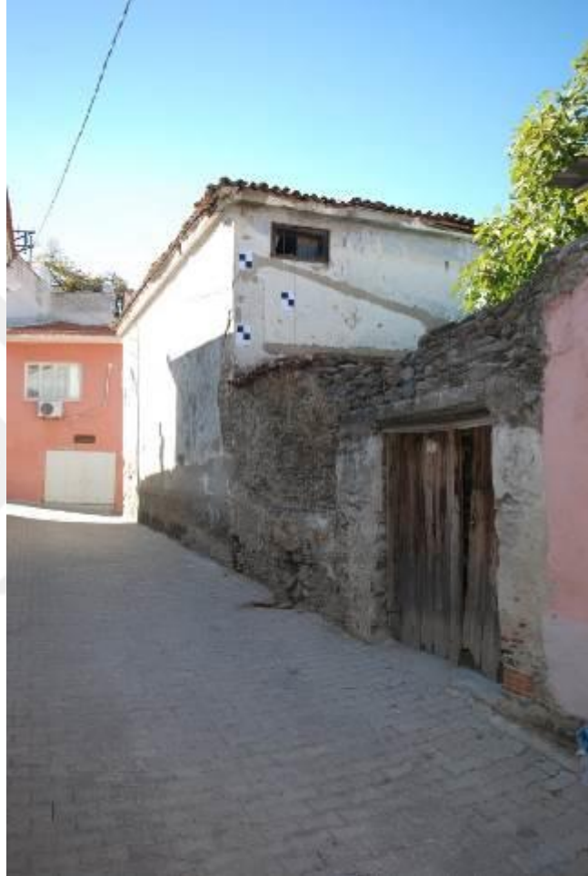
Şekil 4.45. Ahmet Şener Evi Güney Cephesi Avlu Girişi
