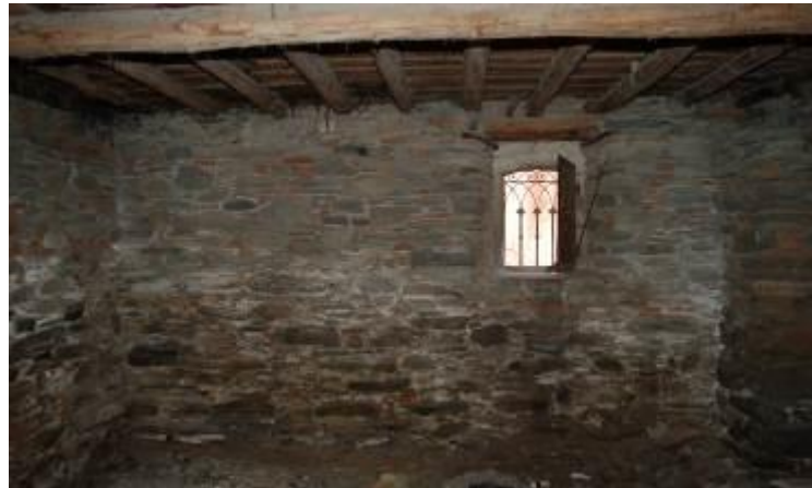
Şekil 4.47. Z0-4 Oda Kuzey Cephe
