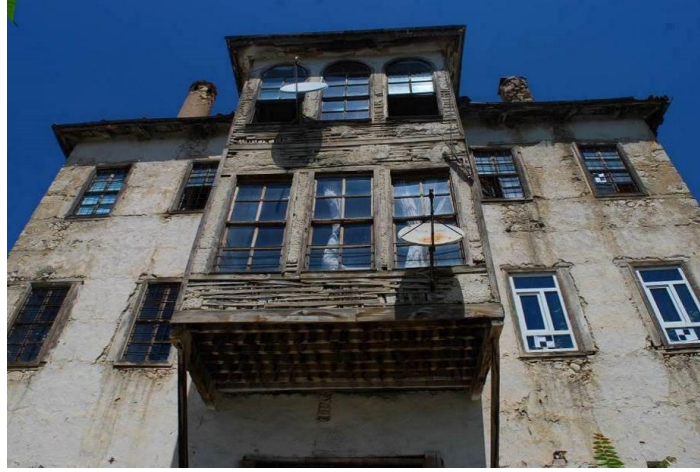
Şekil 4.15. Ayfer Sönmez Evi Güney Cephesi
