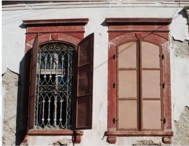
Şekil 4.50. Ahmet Şenel Evi Demir Parmaklık ve Metal Kepenkler
