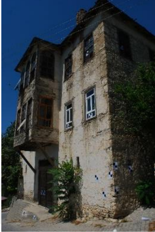
Şekil 4.13. Ayfer Sönmez Evi Genel Görünüm
