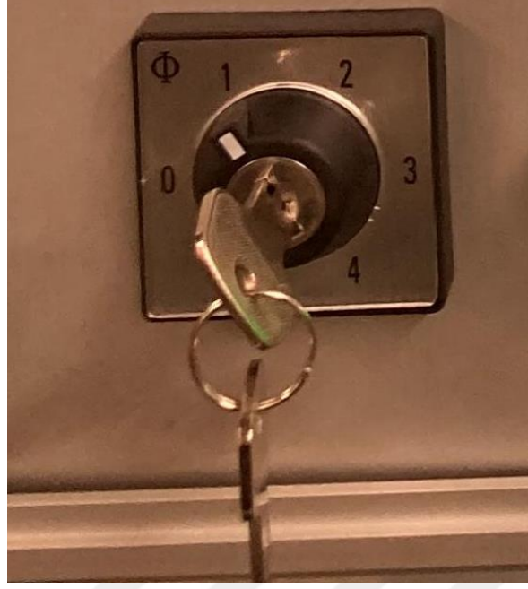
Şekil 6.58 Mod anahtarı
