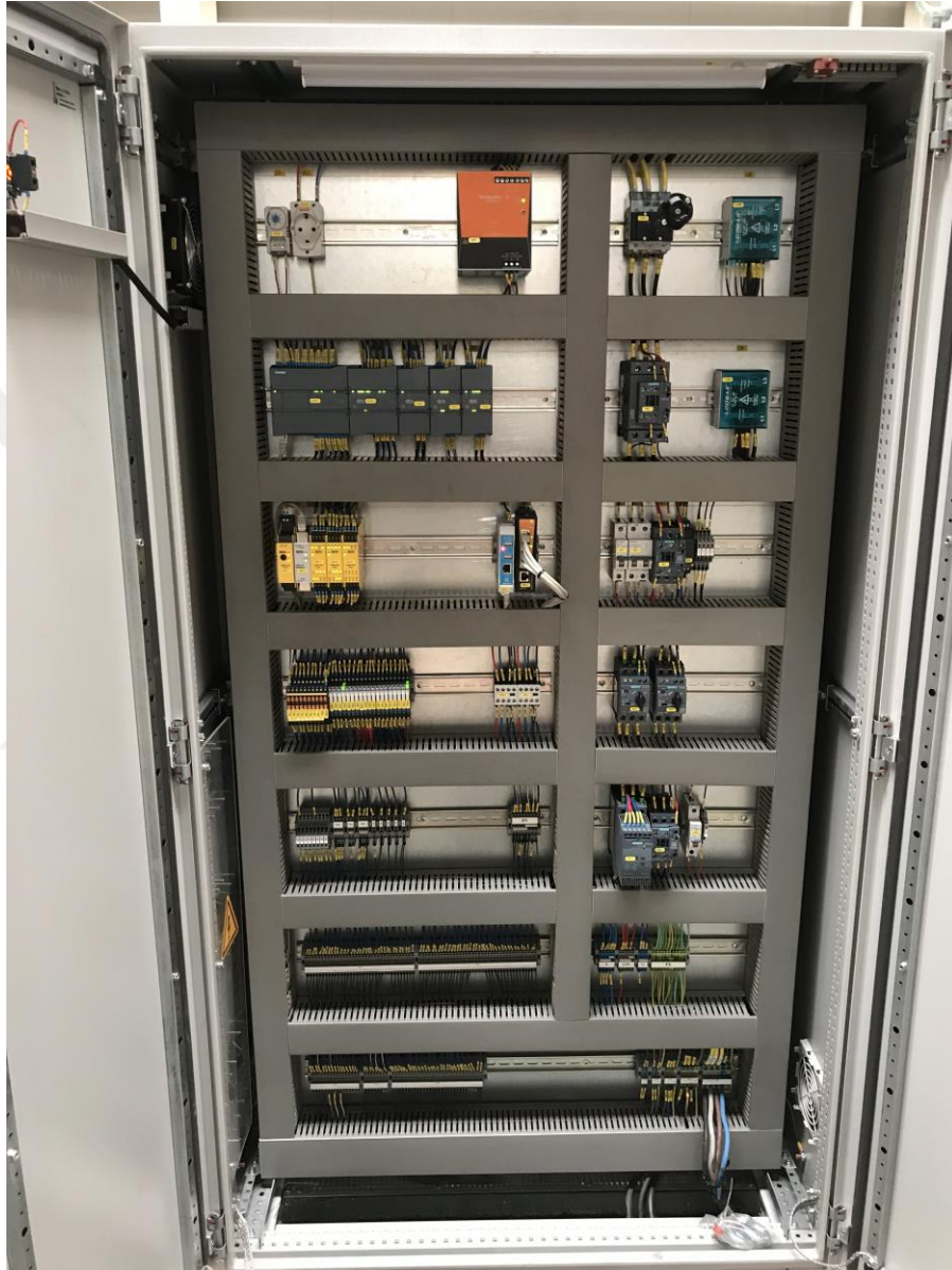
Şekil 4.6. H tipi tek etkili bir presin otomasyon panosu
