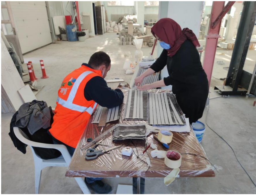
Şekil 3.7. CFRP kumaş kesimi
