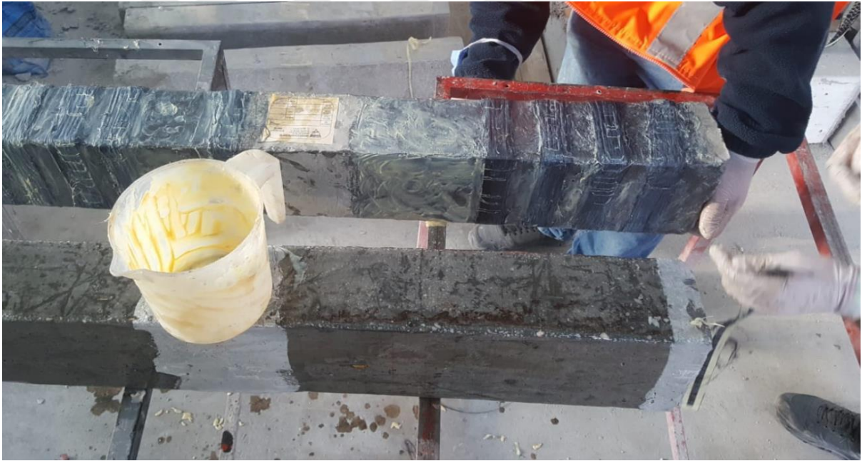
Şekil 3.15. Güçlendirme uygulaması (Tam sargılama)
