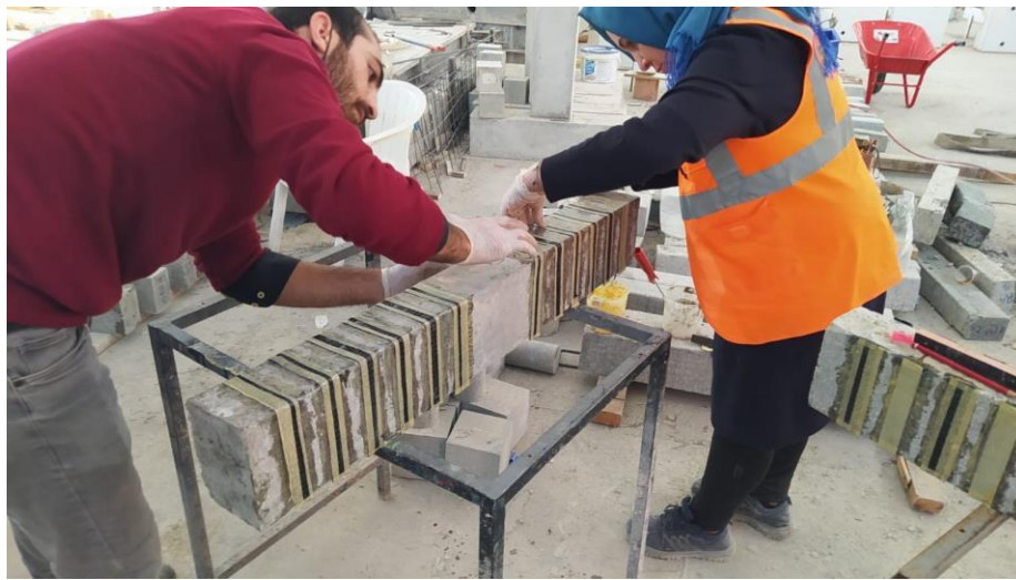
Şekil 3.13. Güçlendirme uygulaması (U tip sargılama)
