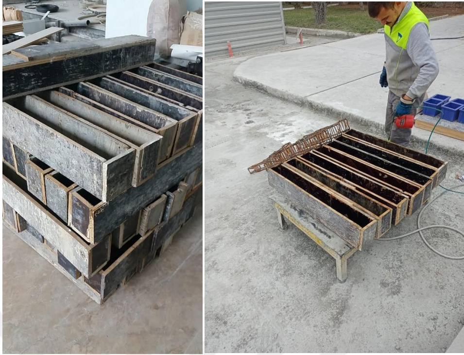
Şekil 3.9. Kiriş numunelerin kalıpları ve beton dökülmeden önce kalıp yağlama işlemi
