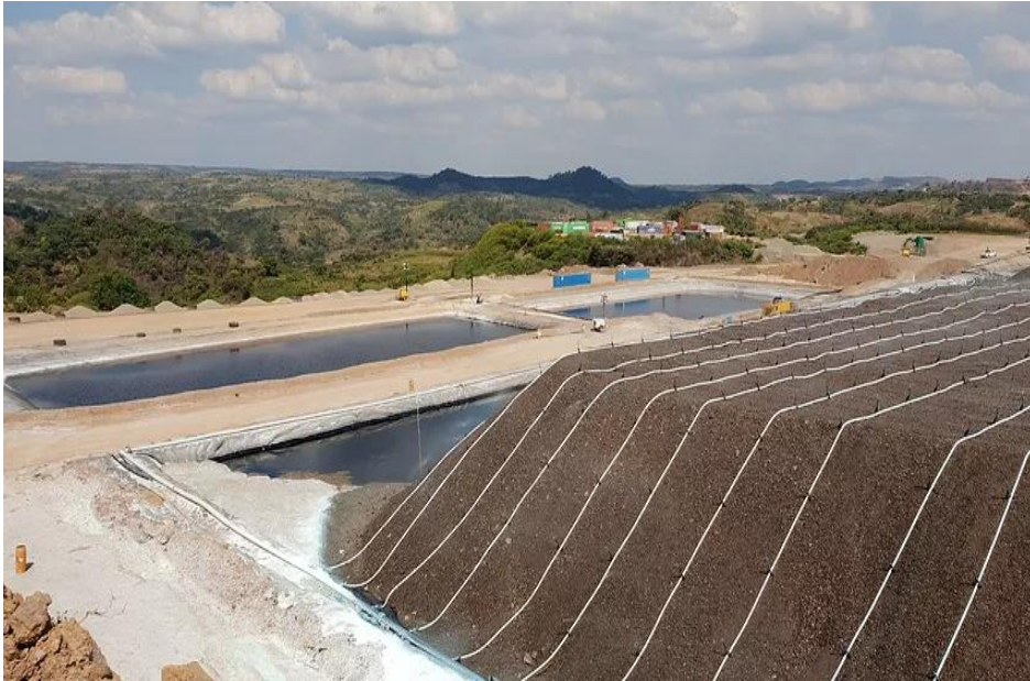
Şekil 2.3. Yığın liçi uygulaması
