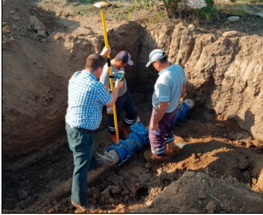
Şekil 4.5. Asat gps ile hat ölçüm çalışması (URL14)
