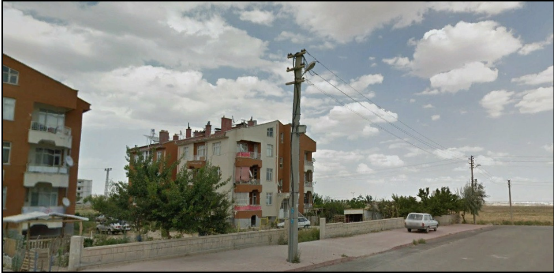
Şekil 5.20. Bir elektrik alçak gerilim hattının görsel olarak sorgulanması
