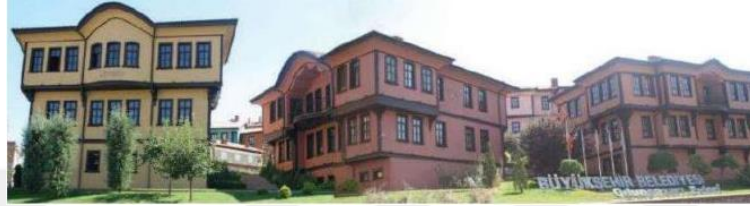
Şekil 4.40. Eskişehir Odunpazarı evlerinin taklidi (Bilgin Altınöz, 2010)
