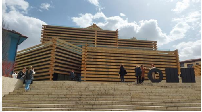
Şekil 4.57. Odunpazarı Modern Müze cephesi
