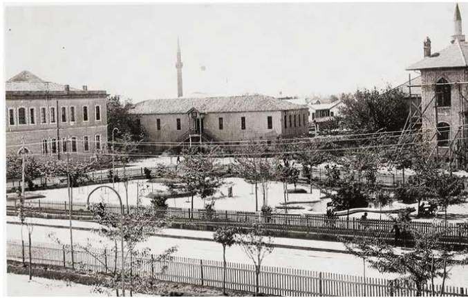
Şekil 3.47. Hükümet binasının güneyindeki Jandarmanın binası, çitlerle çevrili alan Kayalı park 1920'li yıllar (url-85)
