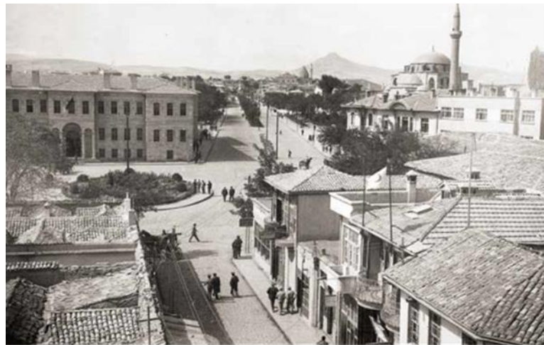
Şekil 3.25. Hükümet meydanı, 1930'lı yıllar, Hükümet binasının doğu ve kuzey doğu tarafı. Doğuda Küçük Bedesten, kuzeydoğuda Uluşahin otelinin bulunduğu bölge (url-68)
