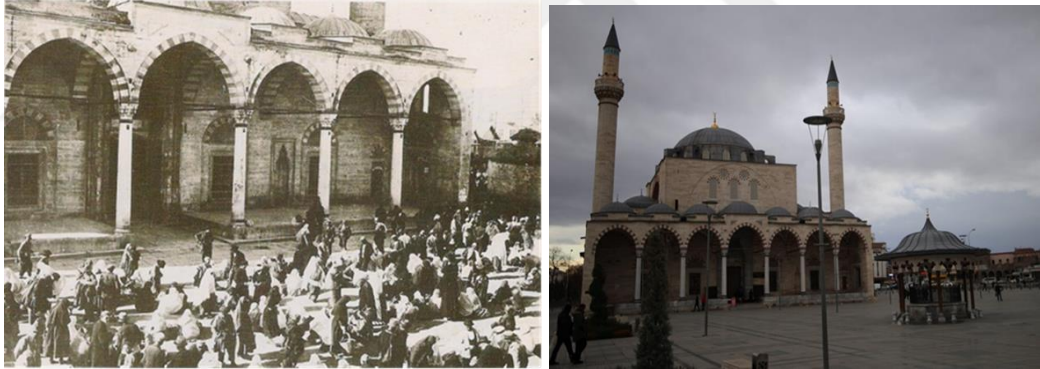
Şekil 3.58. Sultan Selim Camii önü kadınlar pazarı 1915 ve 2019 kullanımı (url-95)
