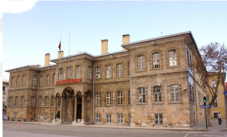
Şekil 3.24. Valilik Binası, 2019 (url-67)
