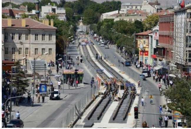
Şekil 3.62. Mevlana Caddesi tramvay yolu yapılırken, 2014 (url-99)
