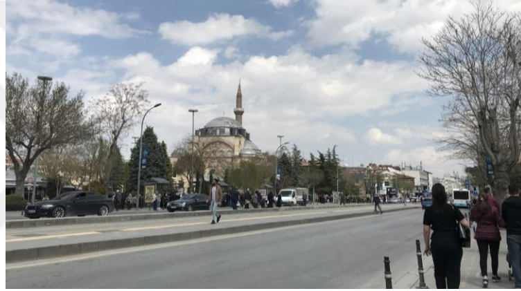
Şekil 4.50. Kayalıpark'tan Şerafettin Cami'ye bakış, toplu taşıma durakları ve tramvay hattı
