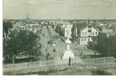
Şekil 3.1.3.1.3. Yusuf Şar Konağı'ndaki eski Konya Belediye binası
