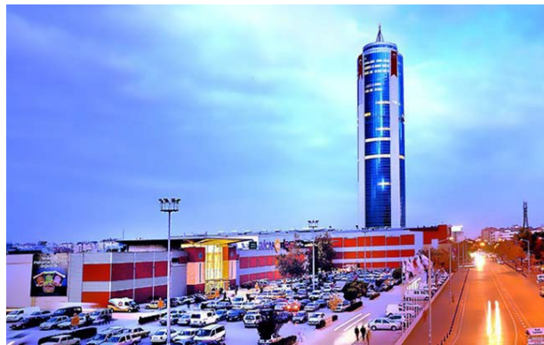
Şekil 3.1.2.1.7. Nalçacı Caddesi'nde bulunan otogar yerine yapılan Kule-Site Alışveriş Merkezi ve Ofis Binası
