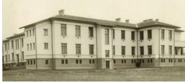
Şekil 3.1.8.2.2. H şeklindeki Devlet Hastanesi Binası
