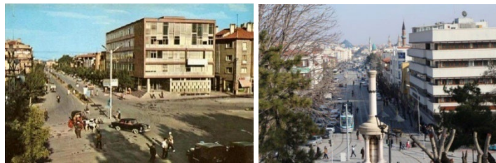
Şekil 3.1.3.1.4. 1963 yılından sonra yenilenen belediye binası (solda) ve günümüzde eski belediye binasında bulunan İş Bankası binası (sağda)
