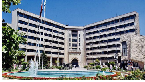
Şekil 3.1.3.1.5. Kısa süre önce yıkılan son Büyükşehir Belediye Binası
