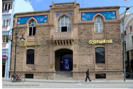
Şekil 3.1.2.1.27. Konya tarihi Yapı Kredi Bankası binası
