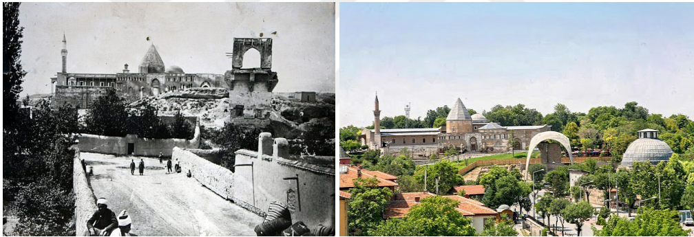
Şekil 3.1.1.1.9. Kılıçarslan Köşkü'nün betonarme muhafazaya alınmadan önce (solda) ve sonraki (sağda) görünümüleri
