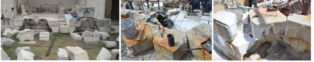
Şekil 3.24. Akşehir Taş Eserler Müzesi mukarnas birimleri yapım aşaması (Konya Rölöve ve Anıtlar Müdürlüğü Arşivi, 2014)
