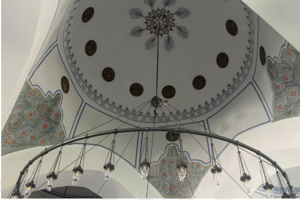
Şekil 3.20. Kastamonu Nasrullah Camisi restorasyon sonrası (URL-42)
