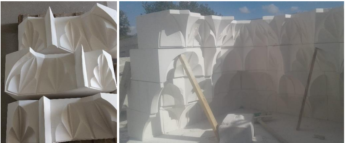
Şekil 3.37. CNC makineleri ile hazırlanmış bokların montajı (Nevşehir Taşanlar Mermer Arşivi)
