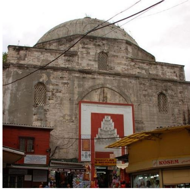
Şekil 3.12. İstanbul Mahmut Paşa Hamamı taç kapı mukarnası(URL-33)
