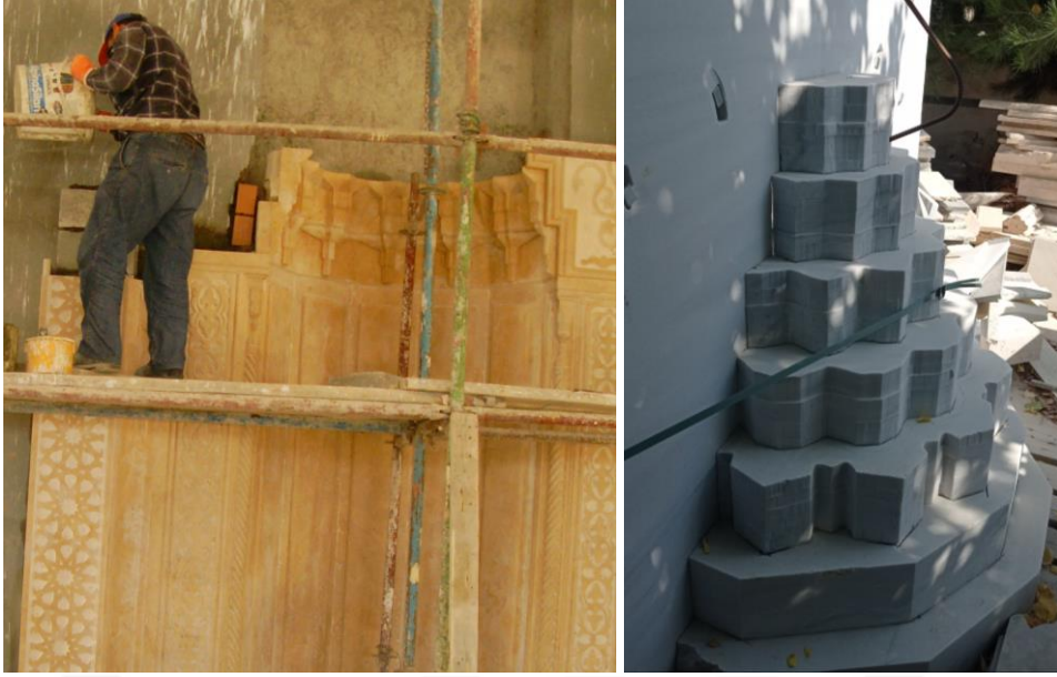
Şekil 3.29. Mukarnas mihrap uygulamasının montajı ve mukarnas kütlelerinin arkadan dizilimi (Konya Özkardeşler Mermer Arşivi, 2013)
