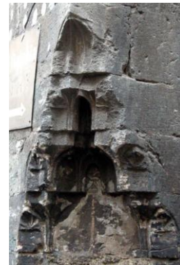
Şekil 2.5. Halep Şuaybiye Medresesi köşe mukarnası detayı (URL-9)
