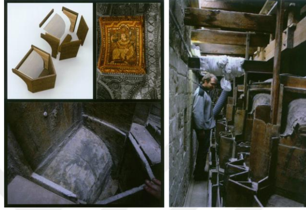
Şekil 4.38. Palantin Şapeli ahşap mukarnas yapım detayları (Agnello, 2011)
