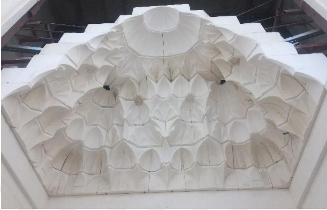
Şekil 3.38. Otel kapısı mukarnas örtü montajı (Nevşehir Taşanlar Mermer Arşivi)
