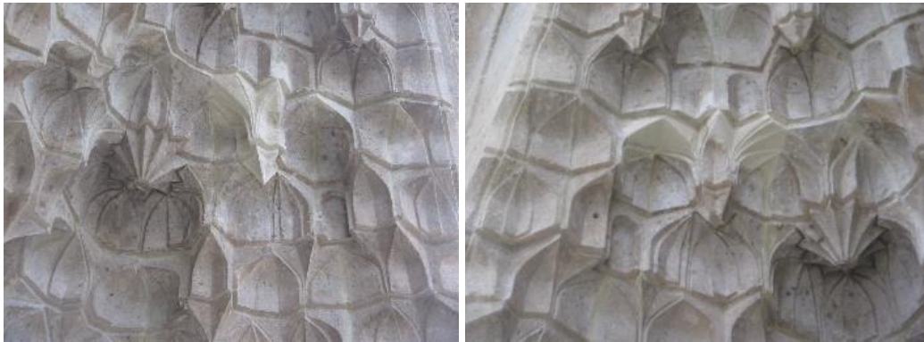
Şekil 3.21. Sahip Ata Camisi taç kapı mukarnas onarım detayı (İzzet Gözel Kişisel Arşivi)
