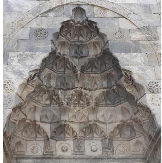
Şekil 2.19. Sultanhanı iç kapı mukarnası (S.G.Dinçer Kişisel Arşivi, 2019)
