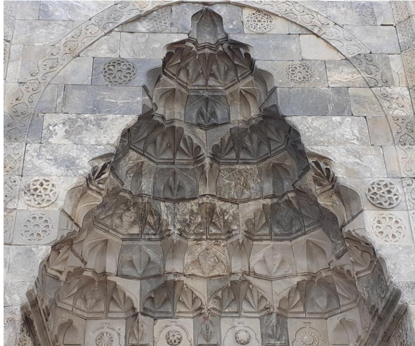
Şekil 4.50. Aksaray Sultanhanı iç kapı mukarnas detayı (S.G.Dinçer Kişisel Arşivi, 2019)
