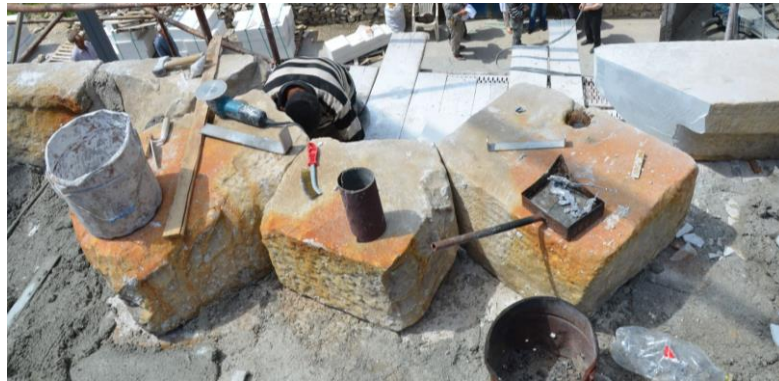
Şekil 4.49. Konya Akşehir Taş Medrese mukarnas yapım detayı (Konya Rölöve ve Anıtlar Müdürlüğü Arşivi, 2014)
