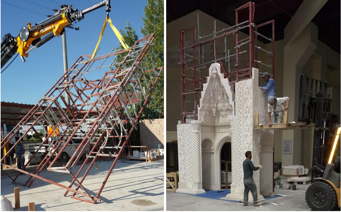
Şekil 3.32. Taç kapı mukarnası mekanik montaj uygulama aşamaları (Antalya Kandemir Mermer Arşivi)
