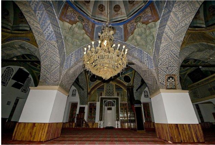
Şekil 3.19. Kastamonu Nasrullah Camisi restorasyon öncesi (URL-41)
