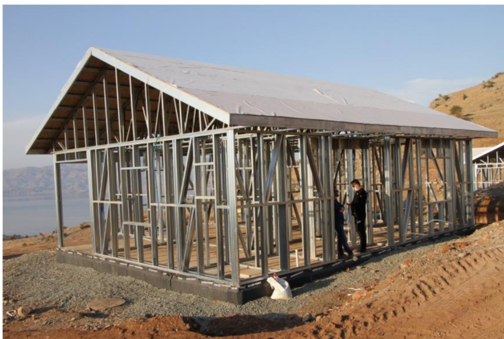
Şekil 1.2. Elazığ’da çelik konut inşası
