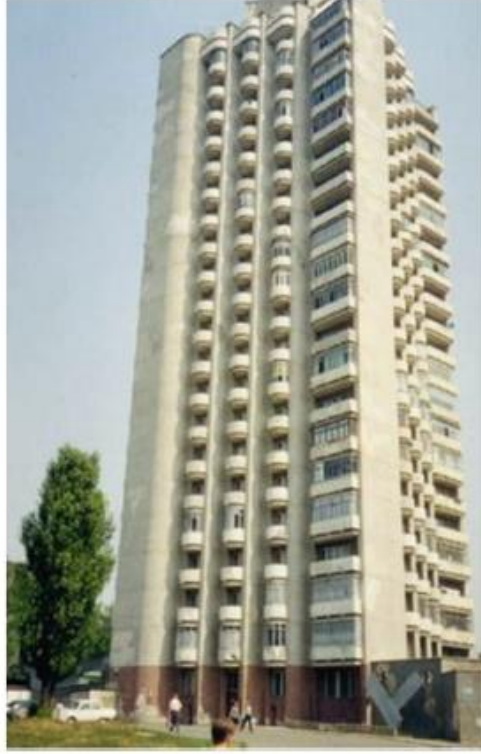
Şekil 2.6. Alkali ile aktive edilmiş betondan yapılmış 20 katlı konut binası (Almutairi ve ark., 2021).
