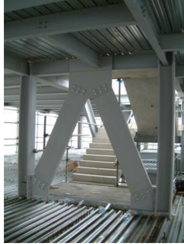
Şekil 3.7. Merkezi çaprazlı çerçeve uygulama örneği ( https://www.pinterest.co.uk/pin/371054456775224017/ )
