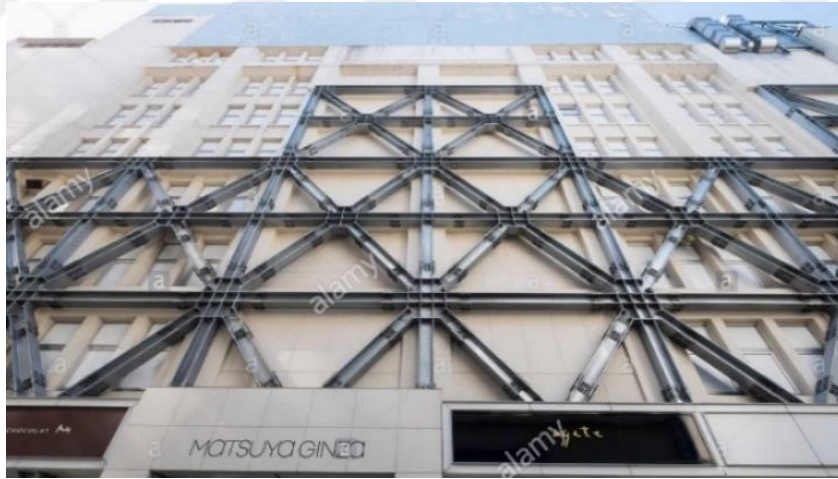
Şekil 3.8. Merkezi çaprazlı çelik çerçeve uygulama örneği ( https://previews.agemotostock.com/previewimage/medibigoff/1e9e1d2f1157f2754323cb4ed68c4ece/x8h-2528110.jpg )
