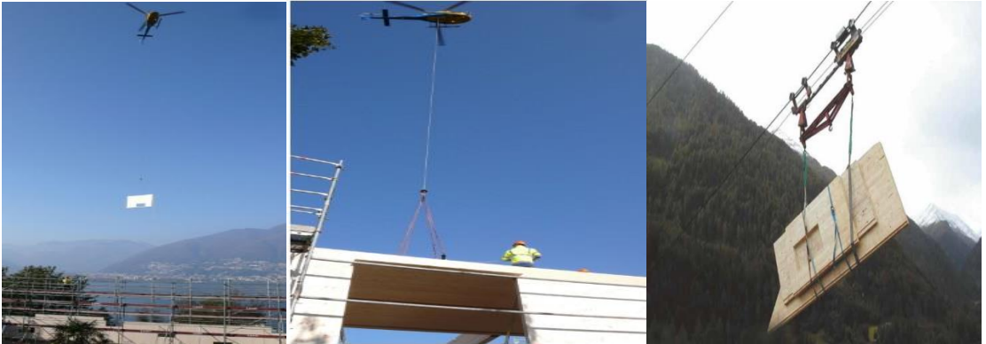
Şekil 9.1. Helikopter ve teleferik sistemleriyle kesitlerin şantiye sahasına nakliyesi (URL- 12)
