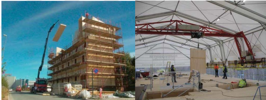
Şekil 9.2. Mobil vinç ve hareketli çatı sisteminin köprülü vinç ile kurulumu (Francis ve ark., 2013)
