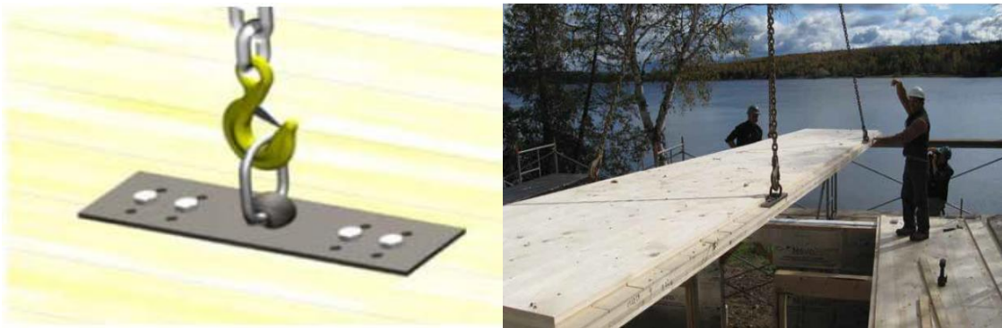
Şekil 9.5. Panele vidalanmış küçük plakalar ile taşıma (Francis ve ark., 2013)
