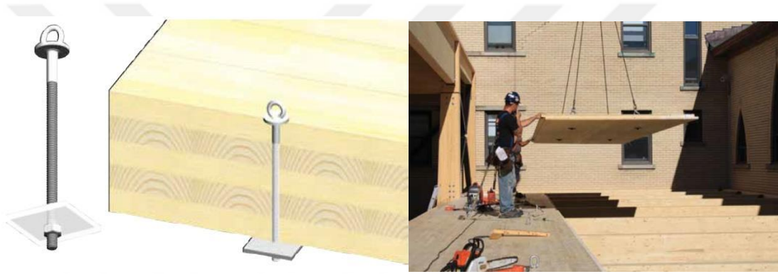
Şekil 9.4. Dişli vida kullanılarak yapılan taşıma (Francis ve ark., 2013)
