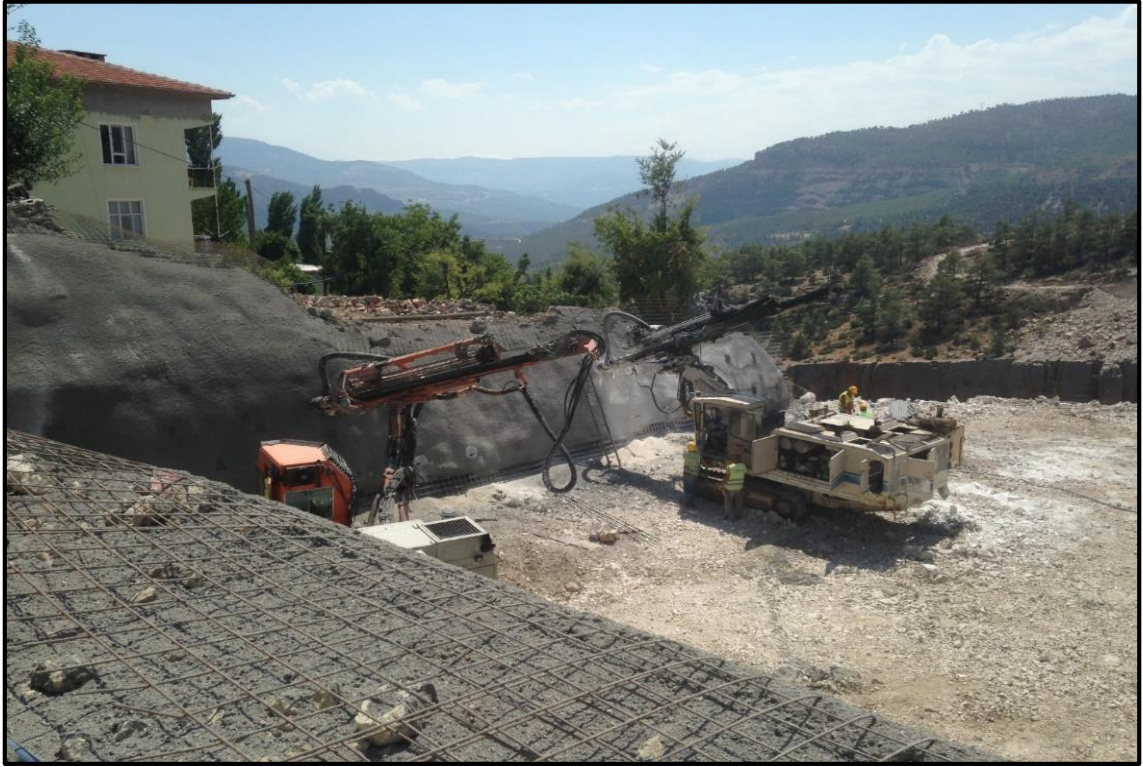
Şekil 4.23. Zemin çivisi delgi çalışmalarından bir fotoğraf
