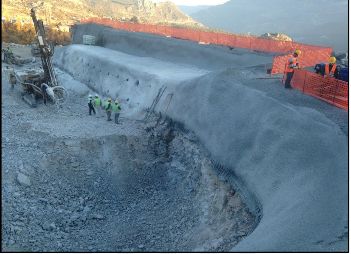
Şekil 4.25. Zemin çivisinin yerleştirilmesi ve enjeksiyonlanması
