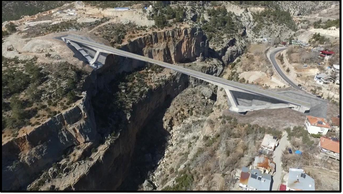
Şekil 4.21. Çamlıca Köprüsü tamamlanmış hali (animasyon)
