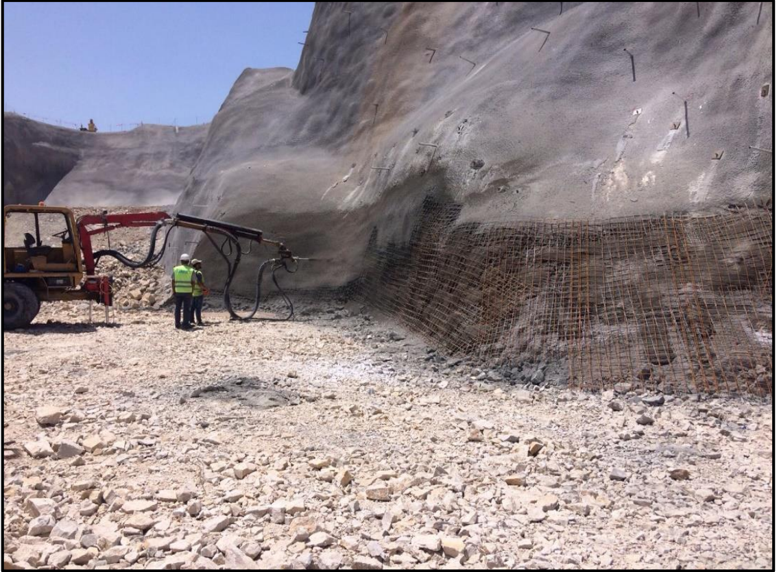
Şekil 4.28. Kaplama amaçlı püskürtme beton yapılması
