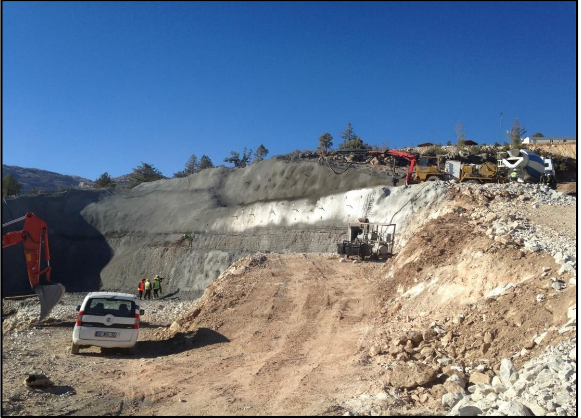
Şekil 4.26. Drenaj sisteminin tesis edilmesi
