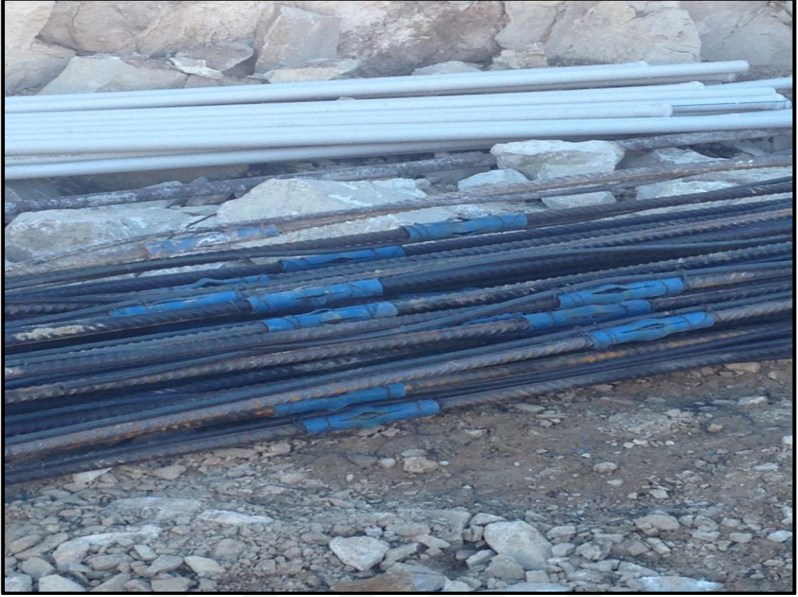
Şekil 4.24. Uygulamaya hazırlanmış zemin çivileri
