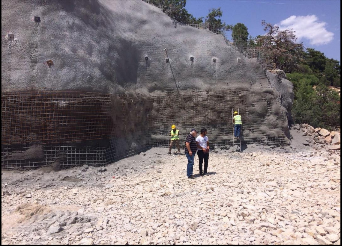
Şekil 4.27. Kaplama amaçlı son kademe püskürtme beton öncesi hasır donatı döşenmesi
