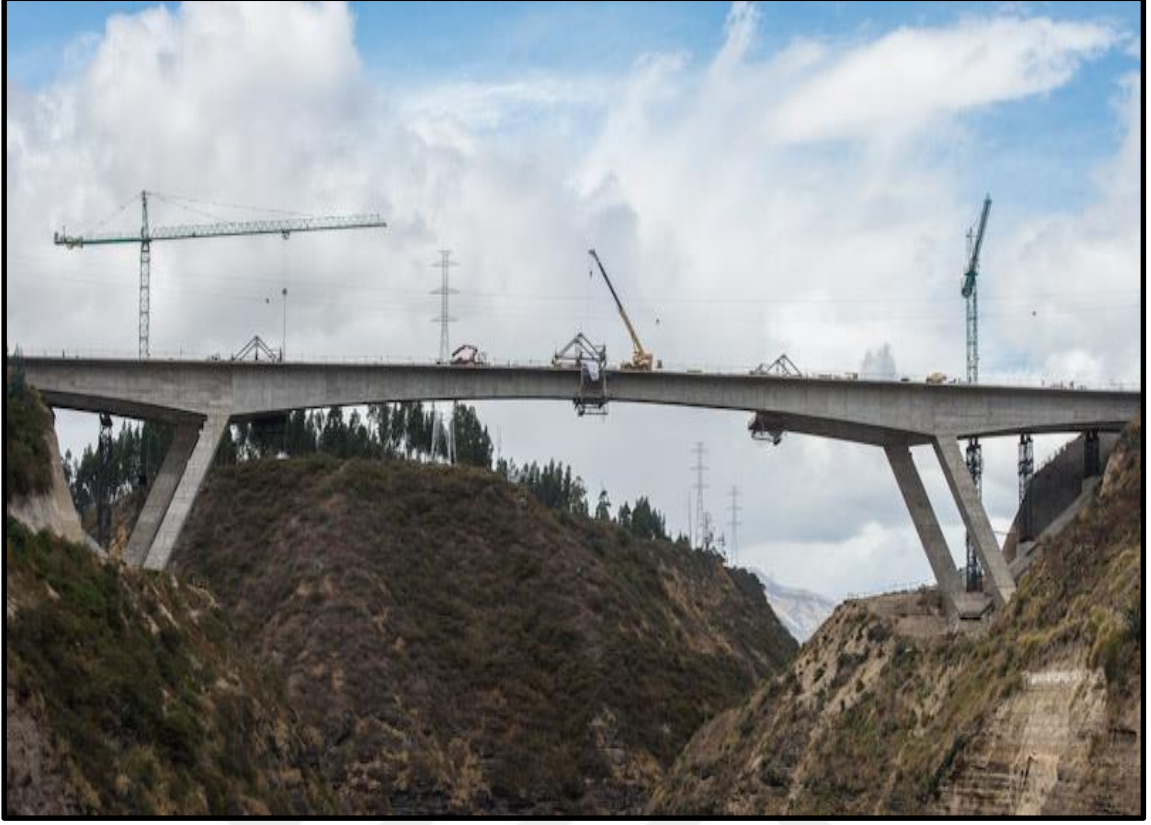
Şekil 4.30. Dünyada eğik ayaklı konsol köprü olarak yapılmış tek örnek olan Chiche köprüsü (Ekvador)
