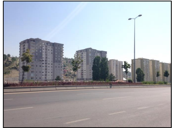
Şekil 6b. Yeni Mamak Kentsel Dönüşüm Projesi 1. Etap Yıkım Yıkım Sonrası Görünüm (Kaynak: Fotoğraf yazarlar tarafından çekilmiştir.)
