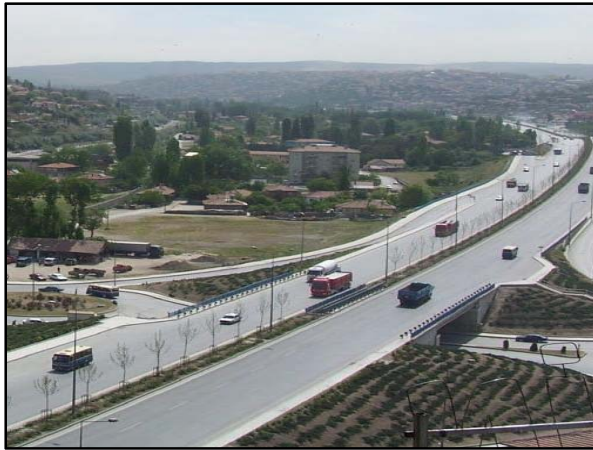
Şekil 6a. Yeni Mamak Kentsel Dönüşüm Projesi 1. Etap Yıkım Öncesi Görünüm Kaynak: Mamak Belediyesi, 2017
