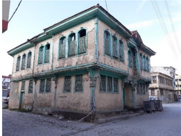
Şekil 4.34. Cilaloğlu Sokakta alt katta demir parmaklıklı, üst katta ahşap kafesli kemerli pencere örneği
