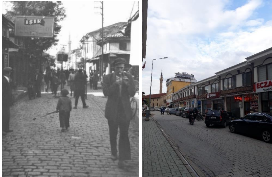
Şekil 5.7. İstasyon Caddesinde özgün yol döşemesinin (Sait Ekici arşivi) parke taşı ile değiştirilmesi
