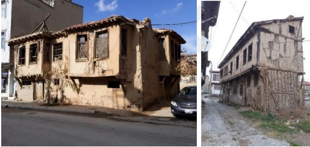
Şekil 6.10. Hacı Ahmet Caddesinde kapsamlı müdahale gerektiren yapı örneği
