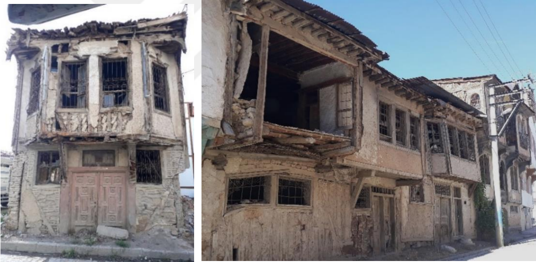
Şekil 5.14. Cılkoğlu ve Tahtalı Sokakta yer alan âtil durumdaki tescilli yapılar
