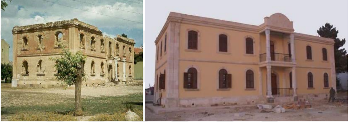
Şekil 3.36. Yanık Kışla restorasyon öncesi ve sonrası (Belediye arşivi)
