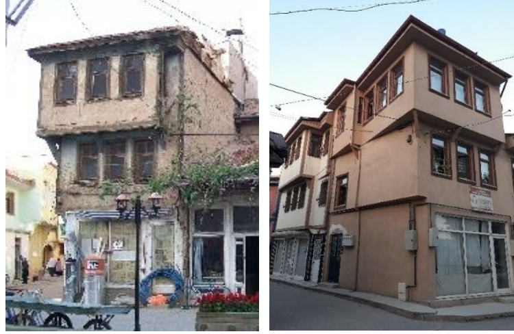
Şekil 6.12. Hisaryolu Sokakta yapının özgün haline uygun yapılmayan betonarme rekonstrüksiyon örneği
