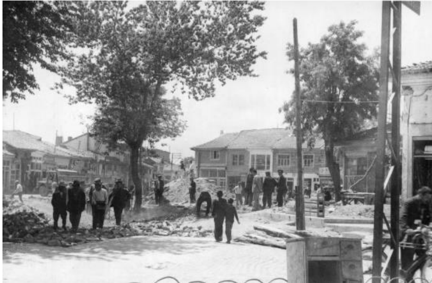
Şekil 5.17. Çarşı merkezindeki ada yıkılırken, 1972 (Sait Ekici arşivi)
