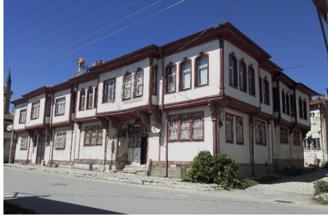
Şekil 4.28. Zafer Caddesi No:57 cephe boyunca çıkmalı yapı örnekleri
