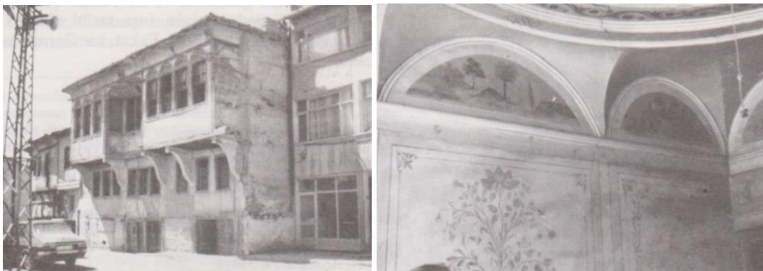
Şekil 3.42. Yıkılmadan önce Cılkoğulları evi (Uysal, 1993)
