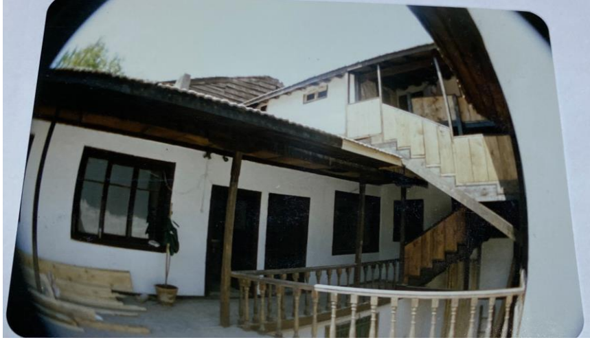
Şekil 4.63. Çatı merdiveni, yenilenen korkuluk ve pinotexle cilalama (Ankara Koruma Kurulu 2021)
