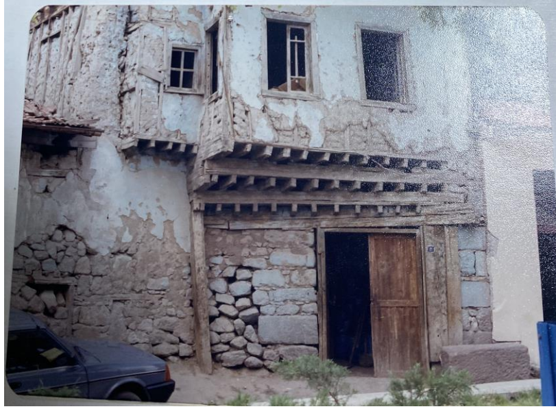
Şekil 4.52. 485 ada 13 restorasyon öncesi (Ankara Koruma Kurulu 2021)
