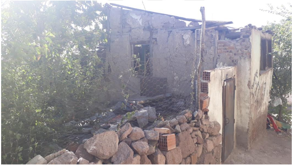
Şekil 4.58. 685 ada 11 bahçe duvarı
