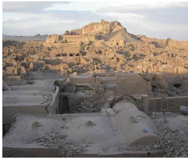
Şekil 2.7. Bam(İran) dünya mirası; 2003'teki depremde dünyanın en büyük kerpiç kalesindeki hasar (Oktay ve ark., 2020)
