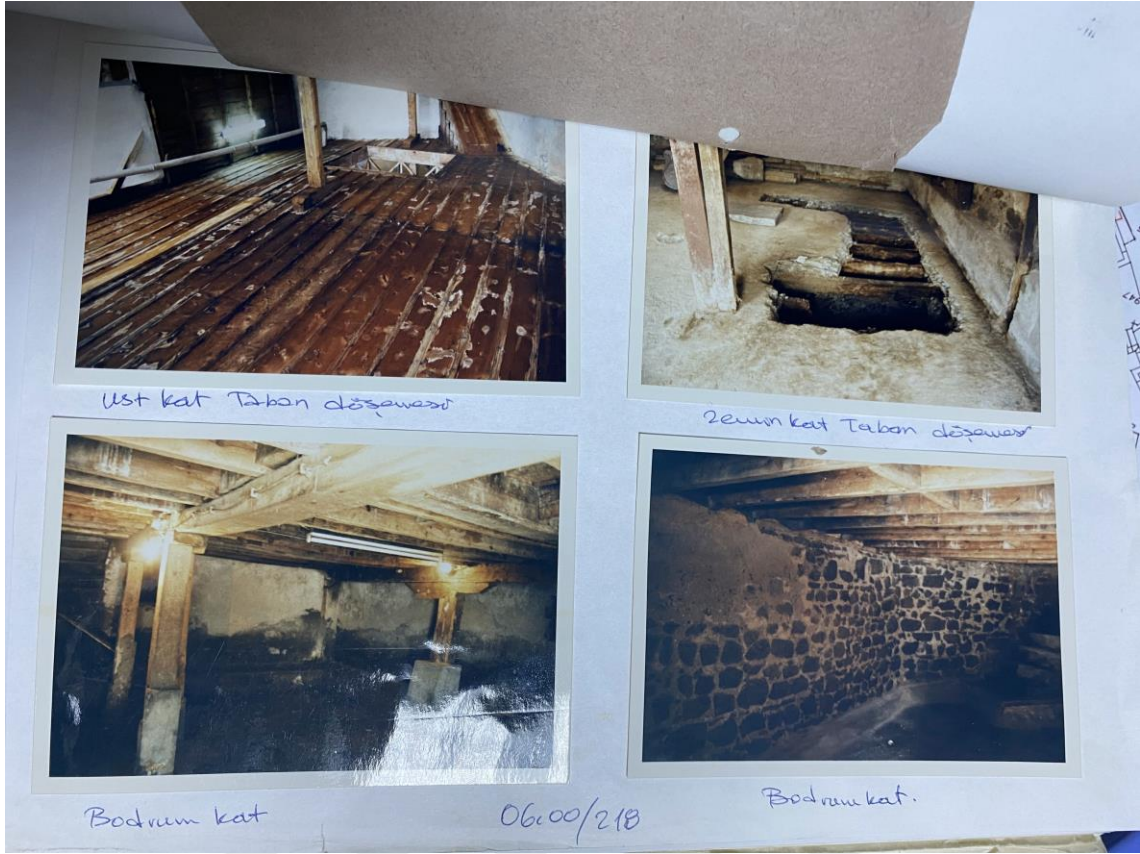
Şekil 4.77. Yapının iç mekanı tadilat öncesi (Ankara Koruma Kurulu 2021)
