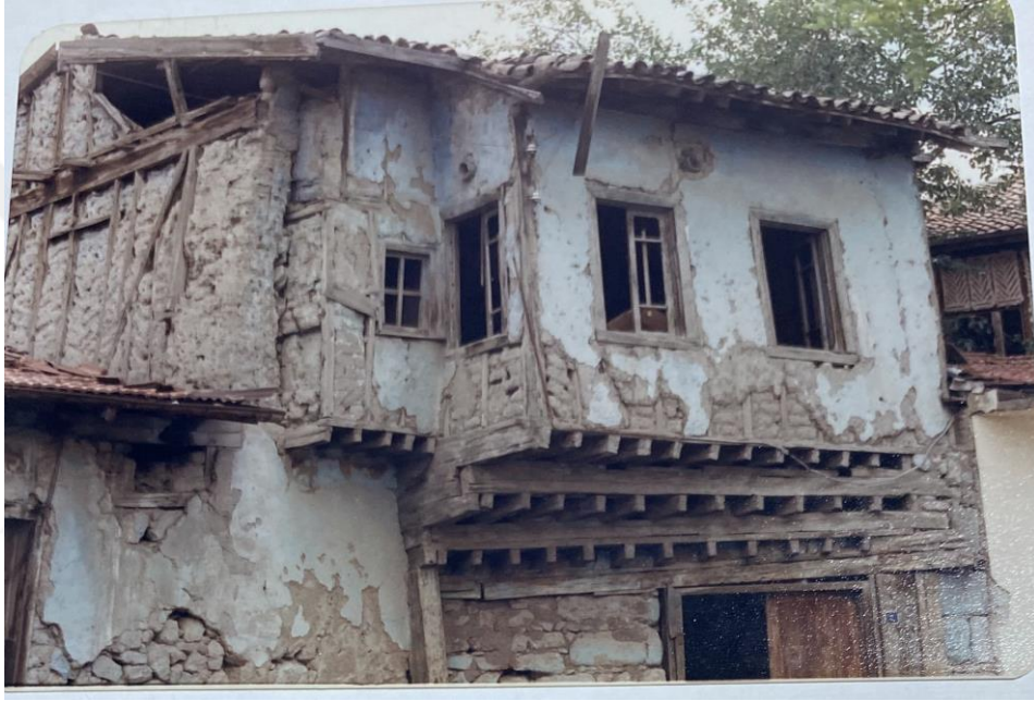
Şekil 4.51. 485 ada 13 restorasyon öncesi (Ankara Koruma Kurulu 2021)
