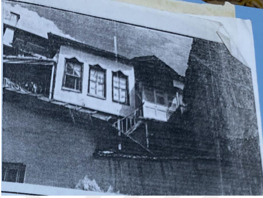
Şekil 4.84. 484 ada 6 parsel ön cephe (Ankara Koruma Kurulu 2021)
