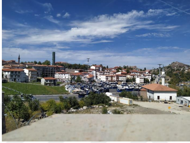
řekil 4.39. Restorasyon çalıřmaları tamamlanmıř aynı cepheli yapılar
