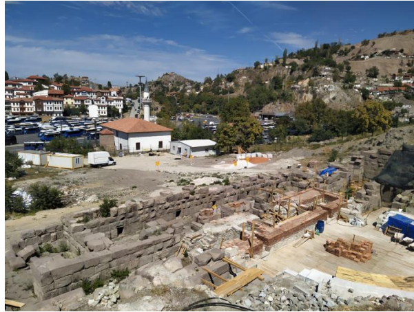
Şekil 4.30. Kentsel dönüşüm için yıkılan kale eteklerindeki konutlar
