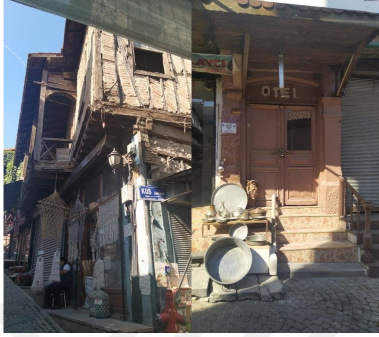
Şekil 4.40. Solda alt kat ticarethaneye dönüşen bir konut ve sağda konutun otel olarak işlev değiştirmesi
