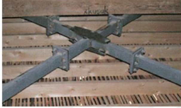
Şekil 5. 11. Döşemede çelik çapraz kullanımı (Sesigür ve ark., 2007)
