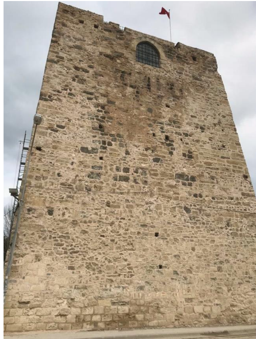
Şekil 8. 7. 10 nolu burç güney (ön) cephesi
