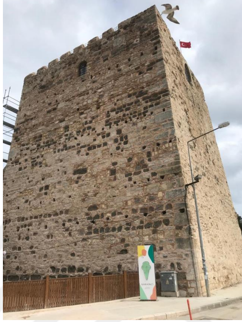
Şekil 8. 6. 10 nolu burç güney-batı cephesi
