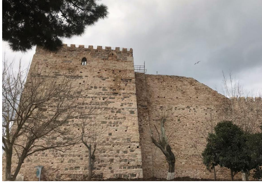
Şekil 8. 8. 10 nolu burç ve sur duvarları yandan görünümü
