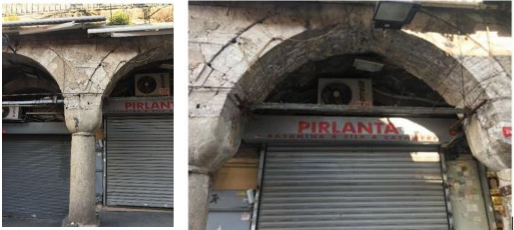
Şekil 4. 9. Düşey yükler sonucunda kemerlerde meydana gelen hasarlar (Yüce, 2021)
