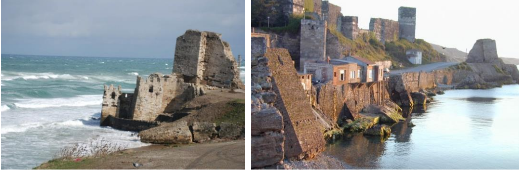
Şekil 7. 8. Kuzey sur duvar bölümleri
