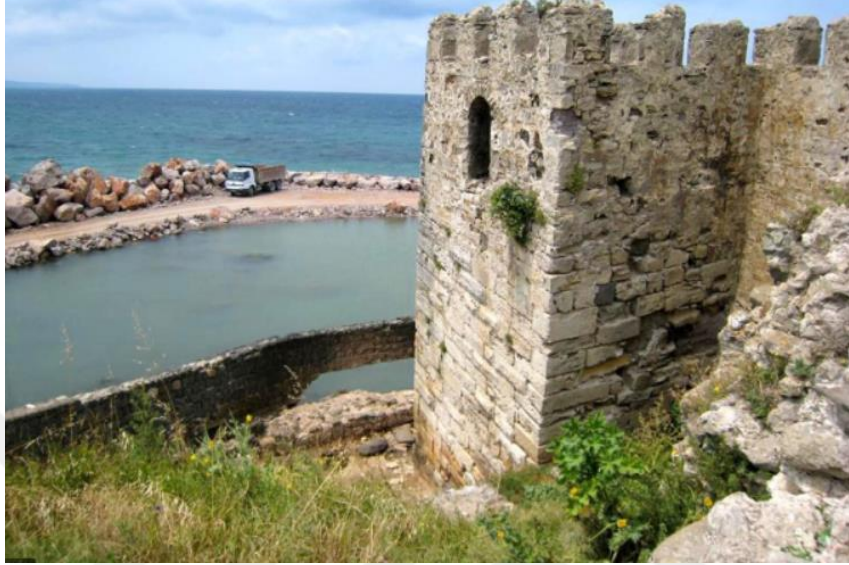
Şekil 3. 15. Sinop Kalesi kuzey surları taş duvarları
