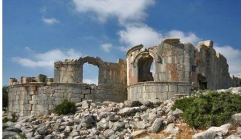
Şekil 4. 4. Deprem sonucunda oluşan hasar örneği (Döndüren ve ark., 2017)
