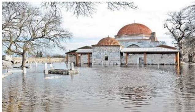
Şekil 4. 3. Sel baskını sonucu oluşan hasar örneği (Ahunbay, 2004)
