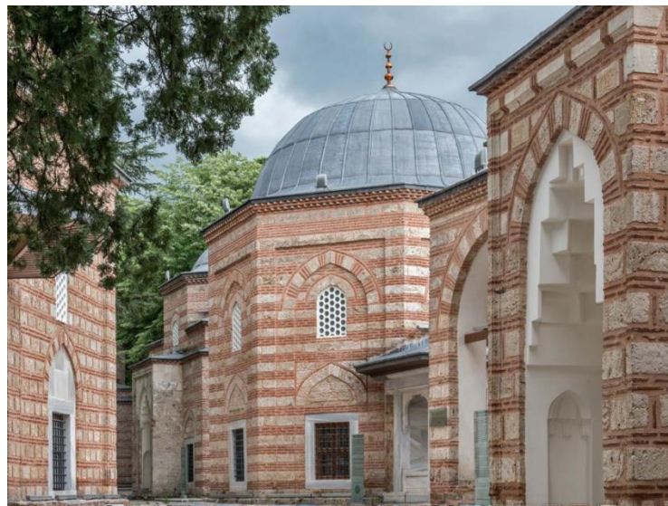
Şekil 3. 16. Bursa Muradiye Camii almaşık duvar örneği
