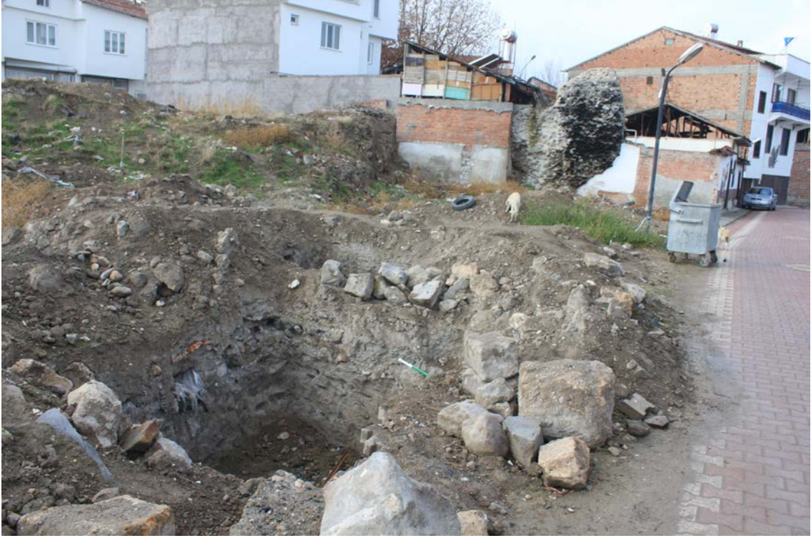
Şekil 3.14 Alaca kapı meydanından Metin Sözen sokağı yeni yapı yapılmasına yönelik araştırma çukuru şekilde gösterilmektedir. (2022)
