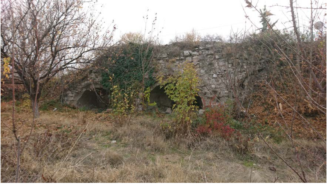
Şekil 3.12 Battalgazi surlarının güney cephesinde surların hemen iç kısmında bulunan hamam olduğu tahmin edilen görünürde üç tonozlu bulunan yapı kalıntısı (2022)
