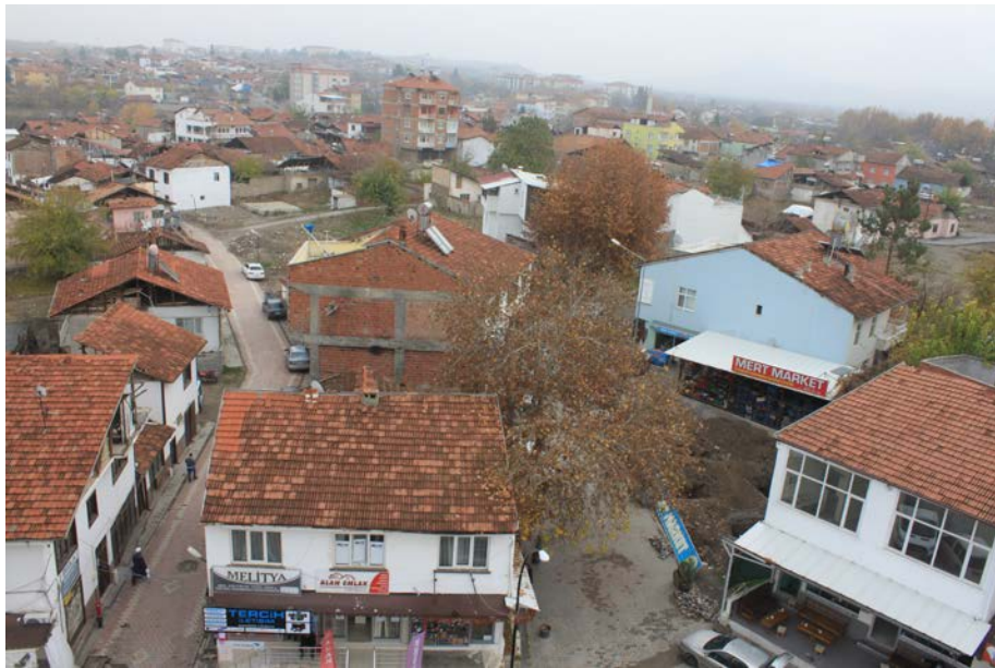
Şekil 26. Alacakapı Mescidi minaresinden çekilmiş bazı yapılara ait kaçak kat çıkmaları (2022)
