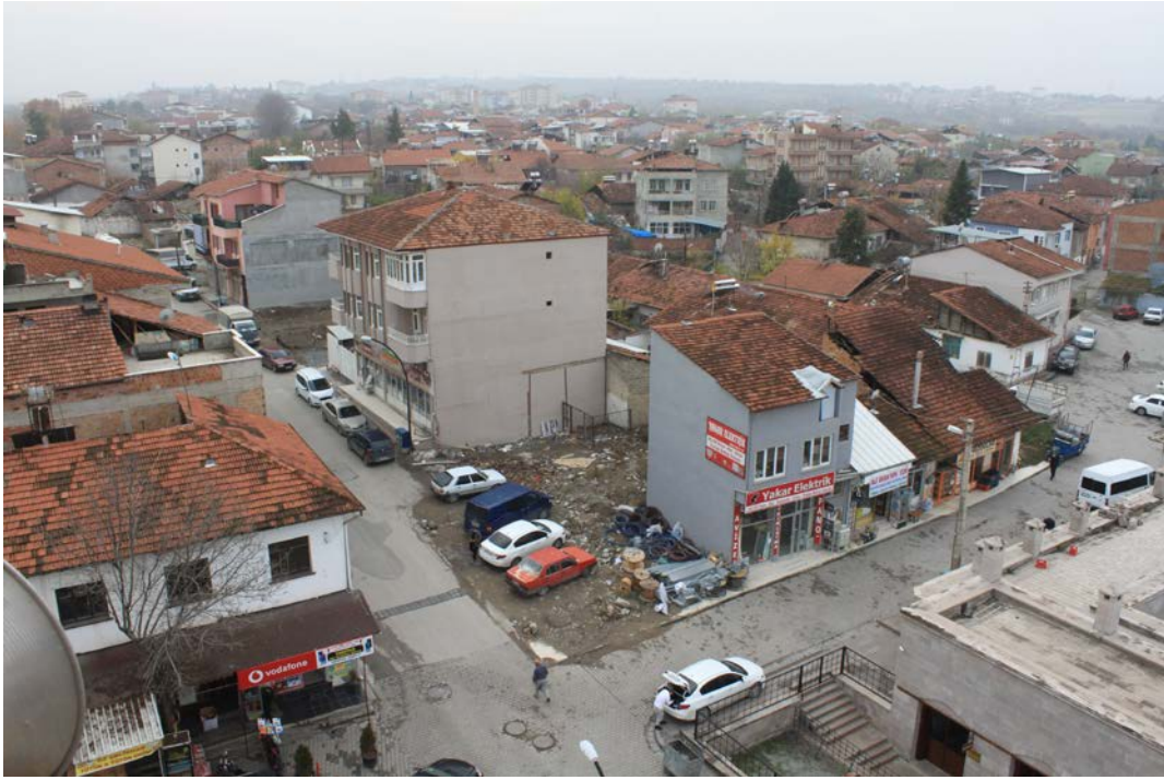
Şekil 4.3. Battalgazi sur içi kervansarayın hemen yanında yer alan bir binanın yıkılması sonrası alanda oluşan kirlilik gösterimi
