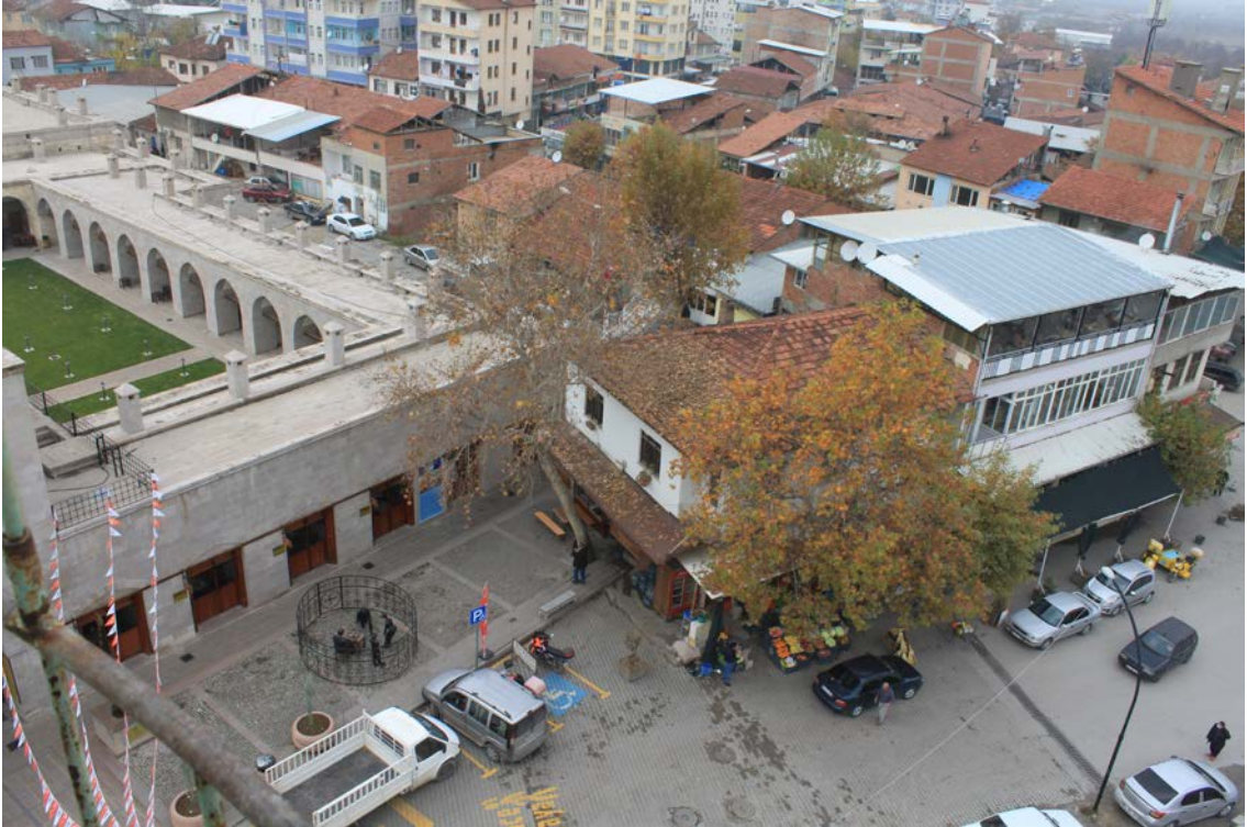
Şekil 27. Alacakapı meydanı Silahtar Mustafa Paşa Kervansarayı etrafında yer alan yapıların ticari faaliyetler amacıyla kaçak kat çıkmaları ve eklentilere örnek gösterimler (2022)
