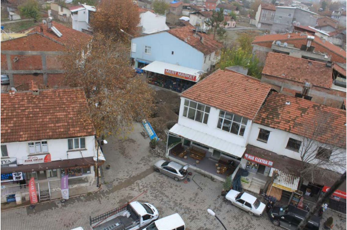
Şekil 3.13 Alaca kapı meydanından Metin Sözen sokağı girişinde yeni yapı yapılmasına yönelik araştırma çukuru şekilde gösterilmektedir. (2022)
