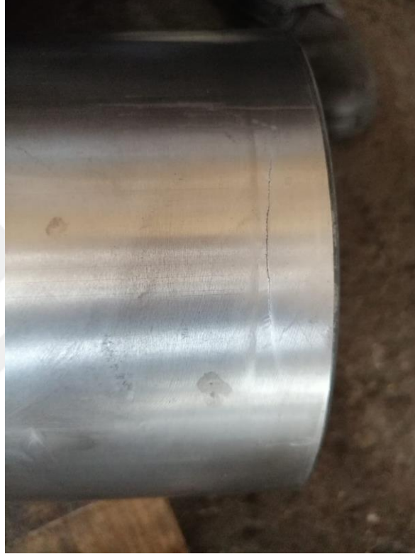
Şekil 3.13. BY'nin iç kovanında meydana gelen çatlama
