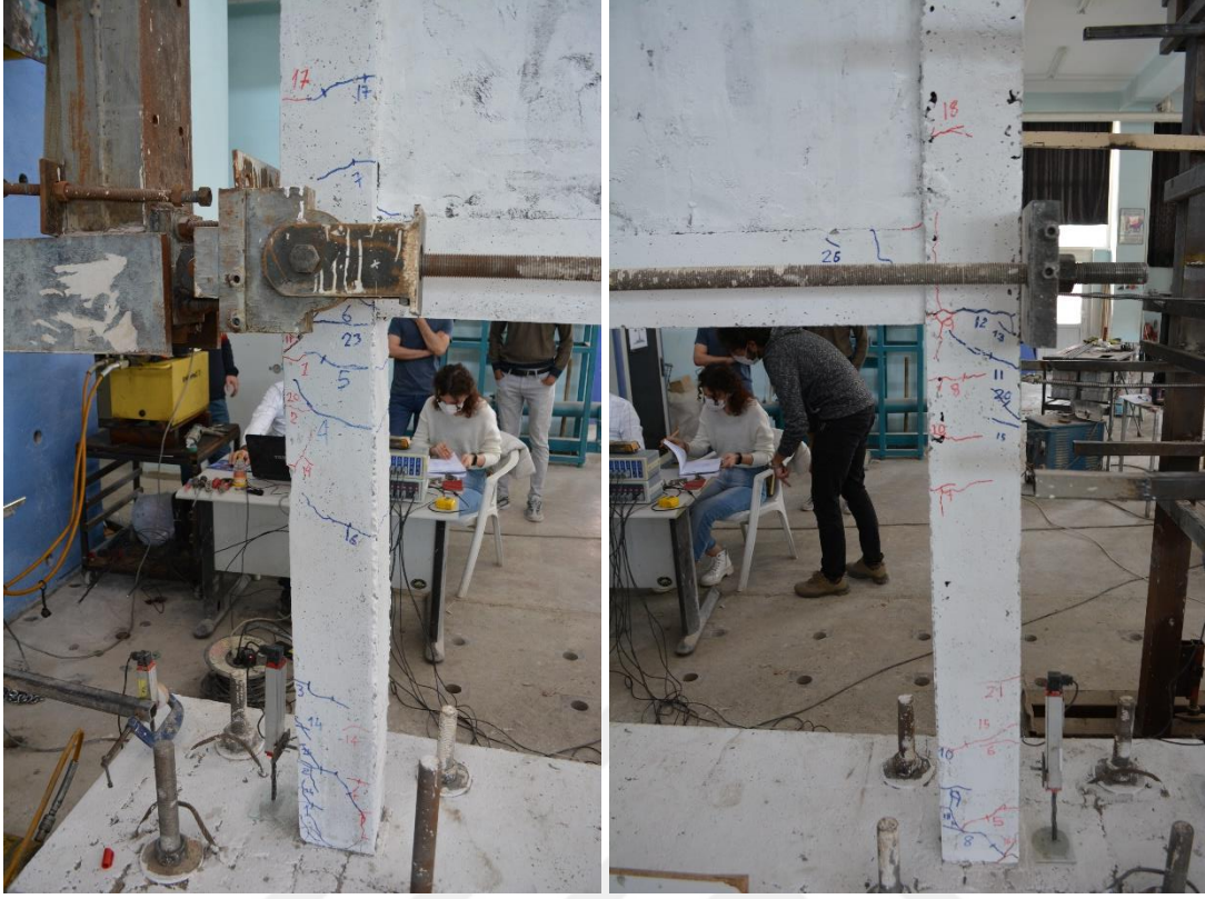
Şekil 4.8. R1 numunesinin -4 çevriminde oluşan çatlaklar
