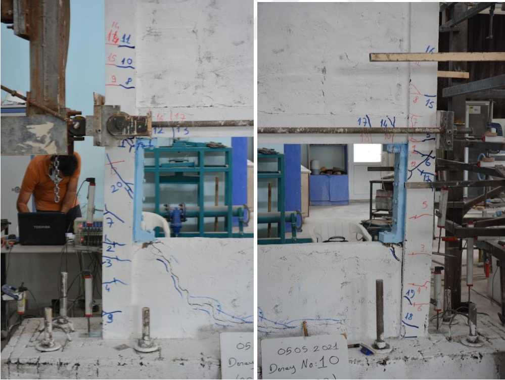
Şekil 4.150. R4-S2 numunesinin +5 çevriminde oluşan çatlaklar
