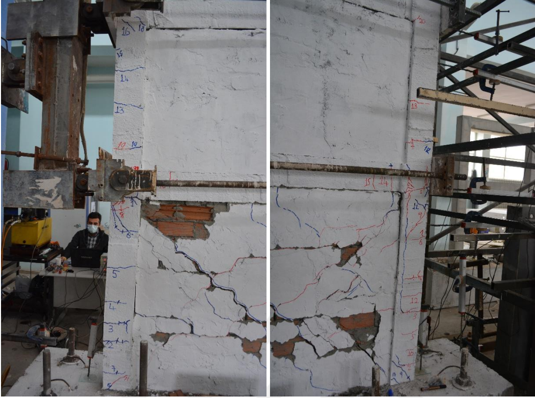
Şekil 4.24. R2 numunesinin -5 çevriminde oluşan çatlaklar
