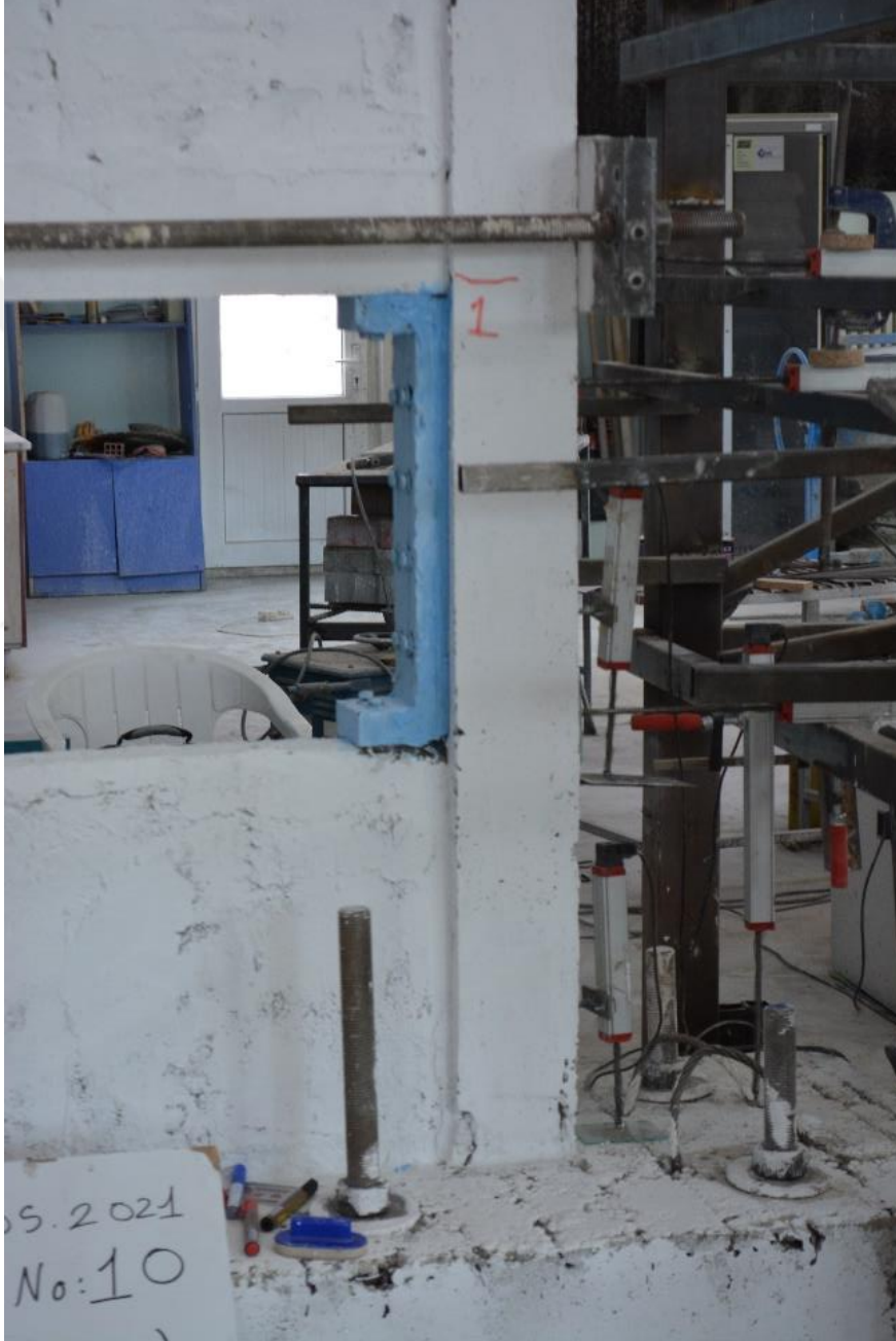
Şekil 4.143. R4-S2 numunesinin -1 çevriminde oluşan çatlaklar
