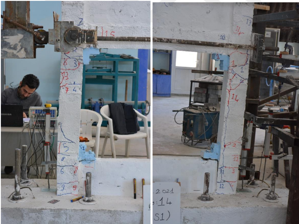
Şekil 4.119. R5-S1 numunesinin +6 çevriminde oluşan çatlaklar
