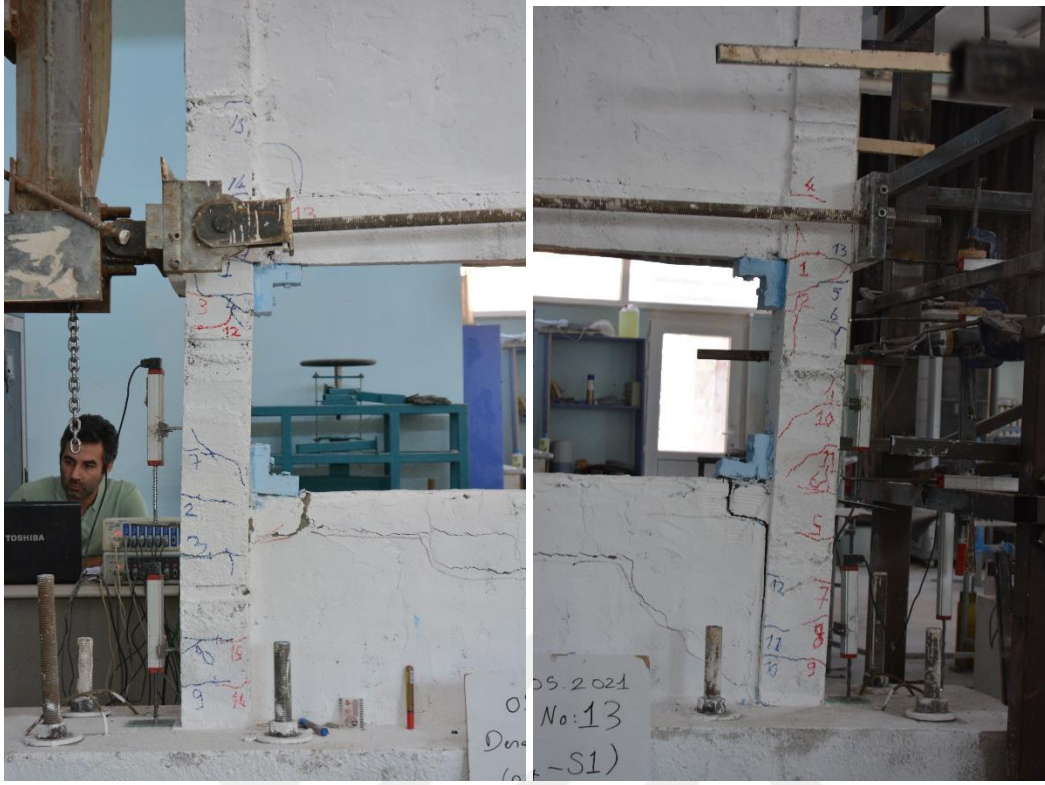
Şekil 4.104. R4-S1 numunesinin +5 çevriminde oluşan çatlaklar
