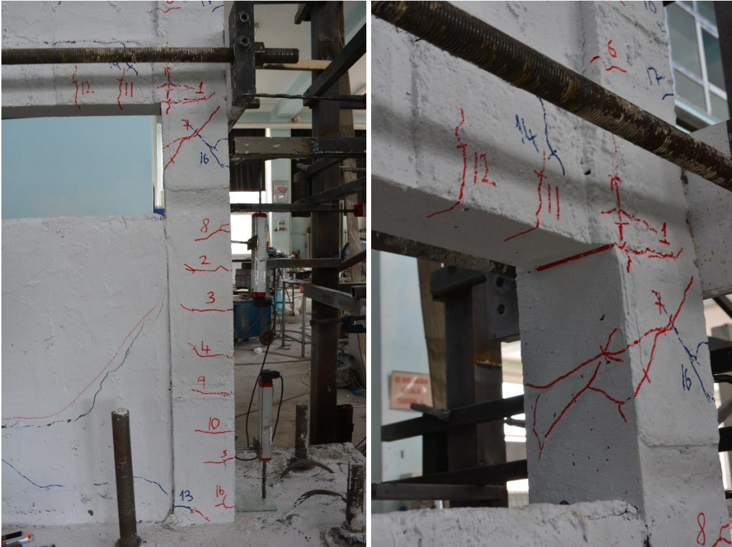
Şekil 4.38. R3 numunesinin -4 çevriminde oluşan çatlaklar
