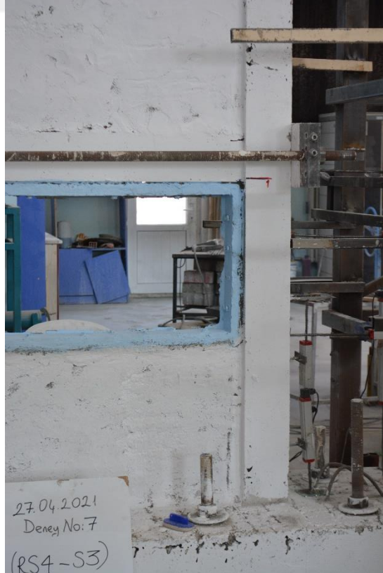
Şekil 4.191. R4-S3 numunesinin -1 çevriminde oluşan çatlaklar
