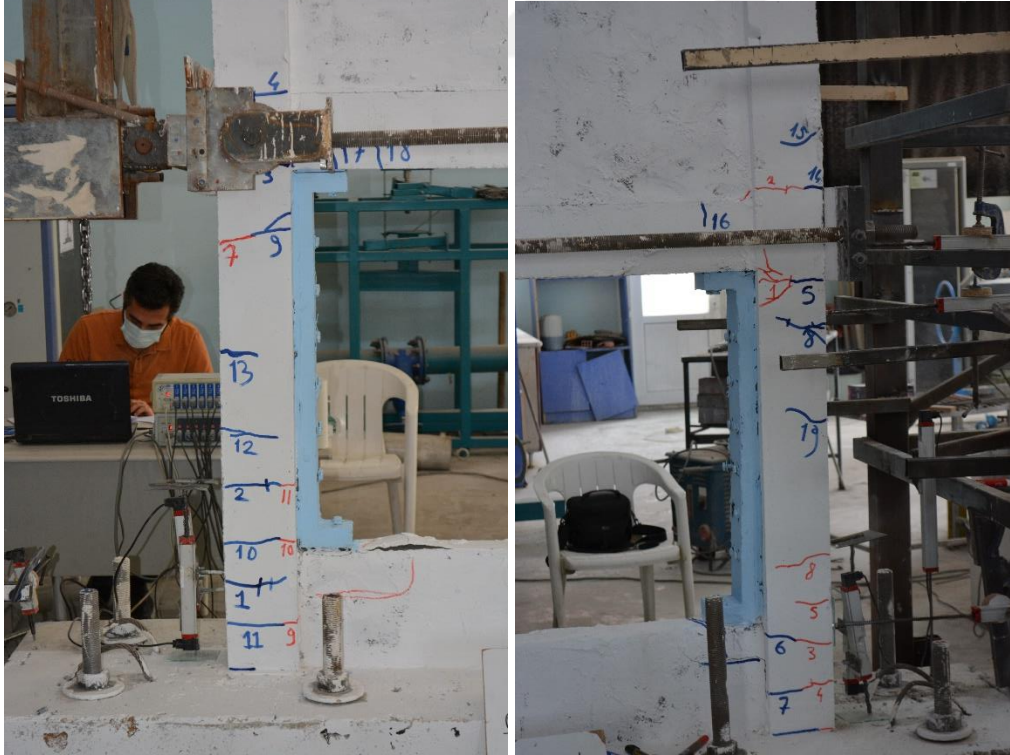
Şekil 4.164. R5-S2 numunesinin +4 çevriminde oluşan çatlaklar
