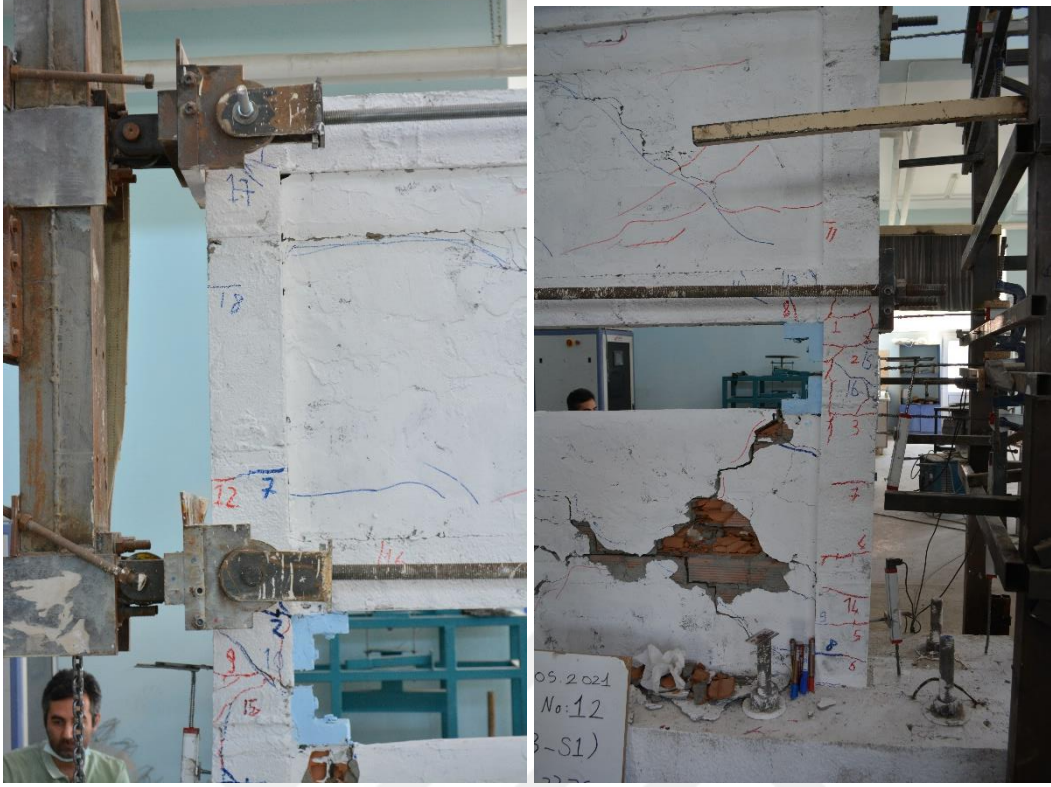
Şekil 4.87. R3-S1 numunesinin +6 çevriminde oluşan çatlaklar
