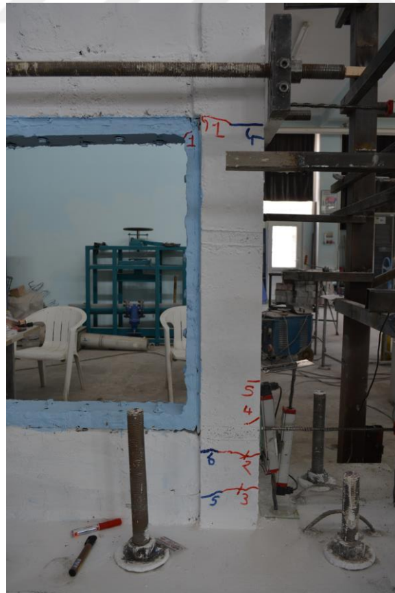
Şekil 4.209. R5-S3 numunesinin -2 çevriminde oluşan çatlaklar
