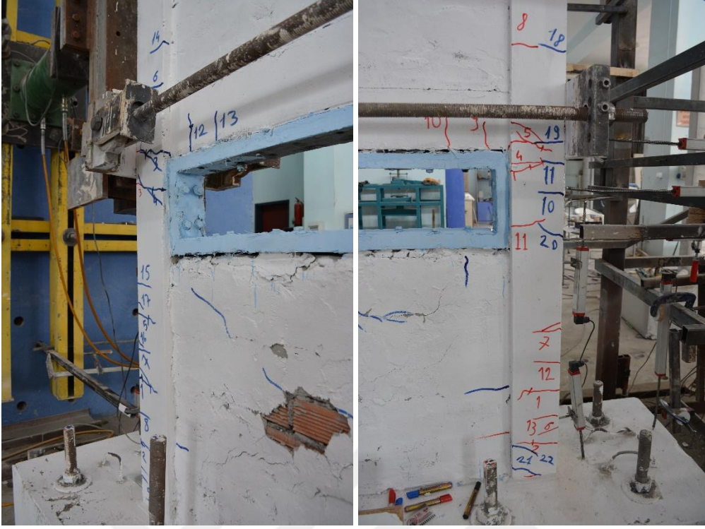
Şekil 4.180. R3-S3 numunesinin -4 çevriminde oluşan çatlaklar
