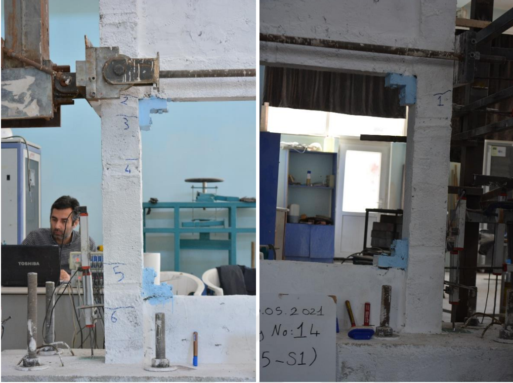
Şekil 4.112. R5-S1 numunesinin +2 çevriminde oluşan çatlaklar
