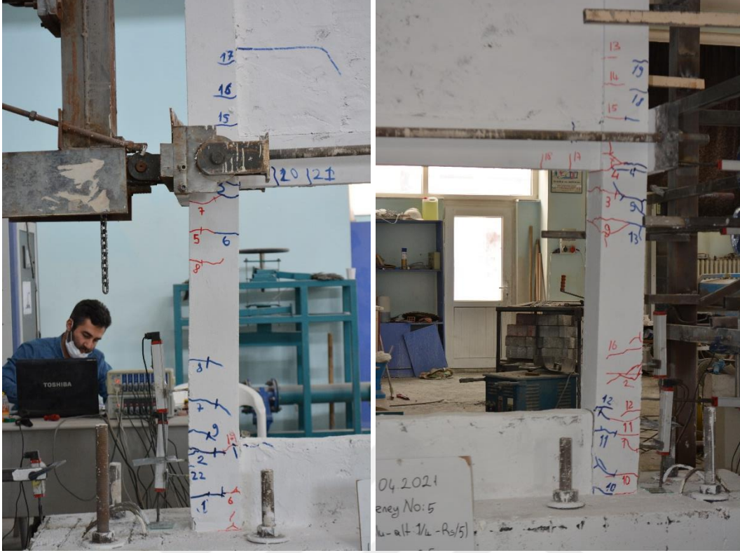
Şekil 4.71. R5 numunesinin +5 çevriminde oluşan çatlaklar
