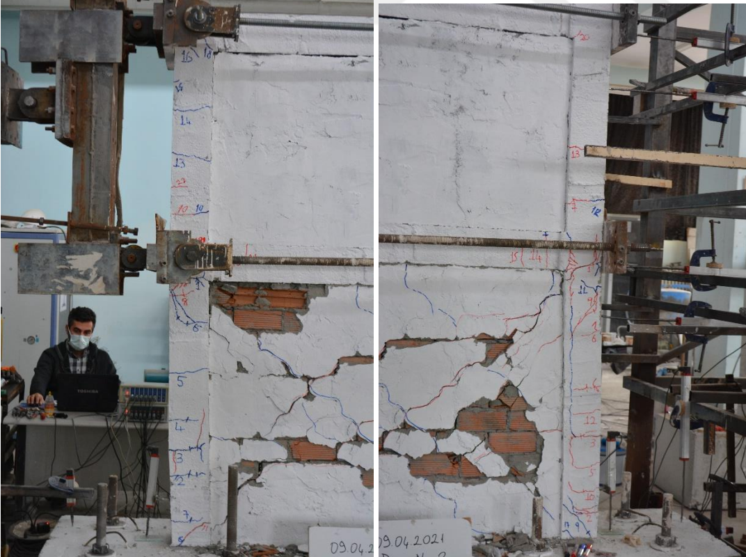
Şekil 4.25. R2 numunesinin +6 çevriminde oluşan çatlaklar
