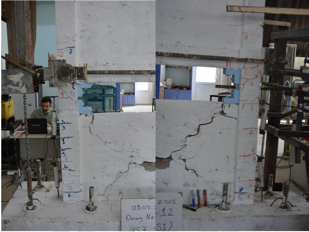
Şekil 4.84. R3-S1 numunesinin -4 çevriminde oluşan çatlaklar
