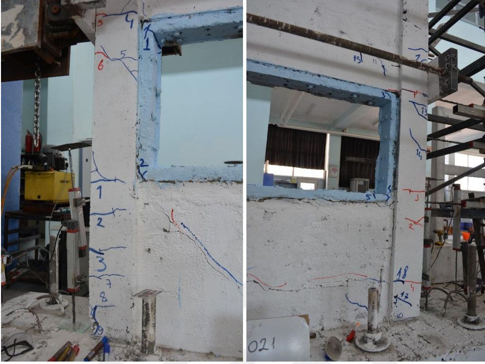
Şekil 4.196. R4-S3 numunesinin +4 çevriminde oluşan çatlaklar
