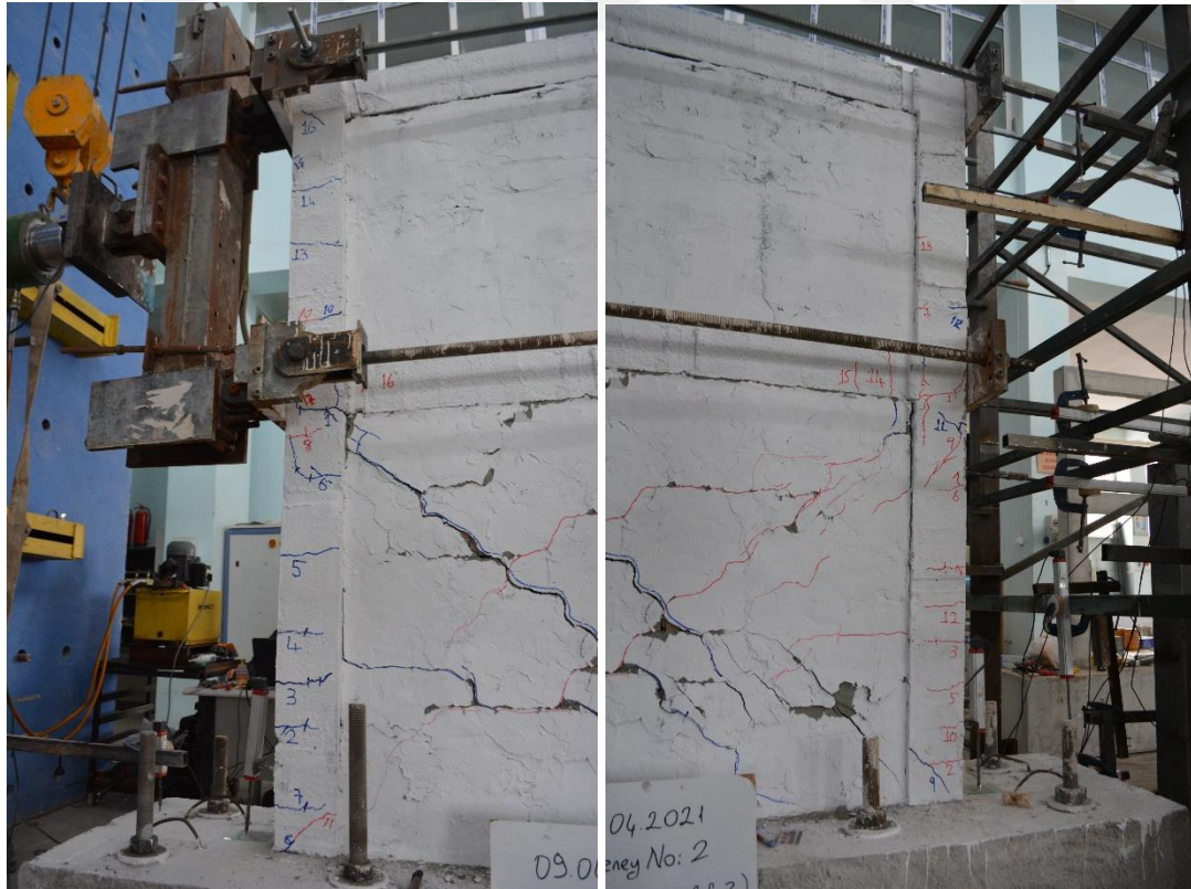
Şekil 4.23. R2 numunesinin +5 çevriminde oluşan çatlaklar
