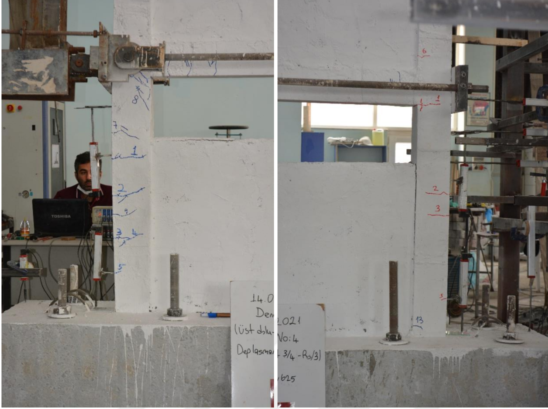
Şekil 4.35. R3 numunesinin +3 çevriminde oluşan çatlaklar
