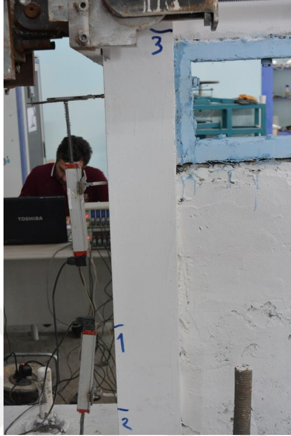
Şekil 4.174. R3-S3 numunesinin +1 çevriminde oluşan çatlaklar
