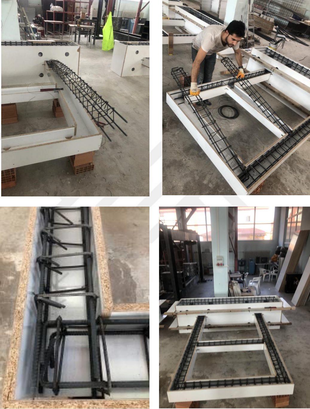
Şekil 3.10. Kalıplara donatıların yerleştirilmesi ve donatısı yerleştirilmiş çerçeveler
