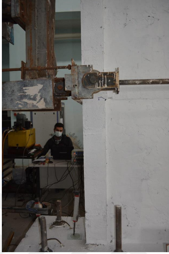
Şekil 4.16. R2 numunesinin +1 çevriminde oluşan çatlaklar
