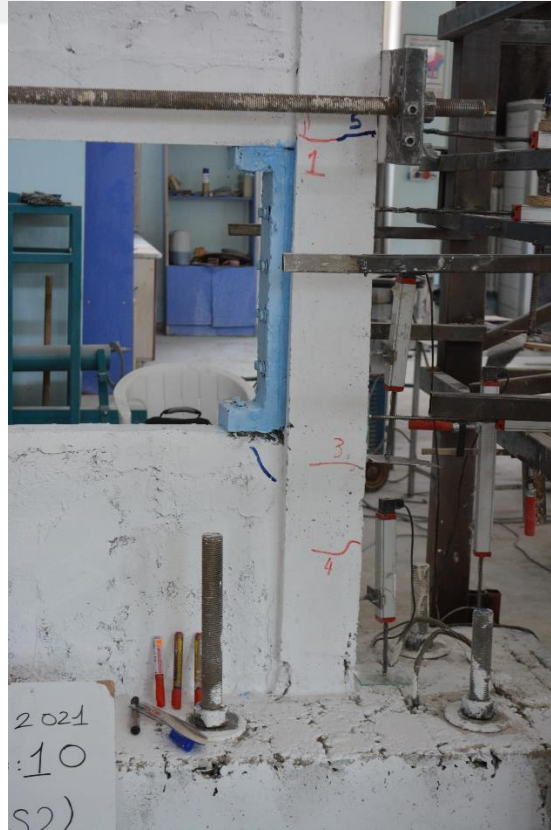
Şekil 4.145. R4-S2 numunesinin -2 çevriminde oluşan çatlaklar
