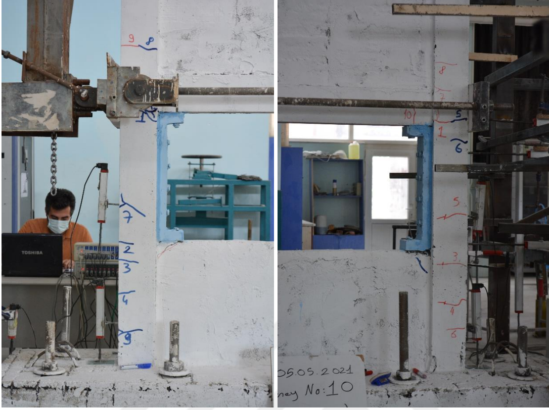
Şekil 4.147. R4-S2 numunesinin -3 çevriminde oluşan çatlaklar
