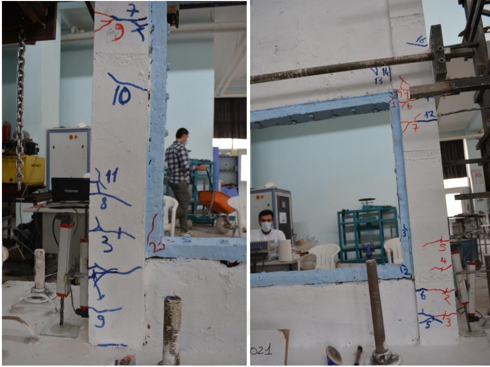
Şekil 4.212. R5-S3 numunesinin +4 çevriminde oluşan çatlaklar
