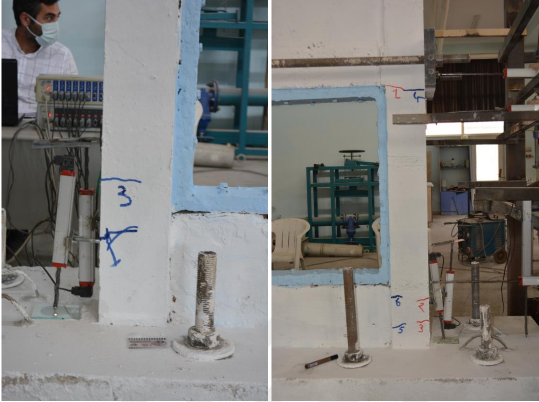
Şekil 4.208. R5-S3 numunesinin +2 çevriminde oluşan çatlaklar
