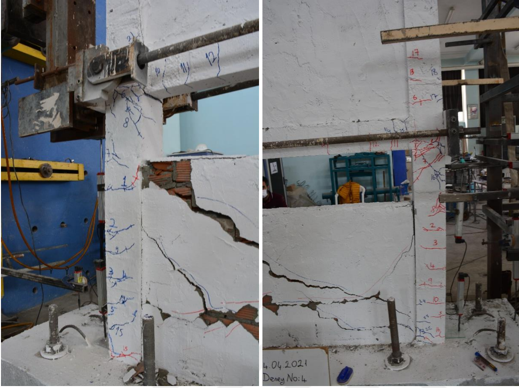
Şekil 4.41. R3 numunesinin +6 çevriminde oluşan çatlaklar
