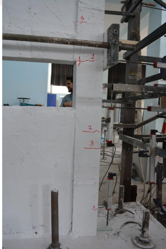
Şekil 4.34. R3 numunesinin -2 çevriminde oluşan çatlaklar
