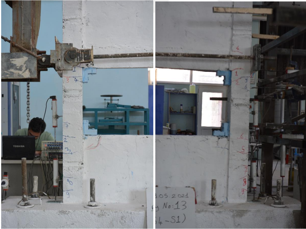
Şekil 4.101. R4-S1 numunesinin -3 çevriminde oluşan çatlaklar
