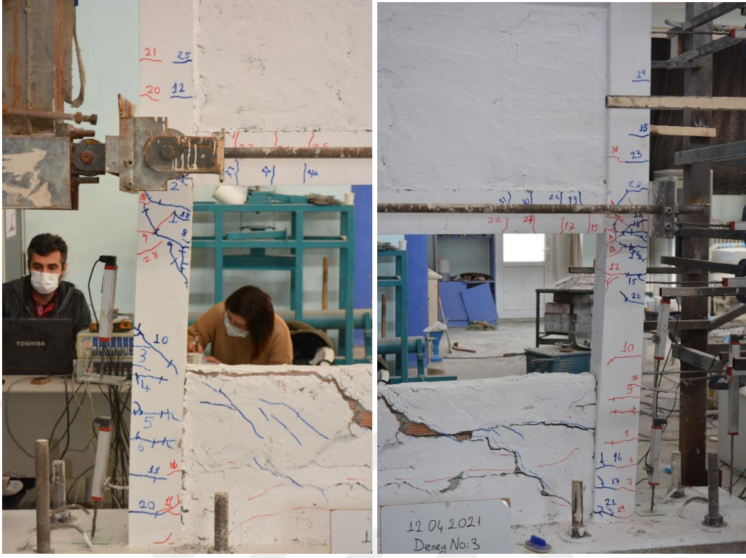
Şekil 4.57. R4 numunesinin +6 çevriminde oluşan çatlaklar
