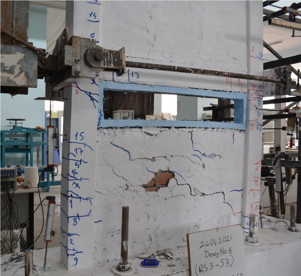
Şekil 4.181. R3-S3 numunesinin +5 çevriminde oluşan çatlaklar
