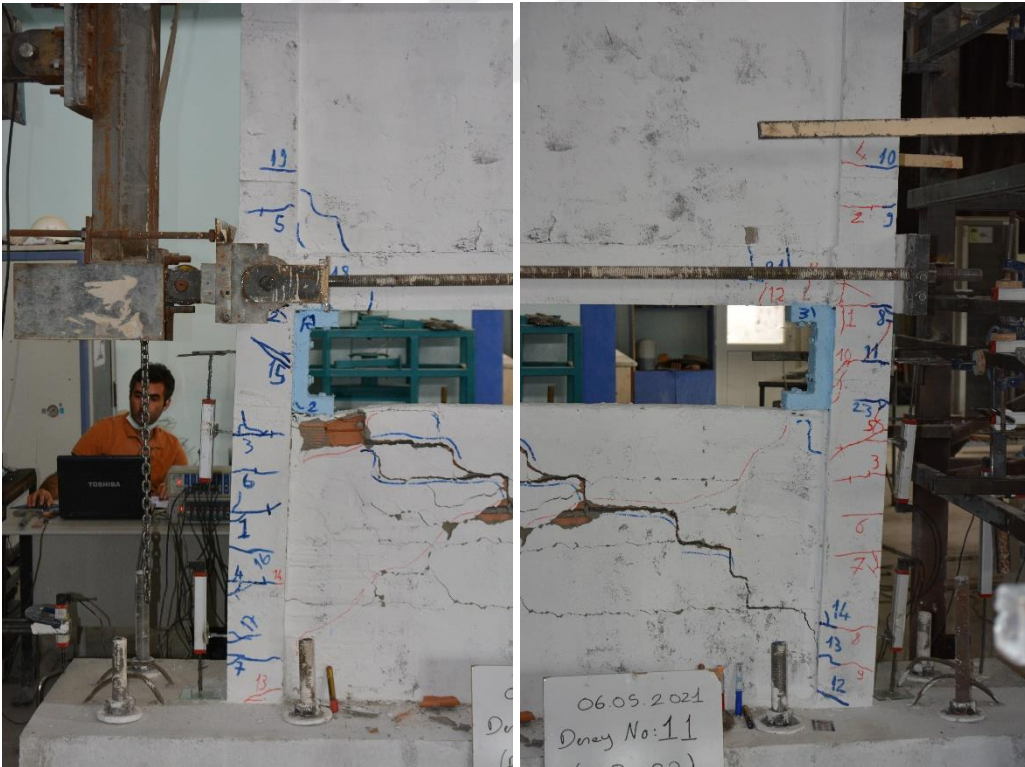
Şekil 4.133. R3-S2 numunesinin +5 çevriminde oluşan çatlaklar
