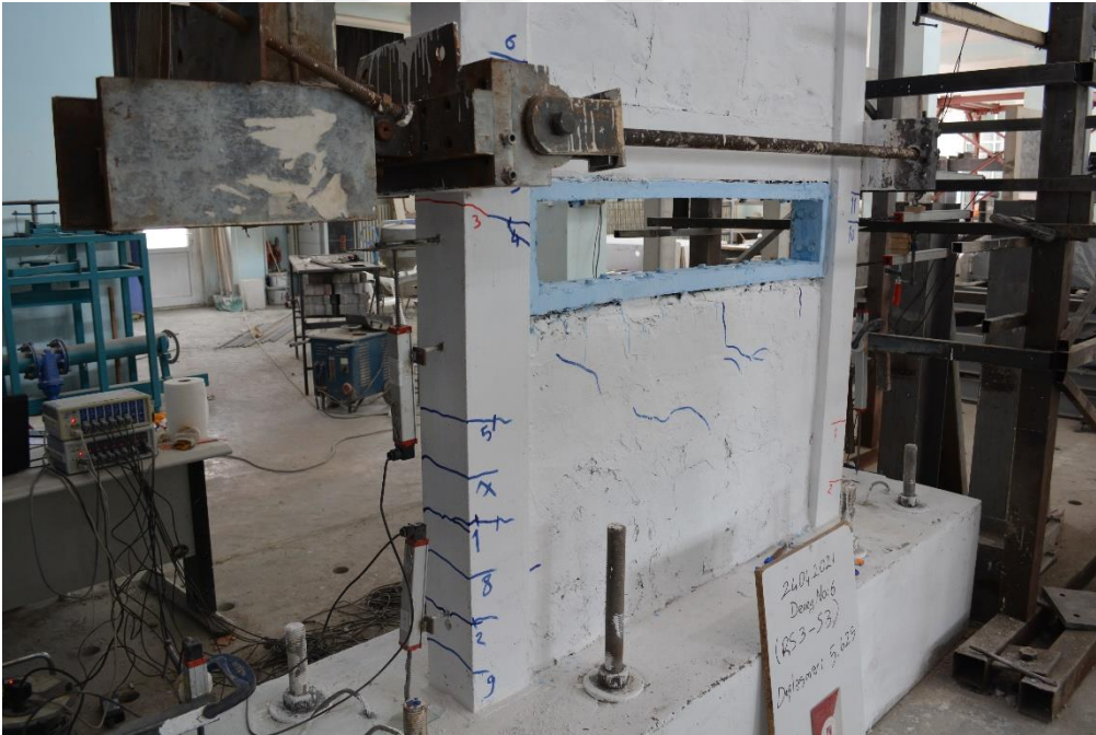
Şekil 4.177. R3-S3 numunesinin +3 çevriminde oluşan çatlaklar
