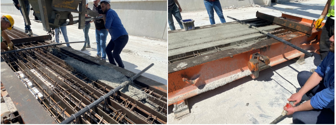
Şekil 3.27. Beton dökümü ve vibrasyon işlemi
