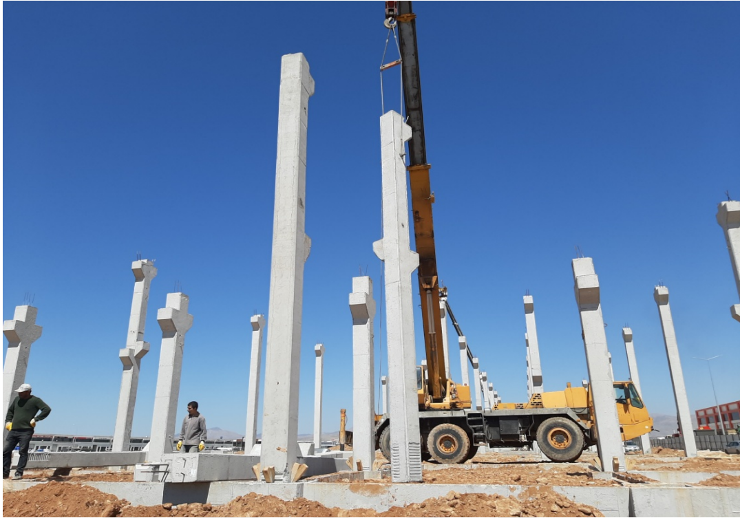
Şekil 1.3. Montaj aşamasındaki prefabrike yapı örneği
