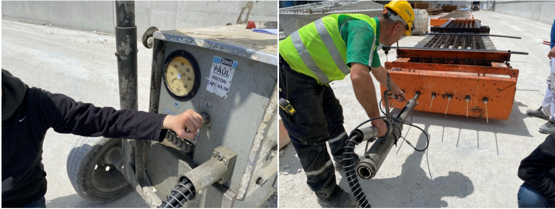
Şekil 3.21. 20 bar ilk germe işlemi.
