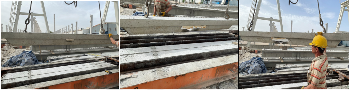
Şekil 3.53. Sırasıyla PP-1, PP-4 ve PP-3 numaralı aşıkların kalıptan alınması
