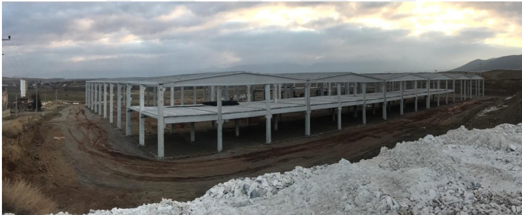
Şekil 1.4. Betonarme taşıyıcı sistemi tamamlanmış prefabrike yapı örneği
