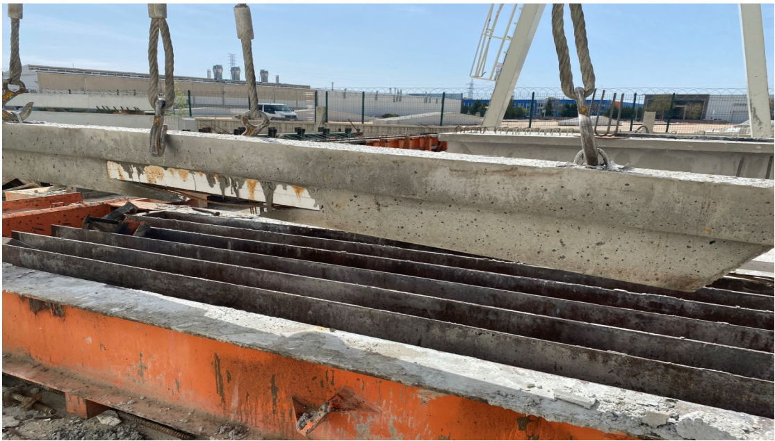
Şekil 3.44. Fire olan PP-6 numaralı aşıktaki problemin gösterimi
