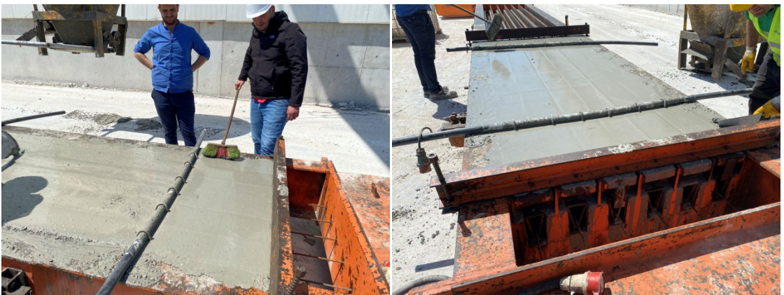
Şekil 3.28. Beton yüzey düzeltilmesi ve beton dökümünün tamamlanması.
