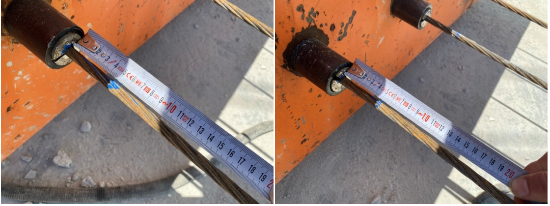
Şekil 3.23. Sırasıyla PP-5 ve PP-4 numaralı aşıkların öngerme uzama değerleri ölçümü
