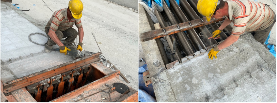
Şekil 3.51. İskelet sabitleme demirleri ve öngerme halatlarının kesilmesi
