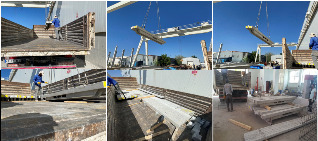
Şekil 3.56. Yüklemenin, nakliyenin ve laboratuvardaki istifin tamamlanması
