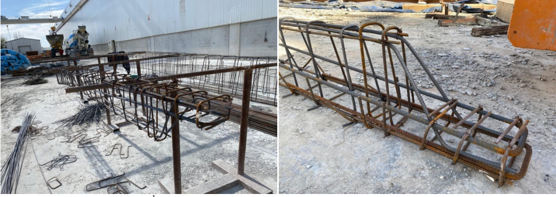
Şekil 3.37. İkinci döküm PP-6 numaralı aşık donatı hazırlanma örneği
