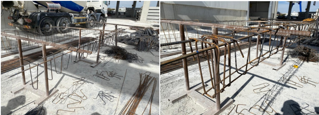
Şekil 3.36. İkinci döküm PP-6 numaralı aşık donatı hazırlanma örneği
