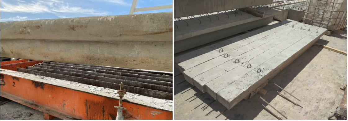
Şekil 3.34. PP-3, PP-4 ve PP-5 numaralı kirişlerin kalıptan alınıp stoka çekilmesi.
