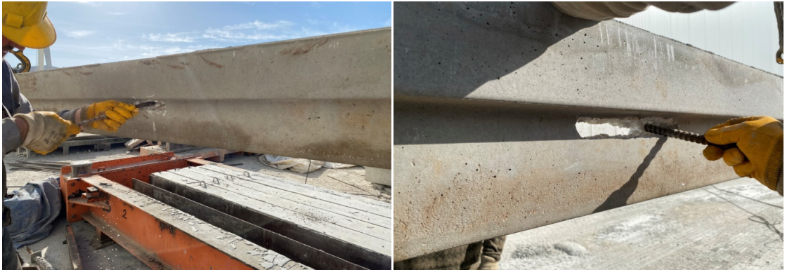
Şekil 3.32. PP-1 numaralı kiriş gövdesindeki uygun olmayan boşluğun açılması.
