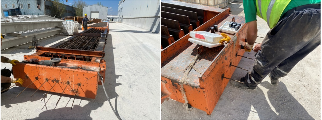
Şekil 3.19. Öngerme halatlarının sürülmesi ve öngerme çekirdek-kovanlarının yerleşimi
