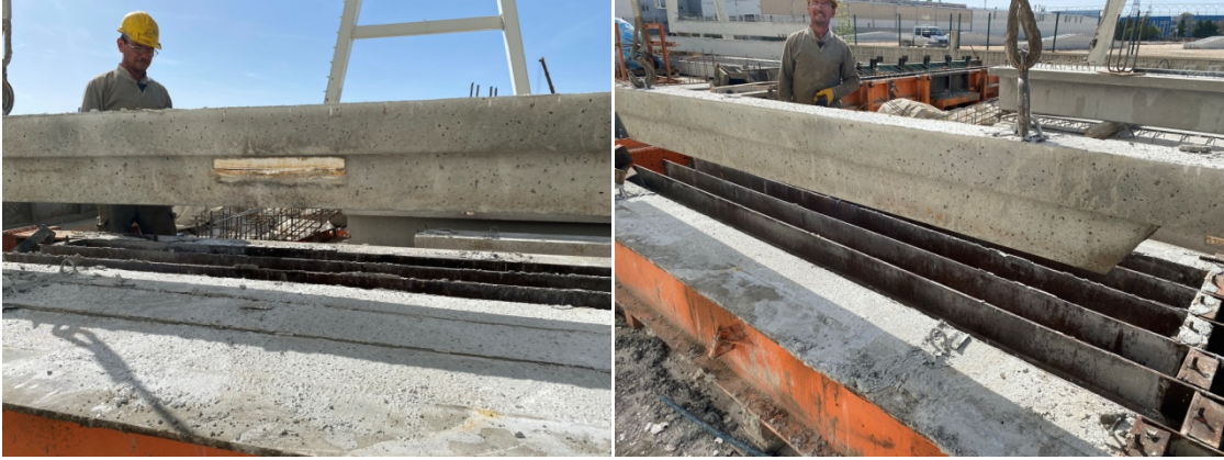
Şekil 3.43. Sırasıyla P-1 ve P-0 numaralı kirişlerin kalıptan alınması.
