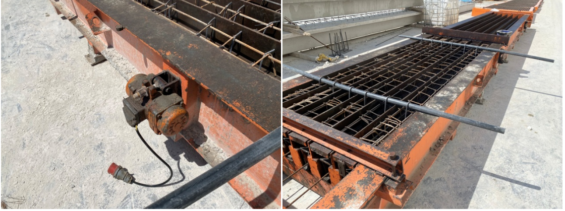
Şekil 3.26. Kalıp vibratörü ve kaldırma kancalarının yerleştirilmesi.
