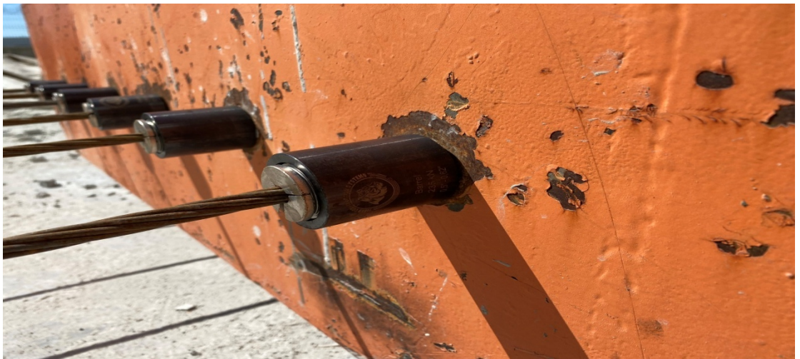
Şekil 3.20. Öngerme halatlarının ucuna yerleştirilen çekirdek ve kovanlar
