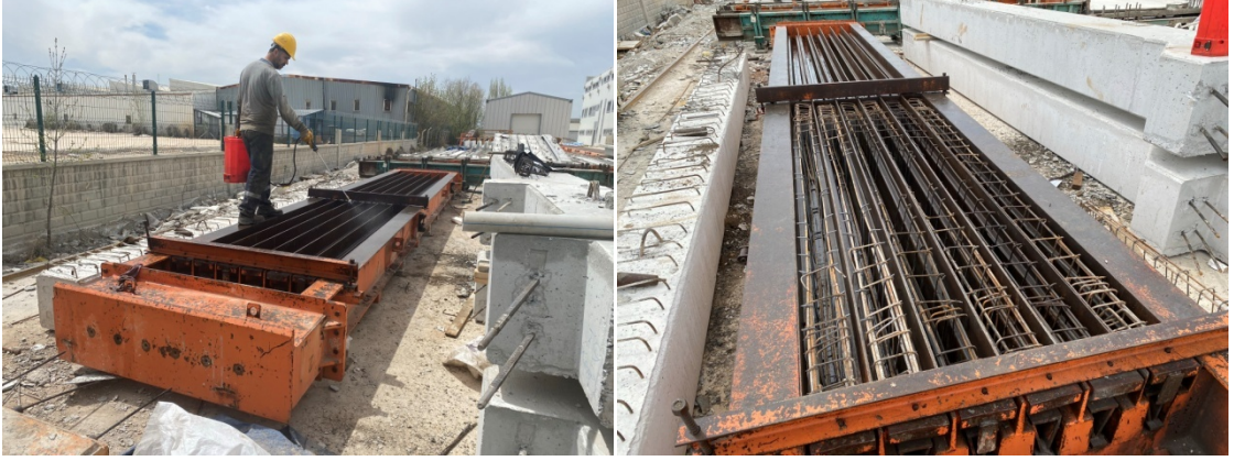
Şekil 3.18. Kalıbın yağlanması ve üretilen iskeletlerin kalıba yerleştirilmesi
