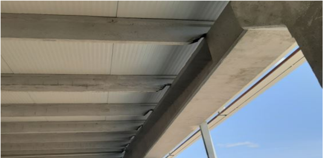
Şekil 1.13. Montajı tamamlanmış prefabrik aşık kirişleri
