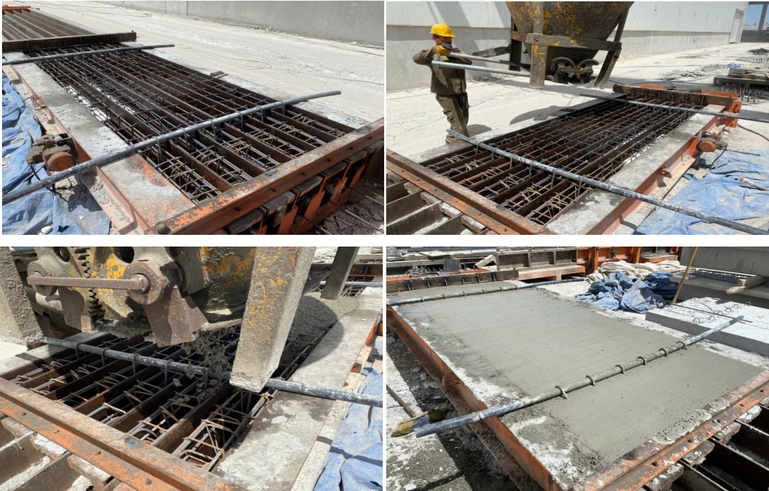
Şekil 3.50. Beton dökümünü gerçekleştirilip kalıp yüzeyinin düzeltilip dökümün tamamlanması
