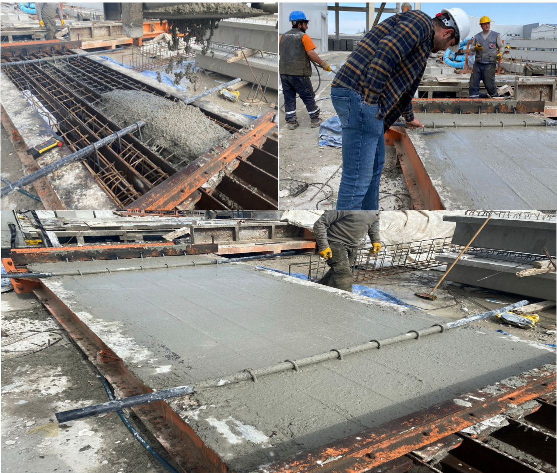
Şekil 3.40. Beton dökülp kalıp yüzeyinin düzeltilmesi ve ikinci dökümün tamamlanması.
