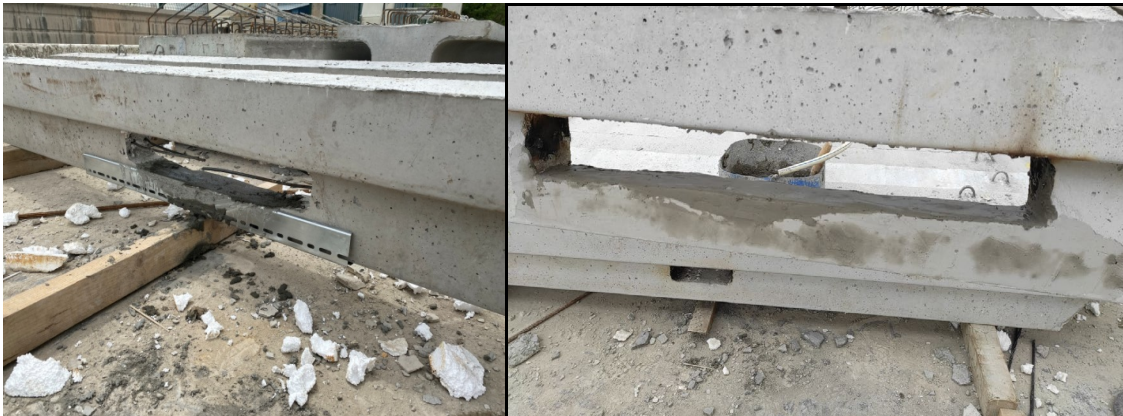
Şekil 3.54. Sırasıyla PP-3 ve PP-4 numaralı kirişlerin tadilatlarının gerçekleştirilmesi
