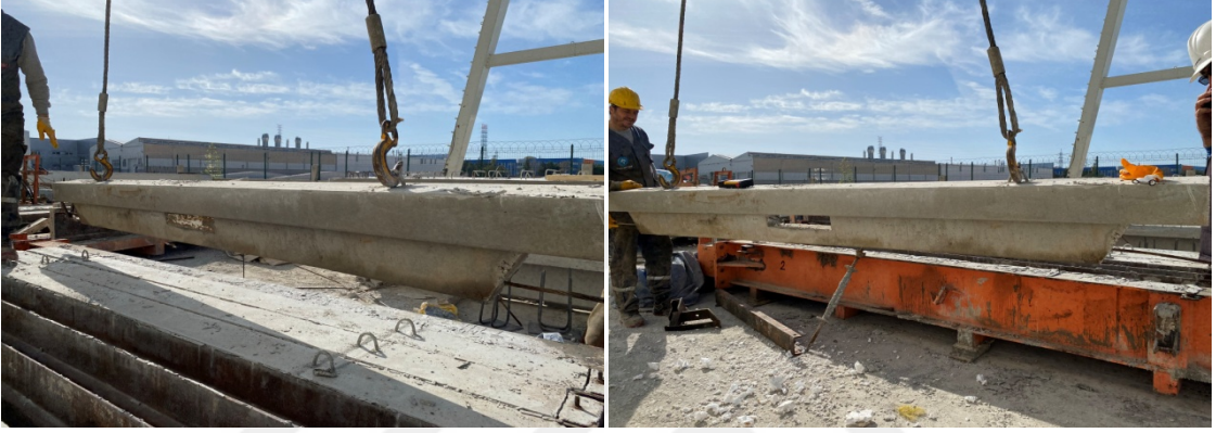
Şekil 3.33. PP-2 numaralı kirişin kalıptan alınması.
