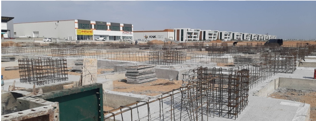
Şekil 1.1. Yerinde döküm olarak gerçekleştirilen altyapı imatları
