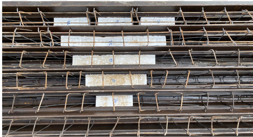
Şekil 3.15. Döküm düzenine göre straforların yerine yerleştirilmesi
