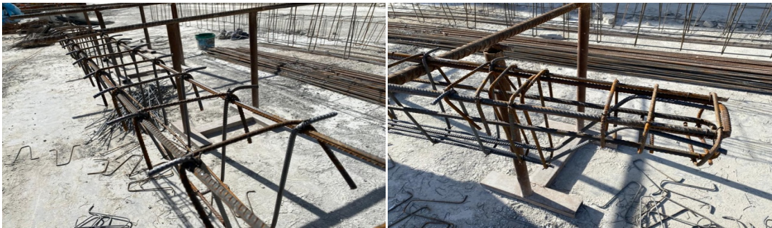
Şekil 3.46. Üçüncü döküm donatı bağlama işçilikleri
