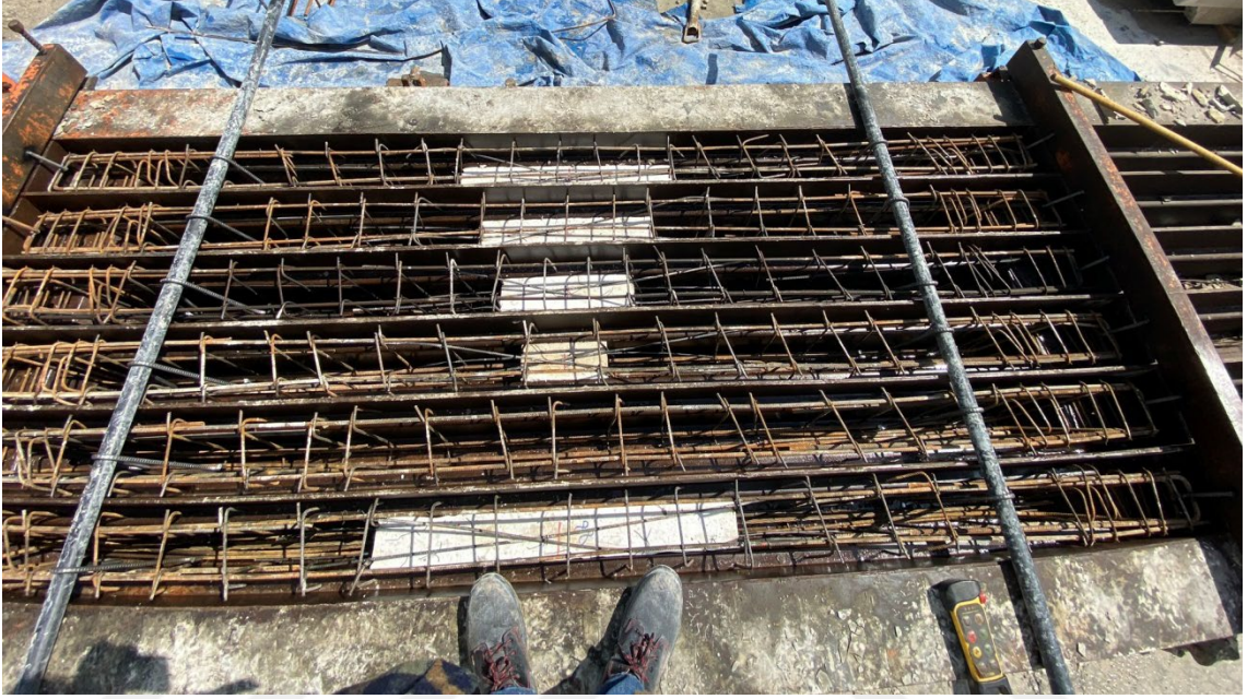
Şekil 3.35. Kalıbın üstten görünüşü.
