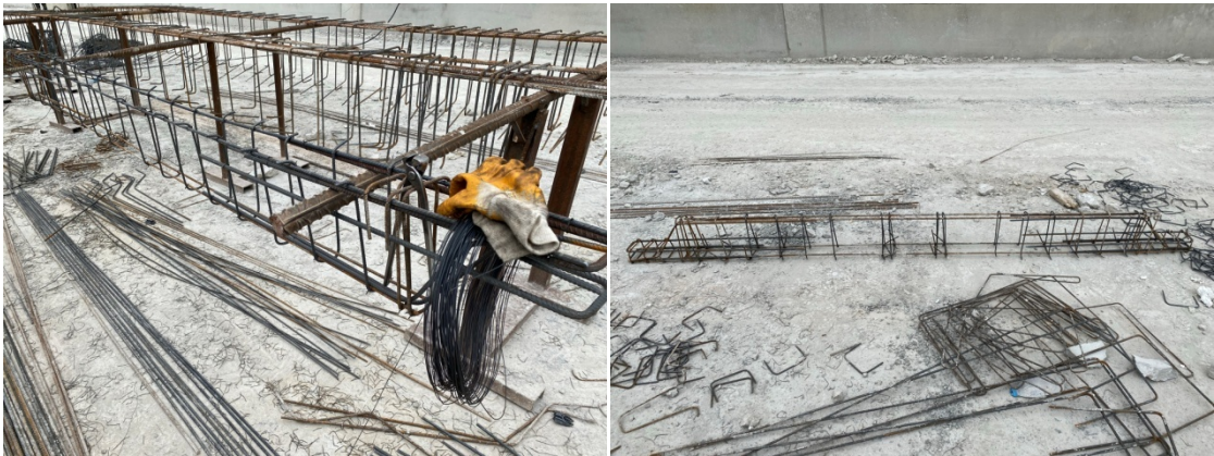
Şekil 3.17. Donatı iskeletlerinin hazırlanması
