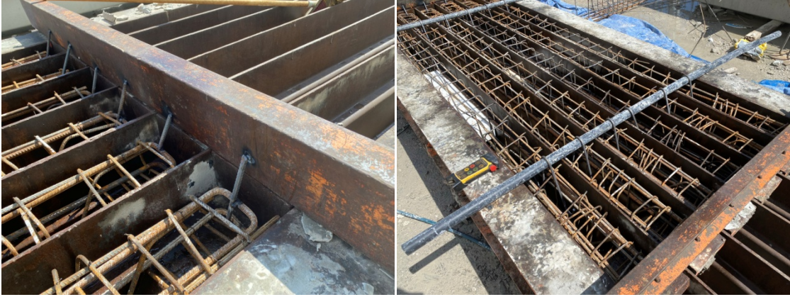
Şekil 3.39. İskeletlerin kaynakla kalıba sabitlenmesi ve kaldırma kancalarının yerleştirilmesi
