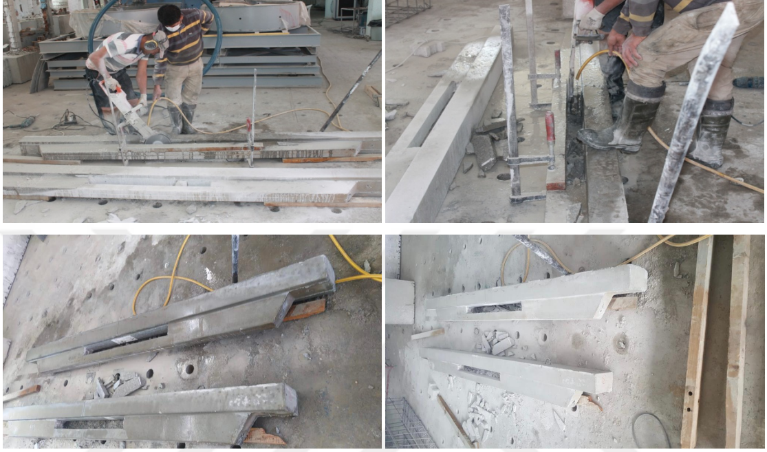
Şekil 3.57. Karot işlerinin yapıışı ve tamamlanması
