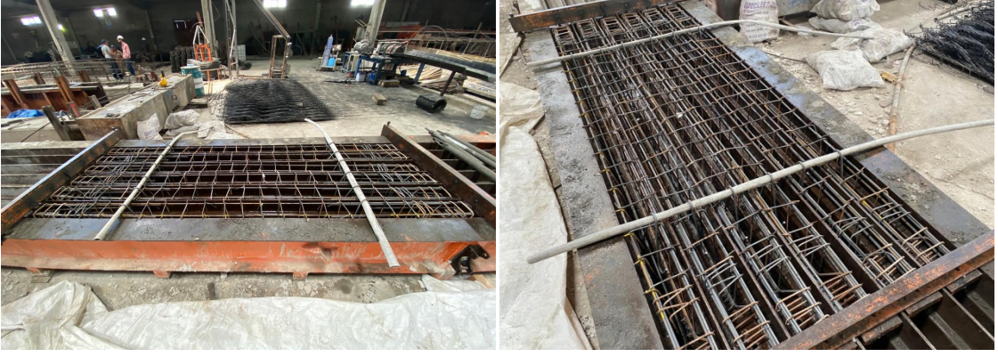
Şekil 3.55. Kalıbın beton dökümüne hazırlanmış gösterimi
