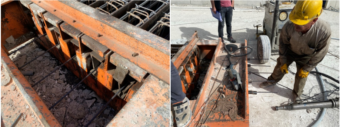
Şekil 3.48. Öngerme halatlarının sürülüp öngerme çekirdek ve kovanlarının yerleştirilmesi
