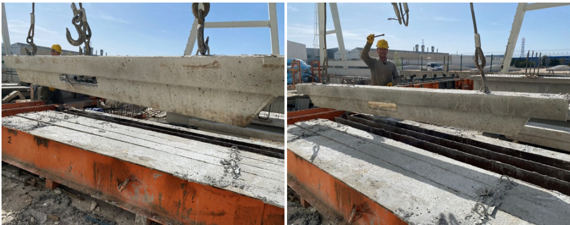
Şekil 3.42. Sırasıyla P-3 ve P-2 numaralı kirişlerin kalıptan alınması.
