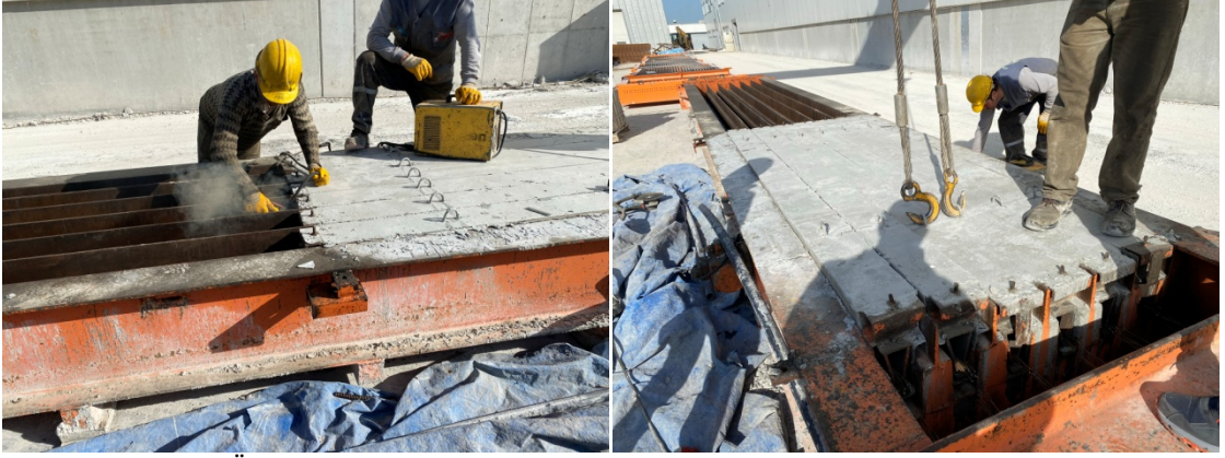
Şekil 3.30. Öngerme halatlarının kesilmesi ve kalıptaki kirişlerin şok etki ile oynatılması
