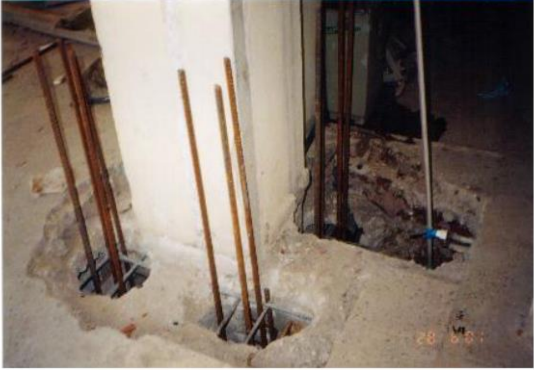
Şekil 8.7. Mantolama yapılacak bir kolona alt kattan gelen boyuna donatı ( Çevik, 2003 )
