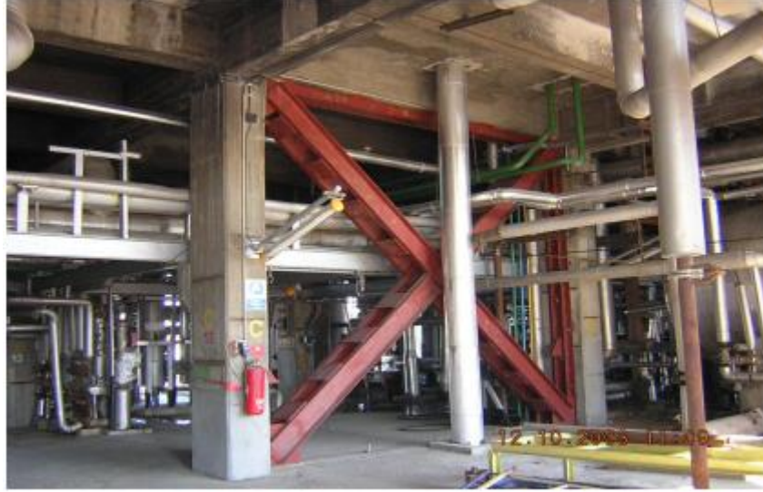
Şekil 8.28. Çelik diyagonal elemanlarla güçlendirme (Öncü, 2011)
