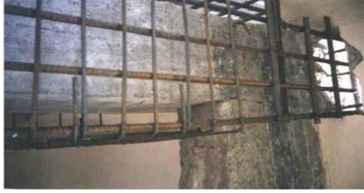
Şekil 8.16. Kiriş mantolanmasında donatılarda sürekliliğin sağlandığı bir kiriş (Öncü, 2011)
