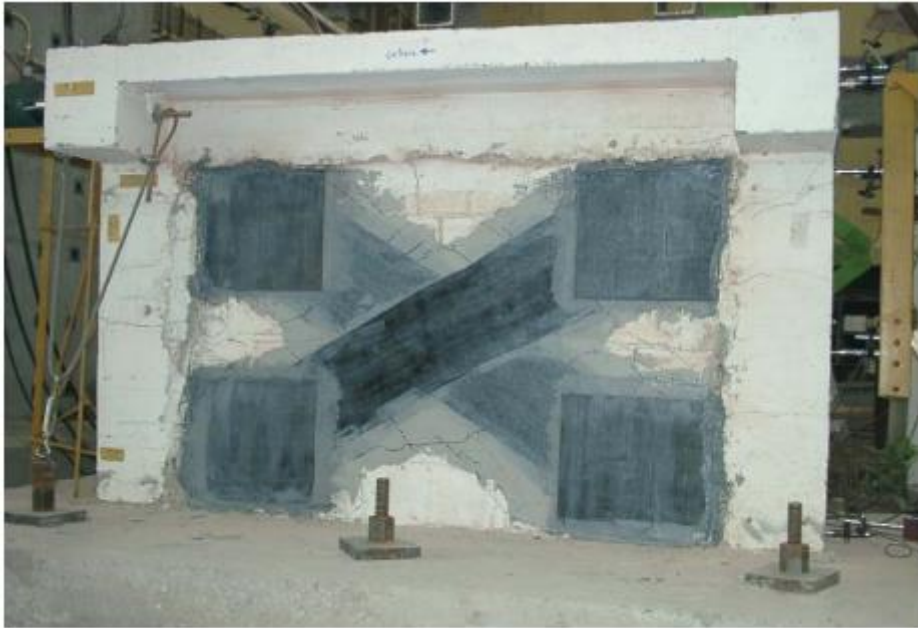
Şekil 8.23. Dolgu duvarların lifli polimer ile güçlendirilmesi (Öncü, 2011)
