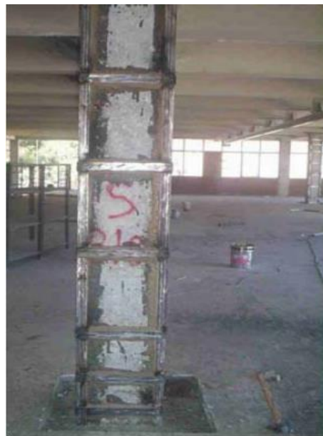
Şekil 8.2. Kolonun çelik profil iskeletle sarılarak güçlendirilmesinin sağlanması (Öncü, 2011)
