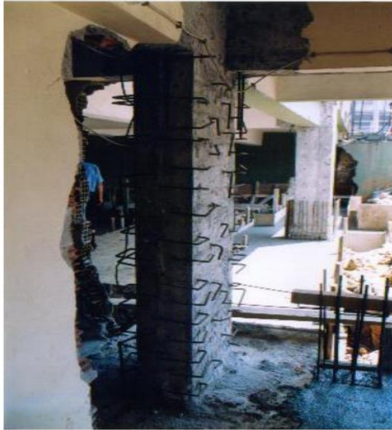
Şekil 8.8. Mantolama yapılacak bir kolona epoksili ankraj uygulanması ( Çevik, 2003 )
