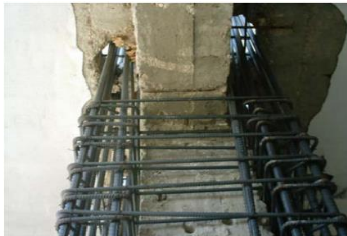
Şekil 8.5. Kolon mantolamasında donatıların sürekliliğinin sağlanması örneği (Öncü, 2011)
