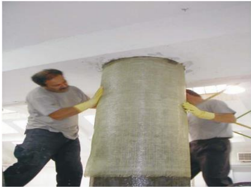
Şekil 8.9. Kolonun CFRP ile sarılarak güçlendirilmesi (Öncü, 2011)
