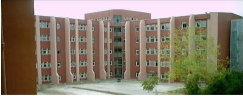
Şekil 8.30. İstanbul Üniversitesi'nde yapıya dış perdeler ekleyerek güçlendirme (Öncü, 2011)
