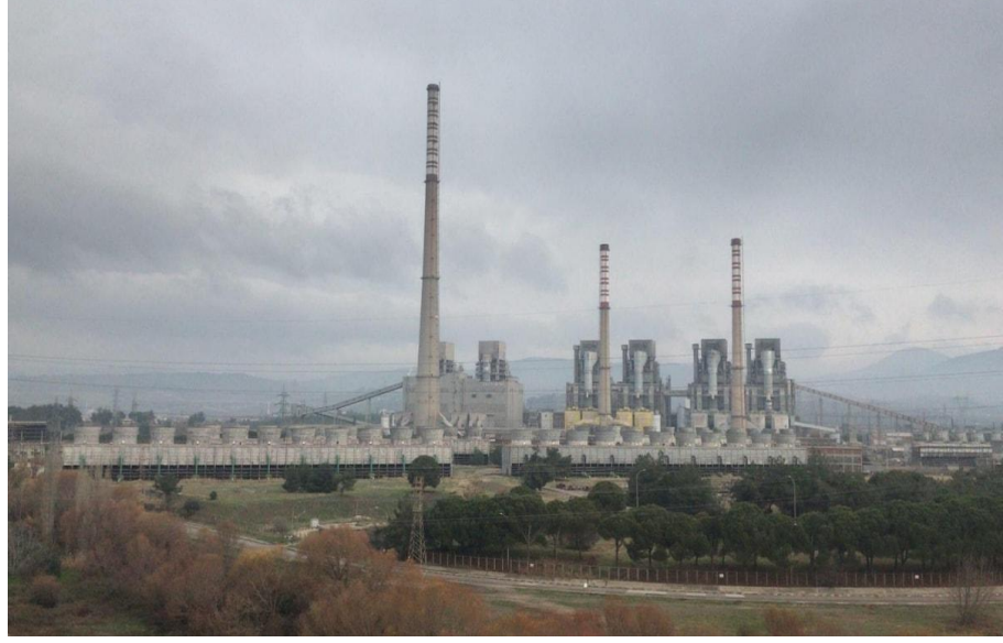
Şekil 3.13. Soma Termik Santrali
