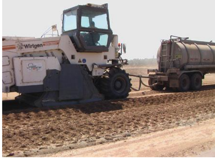
Şekil 2.4 Çimento ile Zemin Stabilizasyonu Uygulaması ( http://www.cement.org )
