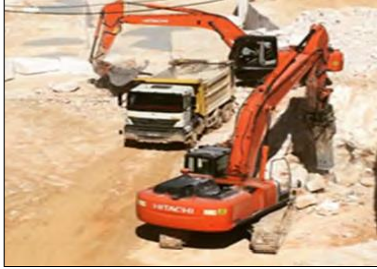
Şekil 3.2. Hidrolik kırıcı ve pasanın yüklenme durumu (Güneş ve Arkadaşları, 2017)
