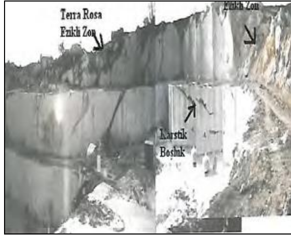
Şekil 1.2. Pınarlı tepe Güneyinde işletilen mermer ocağı ve ocakta gözlenen süreksizlikler, karstik boşluklar ve ezikli zonlar (Uz ve Yıldız, 2017)
