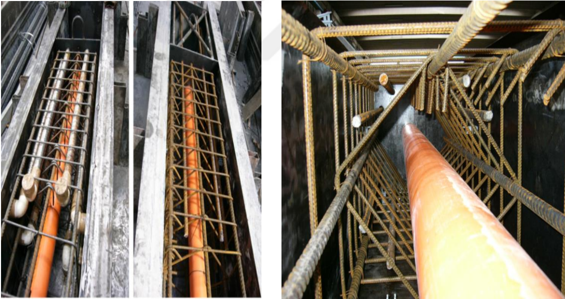
Şekil 2.11. Tüplerin kolon içine montajı (Tullini ve Minghini, 2016)
