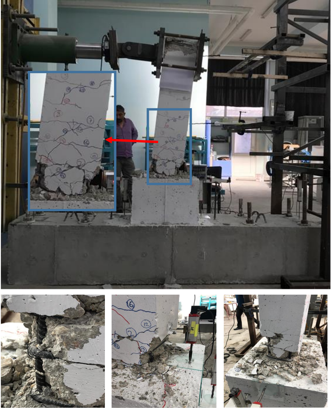
Şekil 4.17. KN2 numunesinin göçme durumuna ulaştığında hasar durumu
