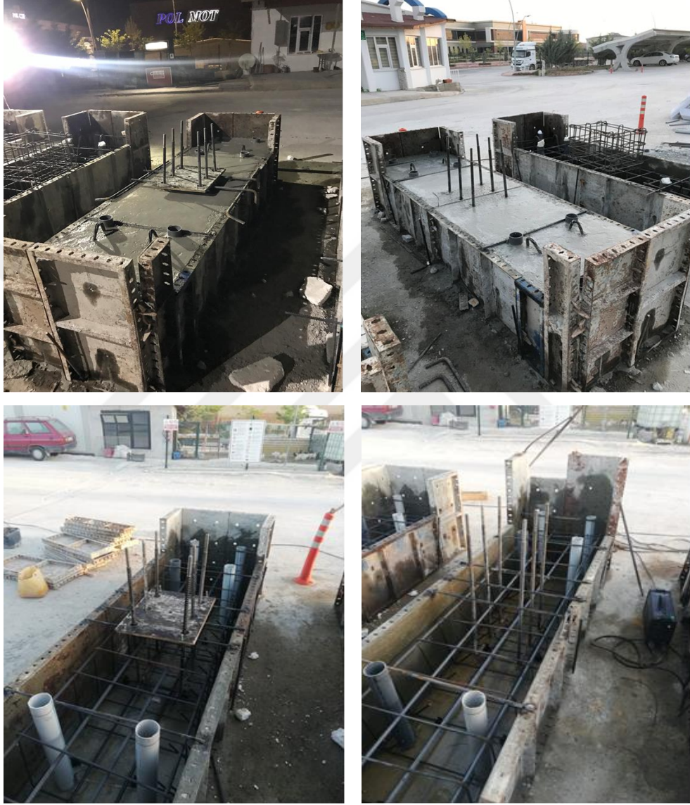
Şekil 3.12. Ankrajlı birleşimde temel üretim aşamaları
