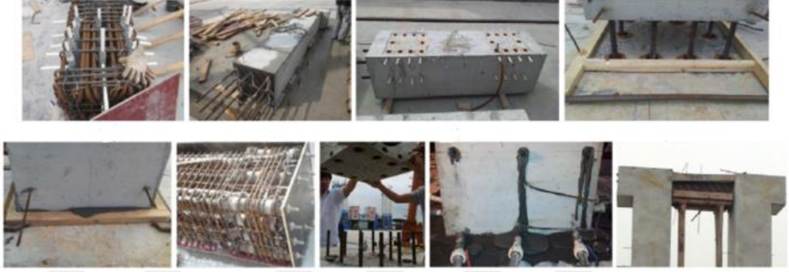
Şekil 2.9. Tüplerin teşkil edilmesi aşamaları (Qu ve ark., 2018)
