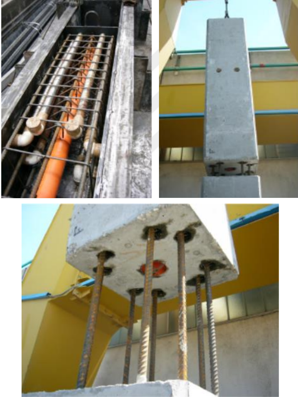
Şekil 1.32. Kolon-kolon tüplü birleşim (Tullini ve Minghini, 2016)
