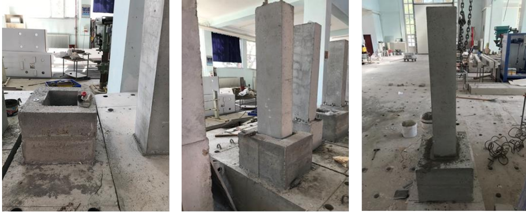
Şekil 3.21. Soketli bağlantı montaj aşamaları
