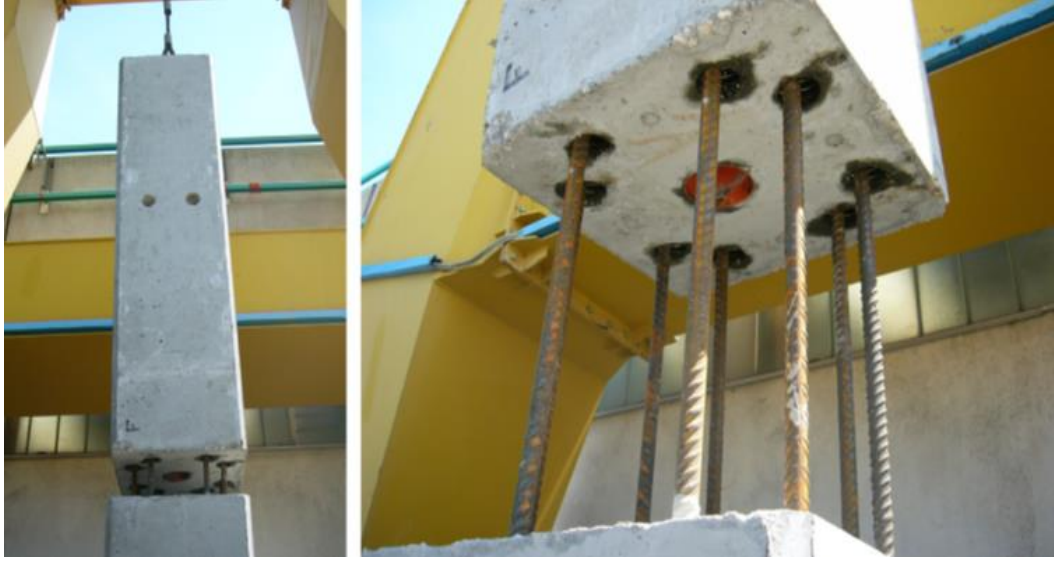
Şekil 2.12. Kolonların montajının yapılması (Tullini ve Minghini, 2016)
