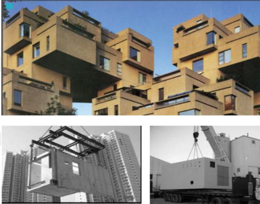
Şekil 1.24. Çok katlı hücre sistemler (Uçar ve Barka, 2011)
