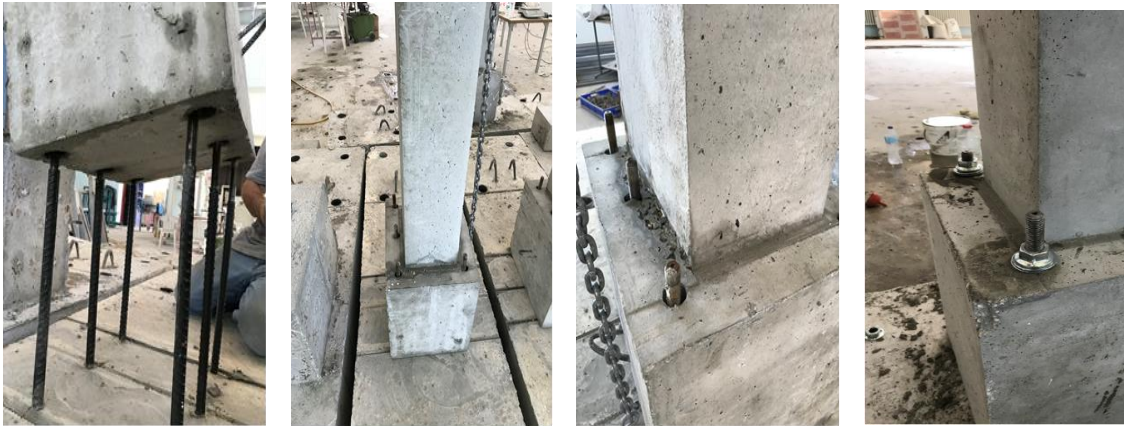
Şekil 3.22. Ankrajlı bağlantı montaj aşamaları
