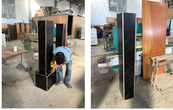
Şekil 3.13. Kolon kalıbı imalatı
