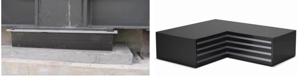
Şekil 1.26. Elastomerik ara malzemeli birleşim
