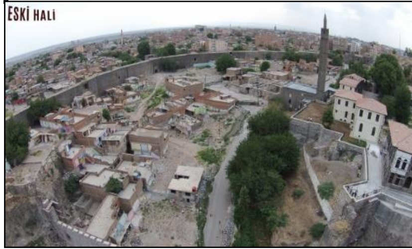
Şekil 4. 63. Diyarbakır Sur İlçesi İçkale Mevkiinin eski hali (Çevre ve Şehircilik Müdürlüğü, 2019)
