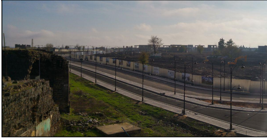
Şekil 4. 47. Fatihpaşa Mahallesi'nde yıkım sürecinden sonra inşa edilen yeni yapılar (Kişisel Arşiv, 2019)
