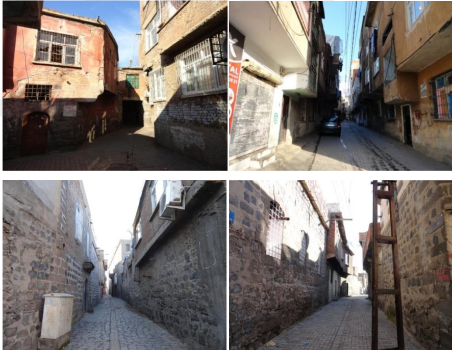
Şekil 4. 108. Suriçi'nde bakımsız ve güvensiz sokaklardan görünüm (Kişisel arşiv, 2020)
