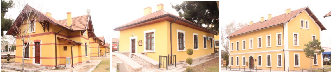
Resim 4.20. Tren Garı Planları Lojmanları. Sırası ile 41, 27 ve 9 kapı numaralı lojmanlar.
