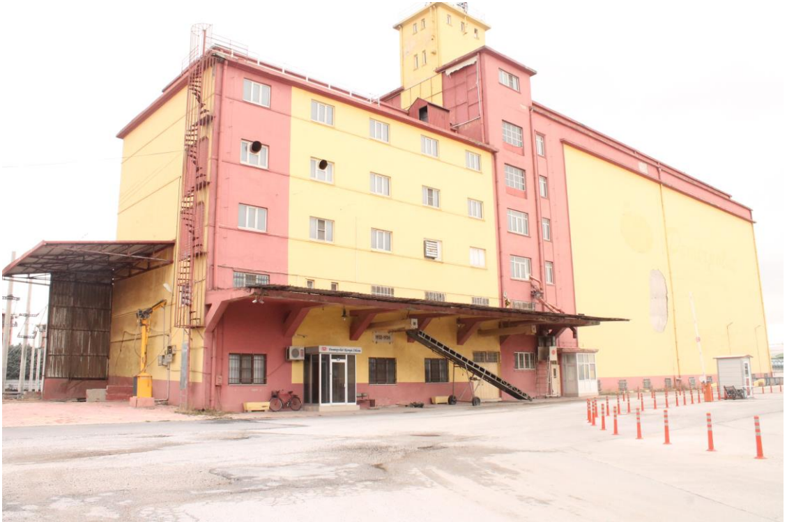
Resim 4.31. Konya Buğday Silosu-Demirpolat Konya Silosu günümüzdeki hali.
