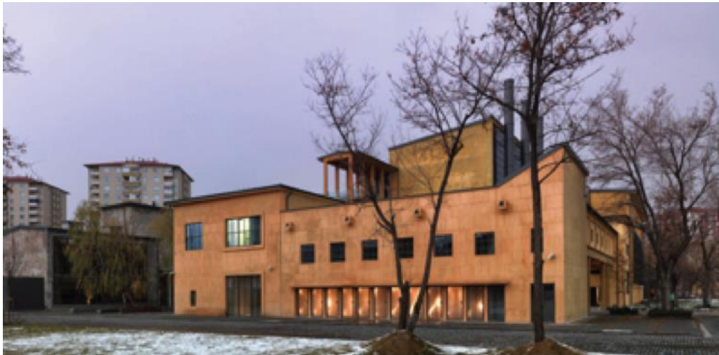
Resim 3.30. Elektrik Santrali Binası(C. Emden, 2016)
