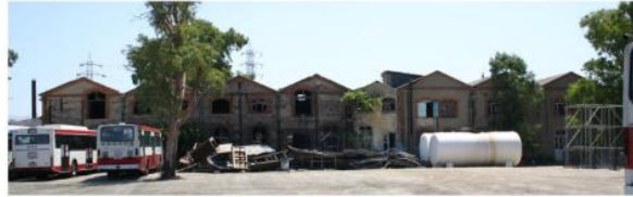
2006-2007 yılları batı cephesi
