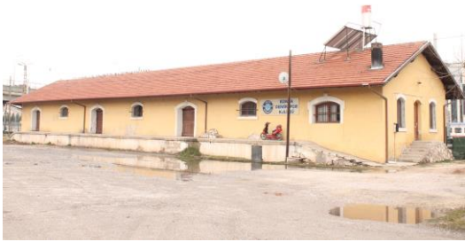
Resim 4.24. Tren Garı Hangarı
