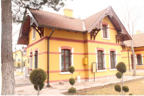
37 kapı numaralı lojman yeni işlevi Ekinoğlu Meram Acil Sağlık Merkezi
