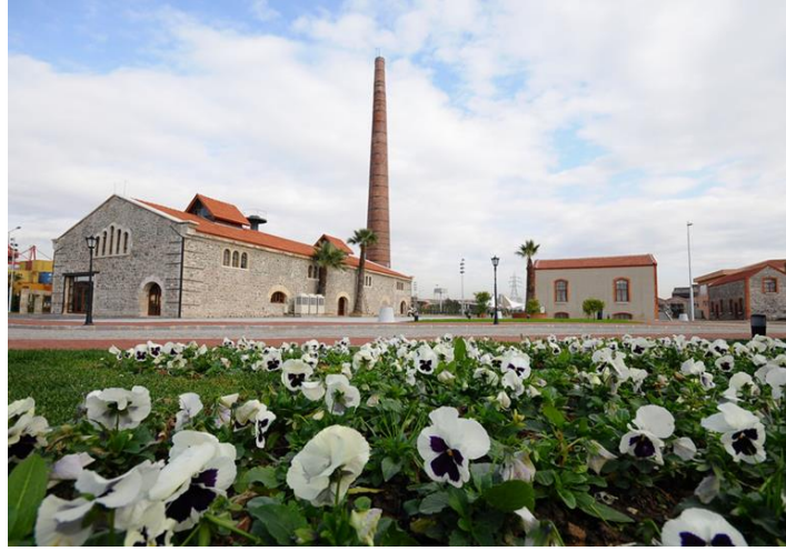
Resim 3.27. Restorasyon sonrası Havagazı Fabrikası görünümü (Uludağ, Yılmaz, 2008).
