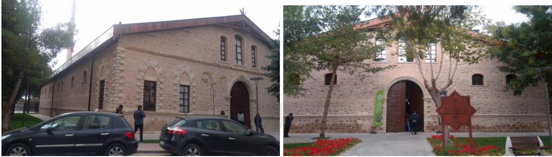
Resim 4.26.- Resim 4.27. Restorasyon sonrası Tantavi Ambarı kuzey ve güney cephe görünümü.
