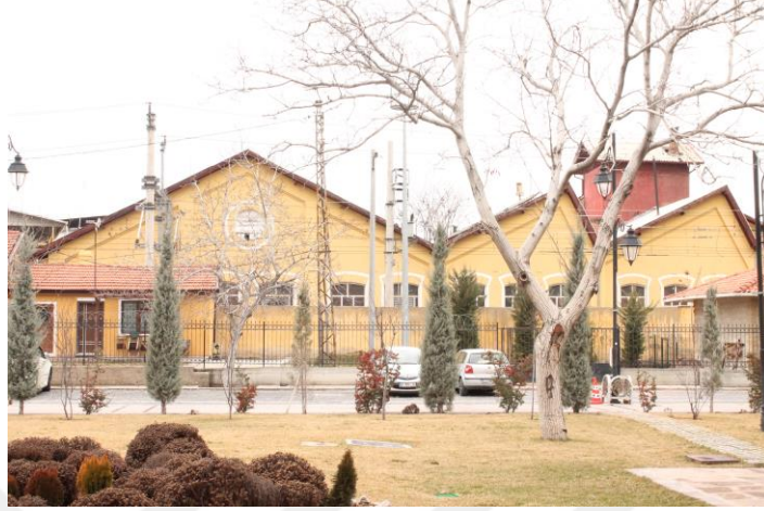
Resim 4.23. Lokomotif Tamir Atölyesi Doğu Cephe Görünüm.
