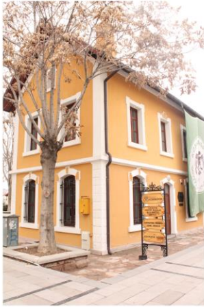
13 Nolu Lojman yeni işlevi Konya Spor Binası
