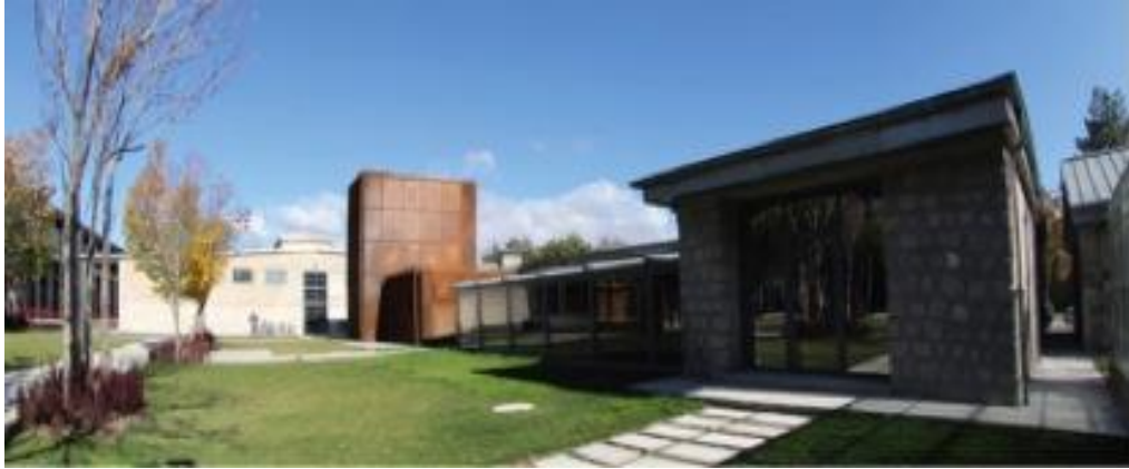
Resim 3.29. İtfaiye ve Büro Binası(B. Asiliskender, 2016)
