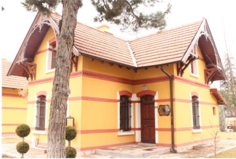
33 kapı numaralı lojman yeni işlevi Amatör Spor Kulüpleri Federasyonu
