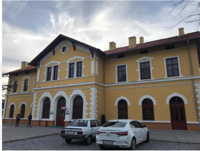
Resim 4.19. Tren Garı Binası Giriş Cephesi görünümü.
