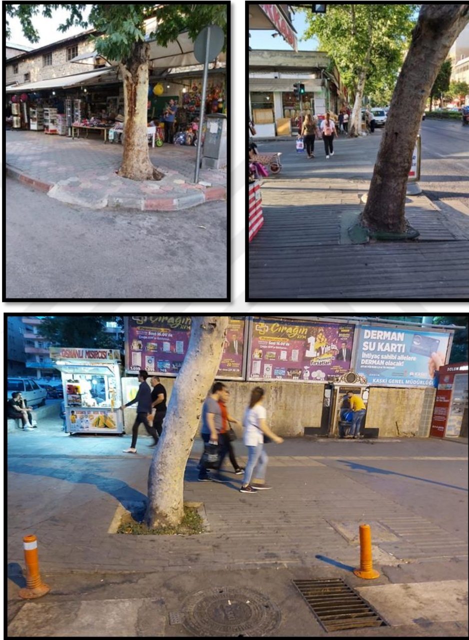
Şekil 7.17. Üzerinde engel bulunan rampalardan örnekler
