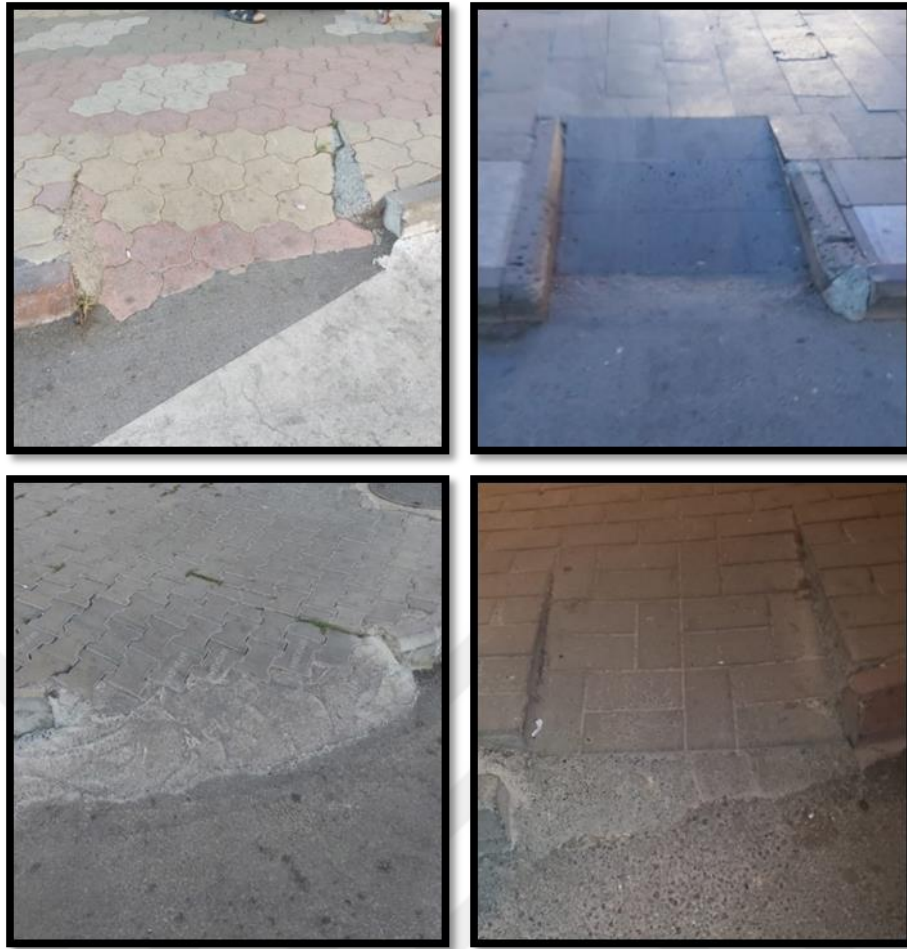
Şekil 7.18. Ölçü kriterlerini sağlamayan rampalardan örnekler
