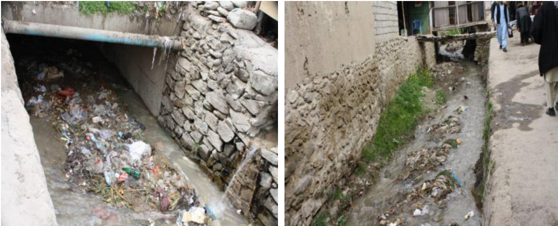
Şekil 4.7.1.2: Nehre Bağlanan Açık Kanalizasyon Şebekeleri (Kişisel Arşiv, 2020).
