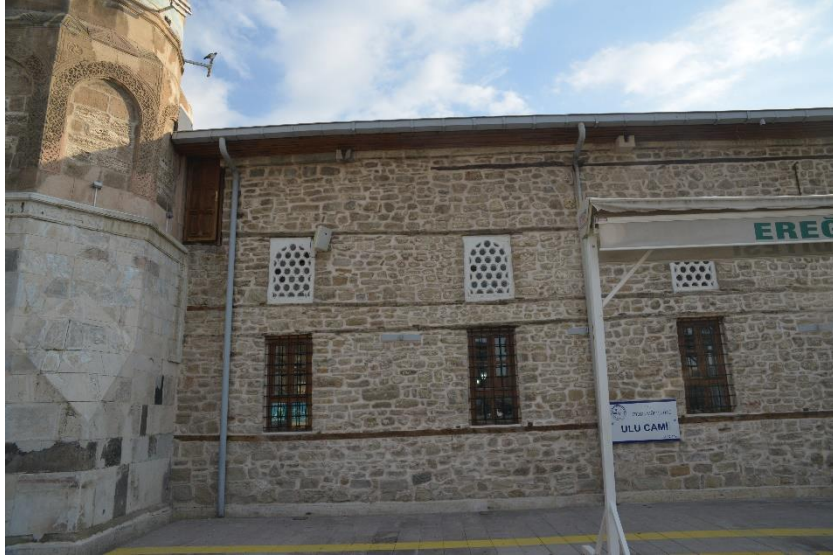
Şekil 4. 152. Ereğli Ulu Camii kuzey cephenin doğu kısmı
