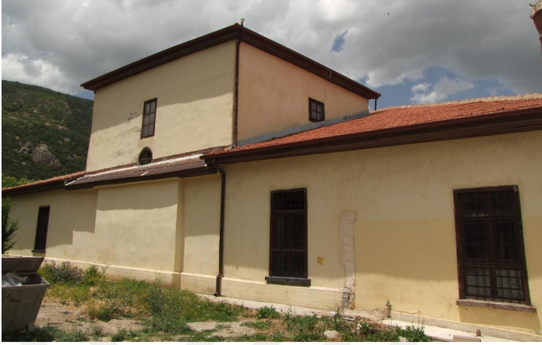
Şekil 4. 43. Akşehir Ulu Camii güney cephe
