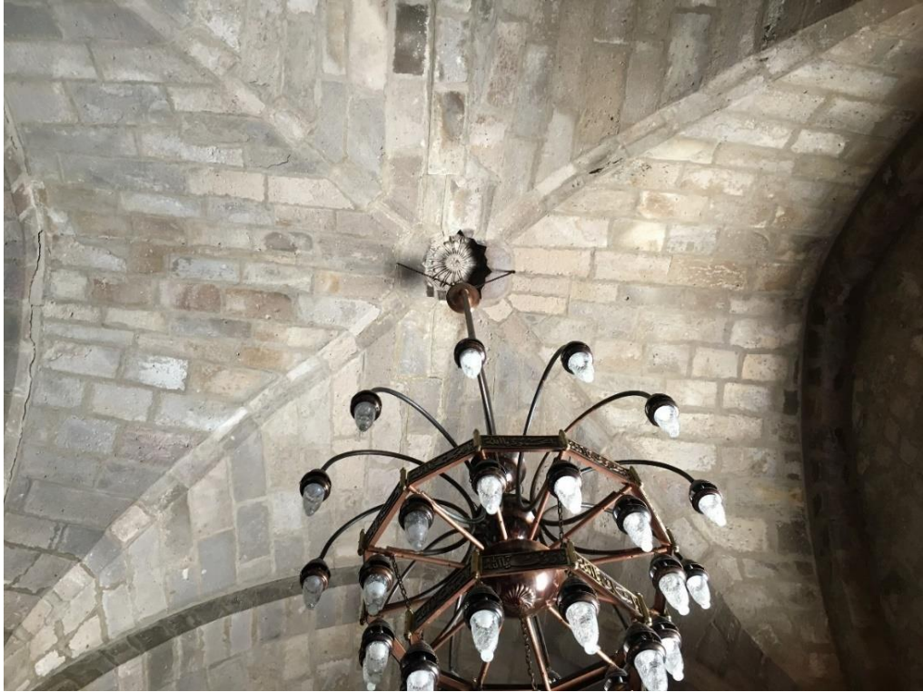
Şekil 4. 104. Aksaray Ulu Camii çapraz tonoz görünüşü
