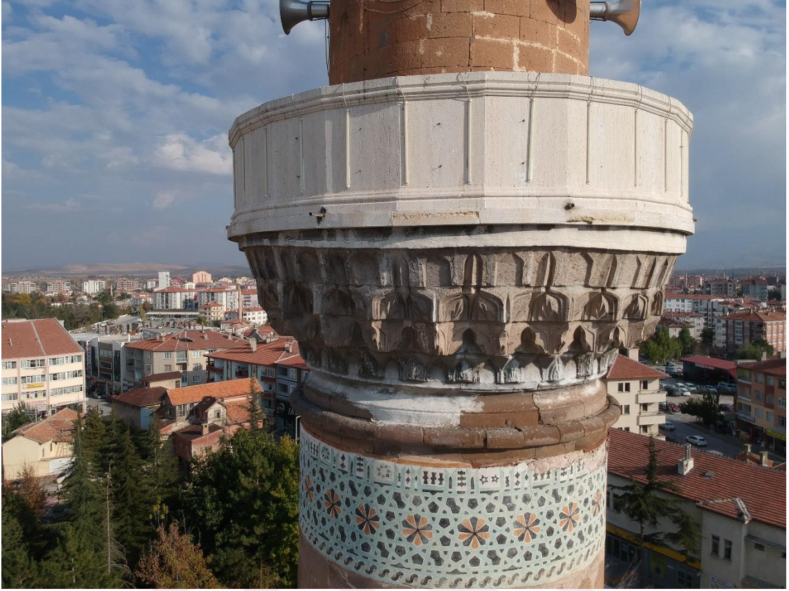
Şekil 4. 180. Ereğli Ulu Camii minare şerefesi ve mukarnaslı şerife altı
