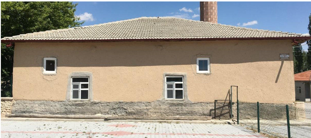
Şekil 4. 291. Eşmekaya Ulu Camii kuzey cephe
