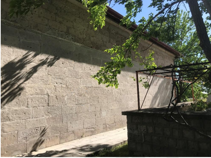
Şekil 4. 305. Yeşilova Ulu Camii kuzey cephe
