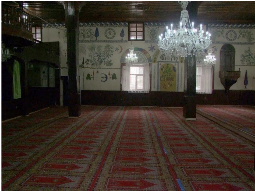
Şekil 4. 324. Deşdiğin Ulu Camii harim doğu duvarı
