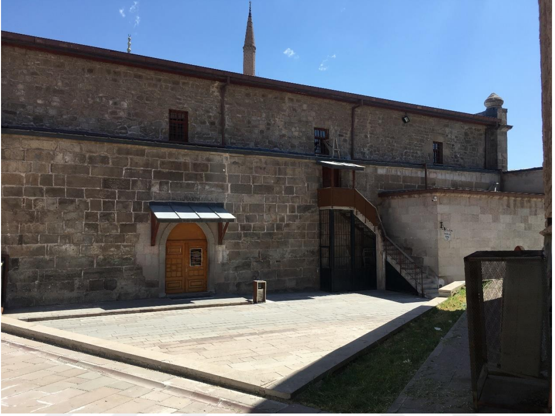
Şekil 4. 92. Aksaray Ulu Camii kuzey cephenin batı kısmı
