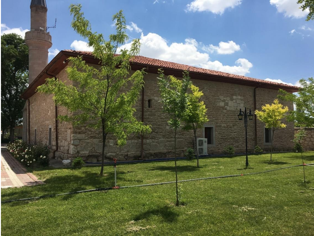
Şekil 4. 232. Eski Ulu Camii batı cephesi
