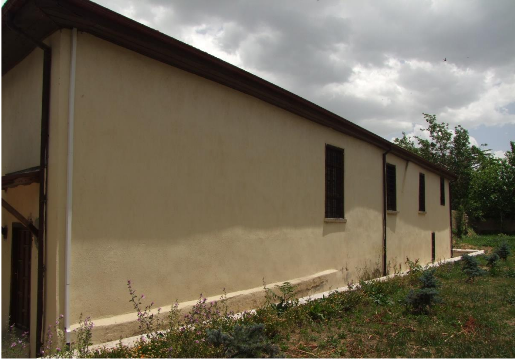
Şekil 4. 44. Akşehir Ulu Camii batı cephe
