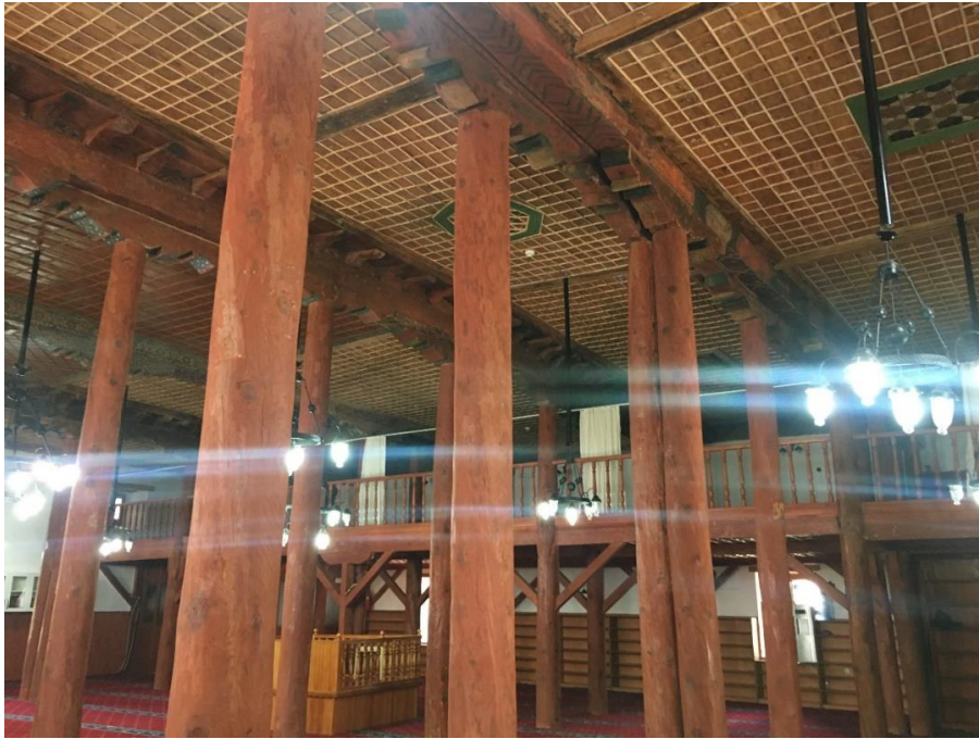
Şekil 4. 239. Eski Ulu Camii tavan ve ahşap başlıklar
