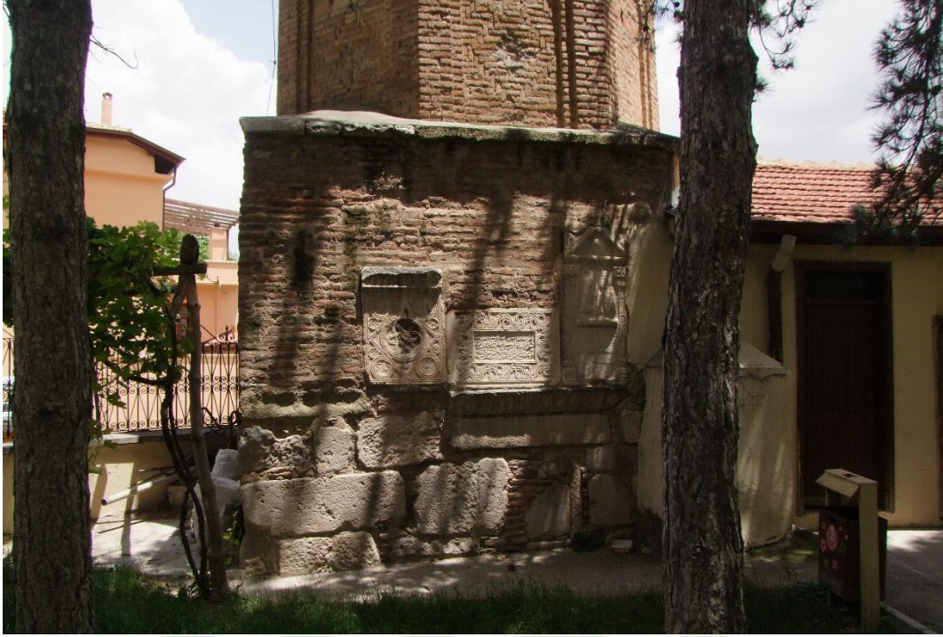
Şekil 4. 55. Akşehir Ulu Camii minare kaidesi
