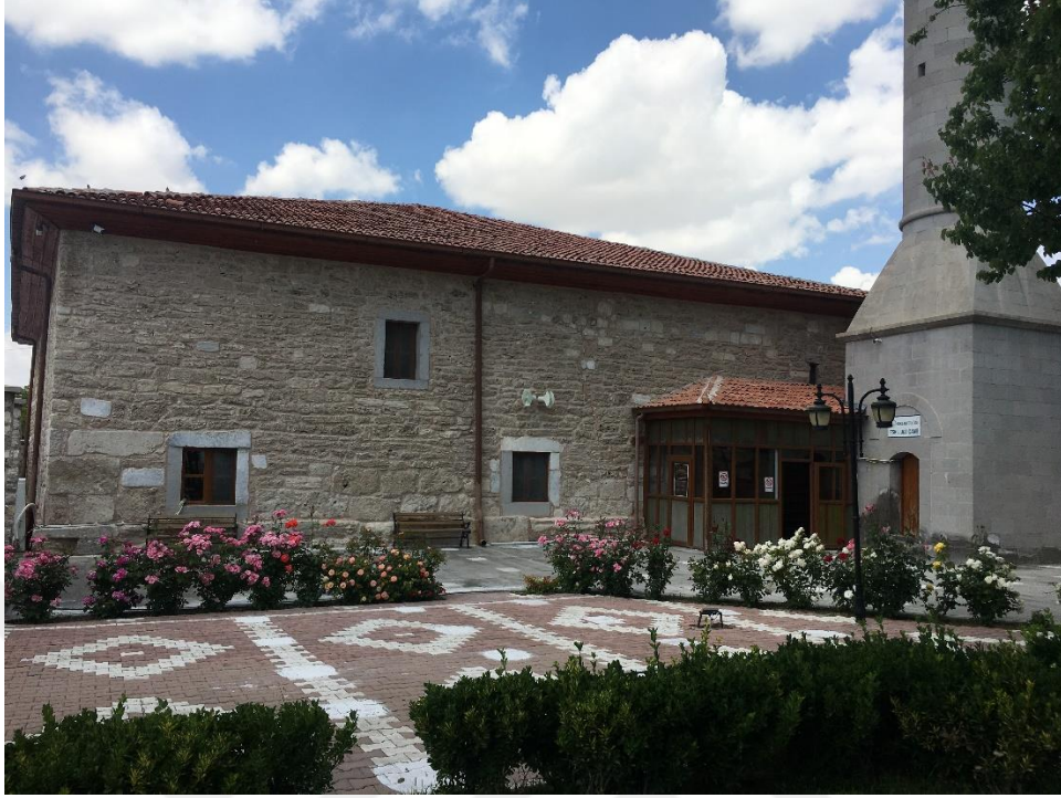
Şekil 4. 226. Aksaray Eskill Ulu Camii doğu cephe genel görünüş
