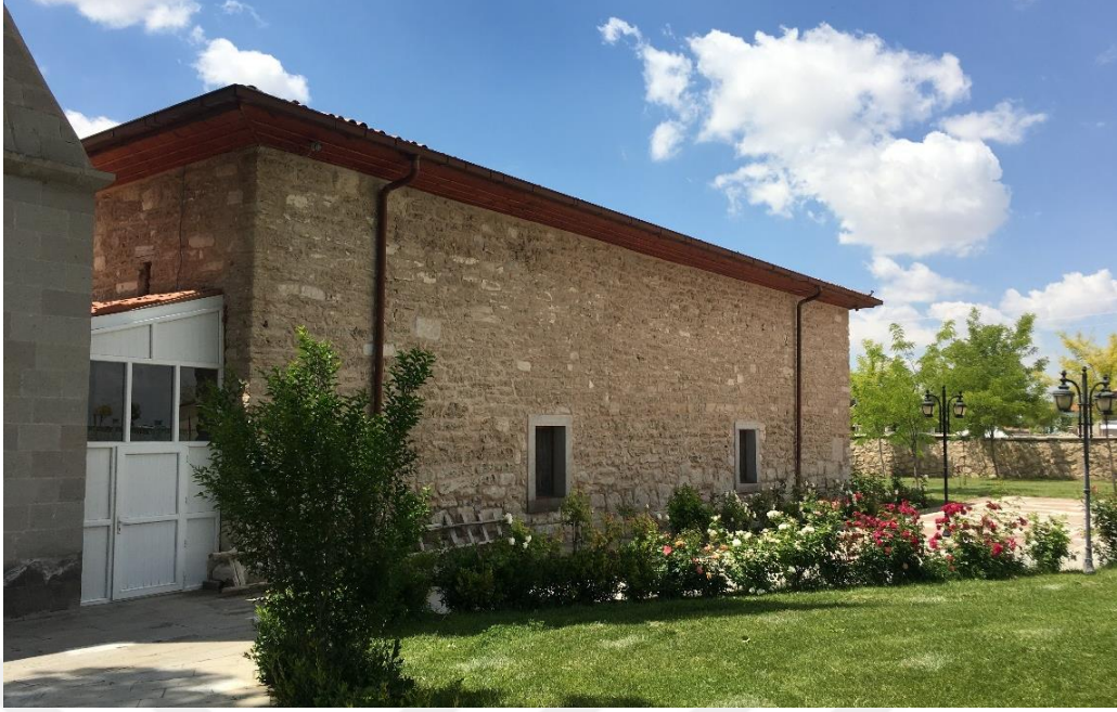
Şekil 4. 231. Eski Ulu Camii kuzey cephesi
