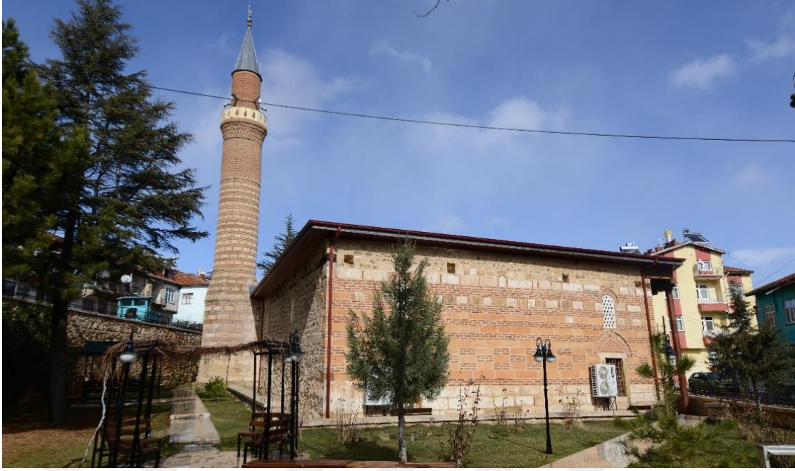
Şekil 4. 213. Doğanhisar Ulu Camii batı ve güney cephe görünüşü
