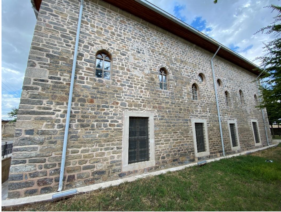
Şekil 4. 199. Akçaşchir Ulu Camii güney cephe
