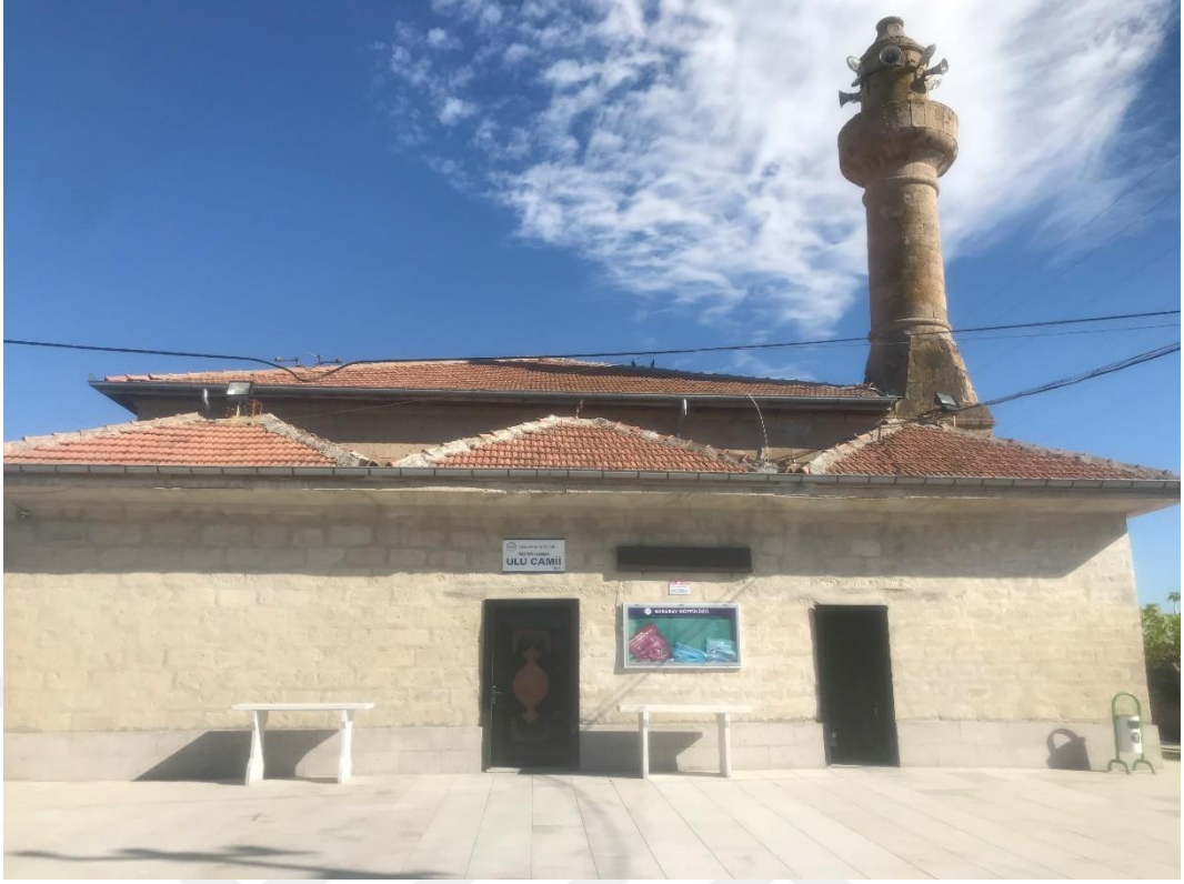
Şekil 4. 350. Yeşiltepe Ulu Camii kuzey cephe
