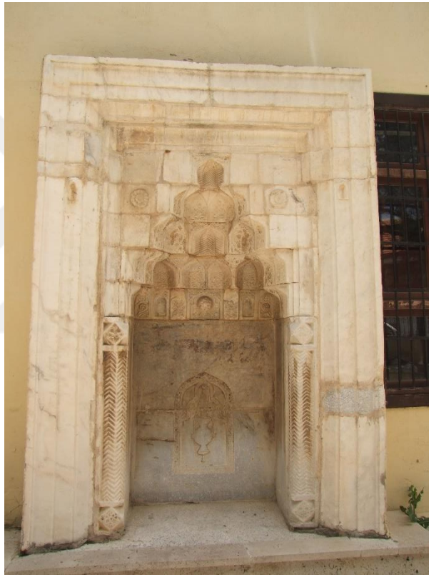
Şekil 4. 52. Akşehir Ulu Camii son cemaat mahallinde yer alan mihrabı
