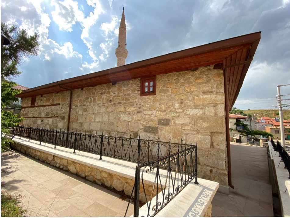
Şekil 4. 251. Başköy Ulu Camii güney cephe
