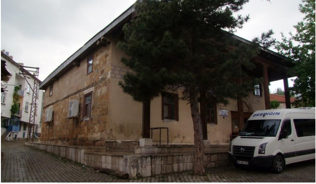
Şekil 4. 317. Deşdiğın Ulu Camii dođu ve güney cephe
