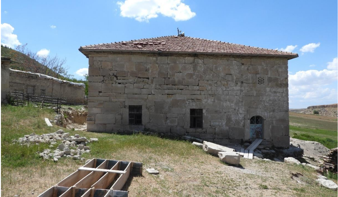
Şekil 4. 338. Ayrancı Pınarkaya Ulu Camii doğu cephe görünüşü
