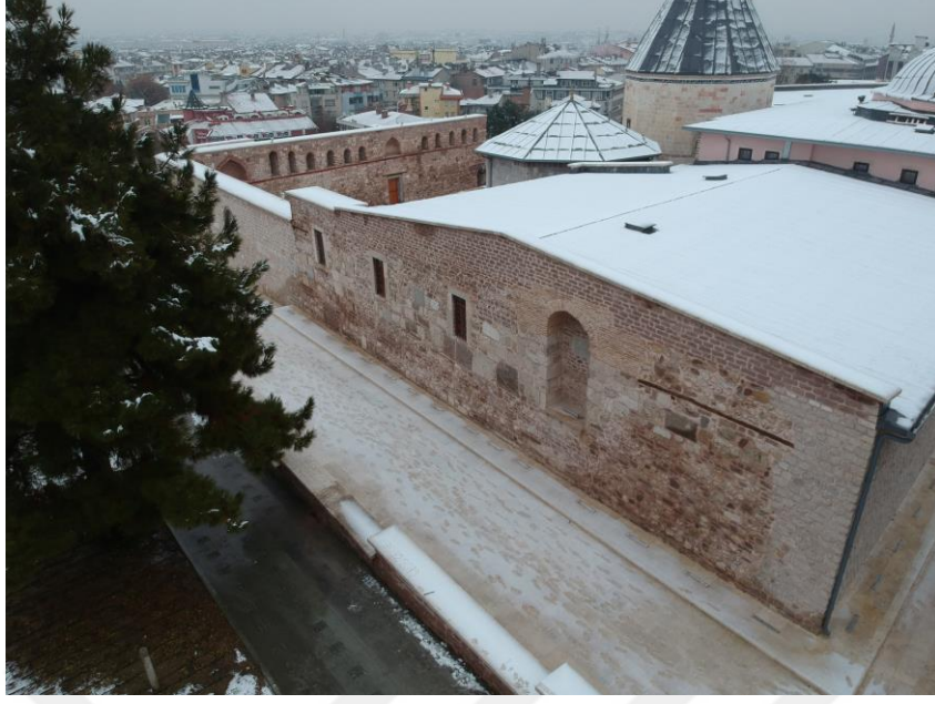
Şekil 4. 21. Konya (Alaeddin) Ulu Camii batı cephe güney kısım görünüşü
