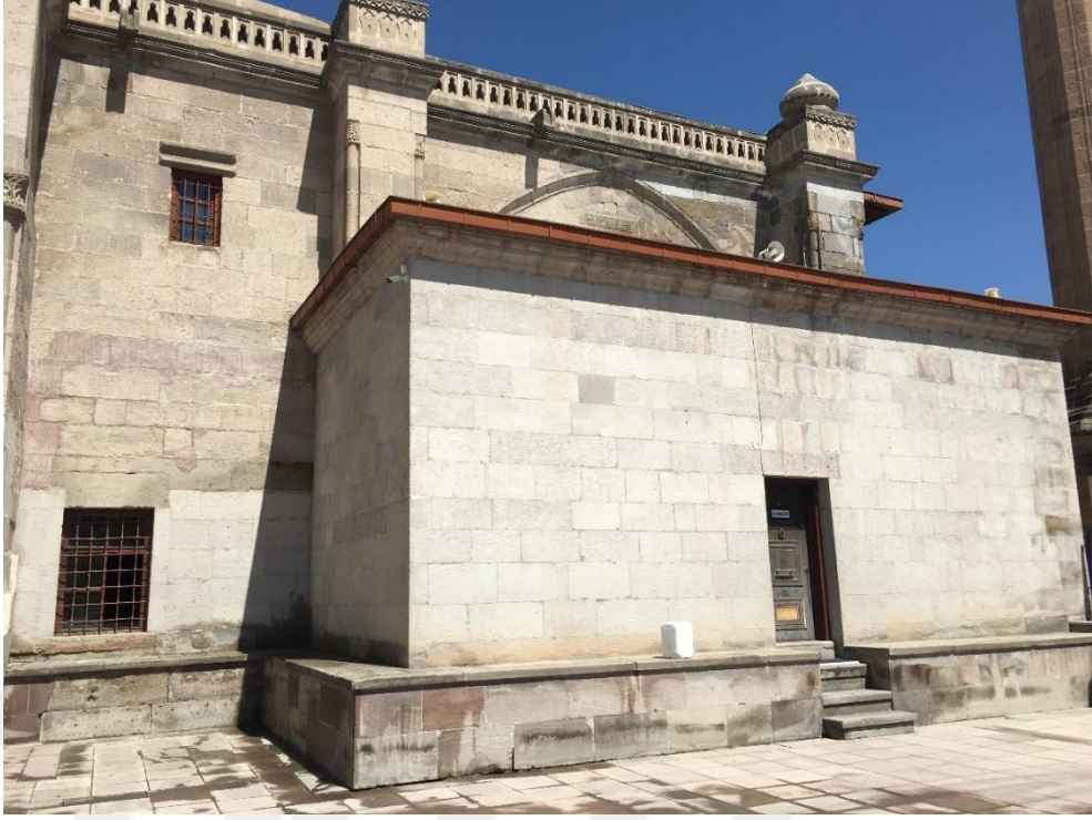
Şekil 4. 89. Aksaray Ulu Camii batı cephenin güney bölümü ve muvakkithane
