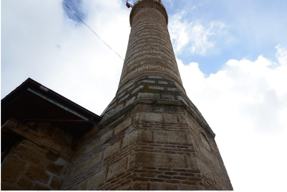
Şekil 4. 223. Doğanhisar Ulu Camii minaresi
