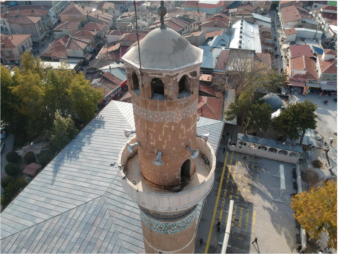
Şekil 4. 181. Ereğli Ulu Camii minaresi petek ve külah kısmı
