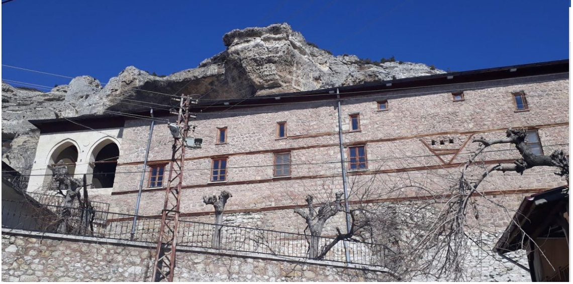
Şekil 4. 66. Ermenek Ulu Camii güney cephe sol kısmı görünüşü
