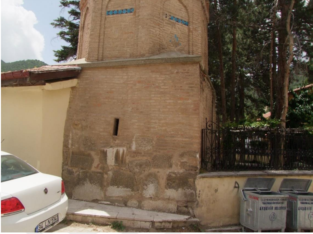
Şekil 4. 57. Akşehir Ulu Camii minare kaidesi doğu cephesi
