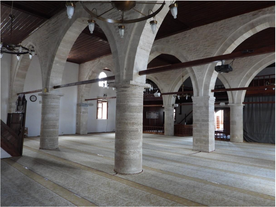
Şekil 4. 139. Kazım Karabekir Ulu Camii harim genel görünüşü
