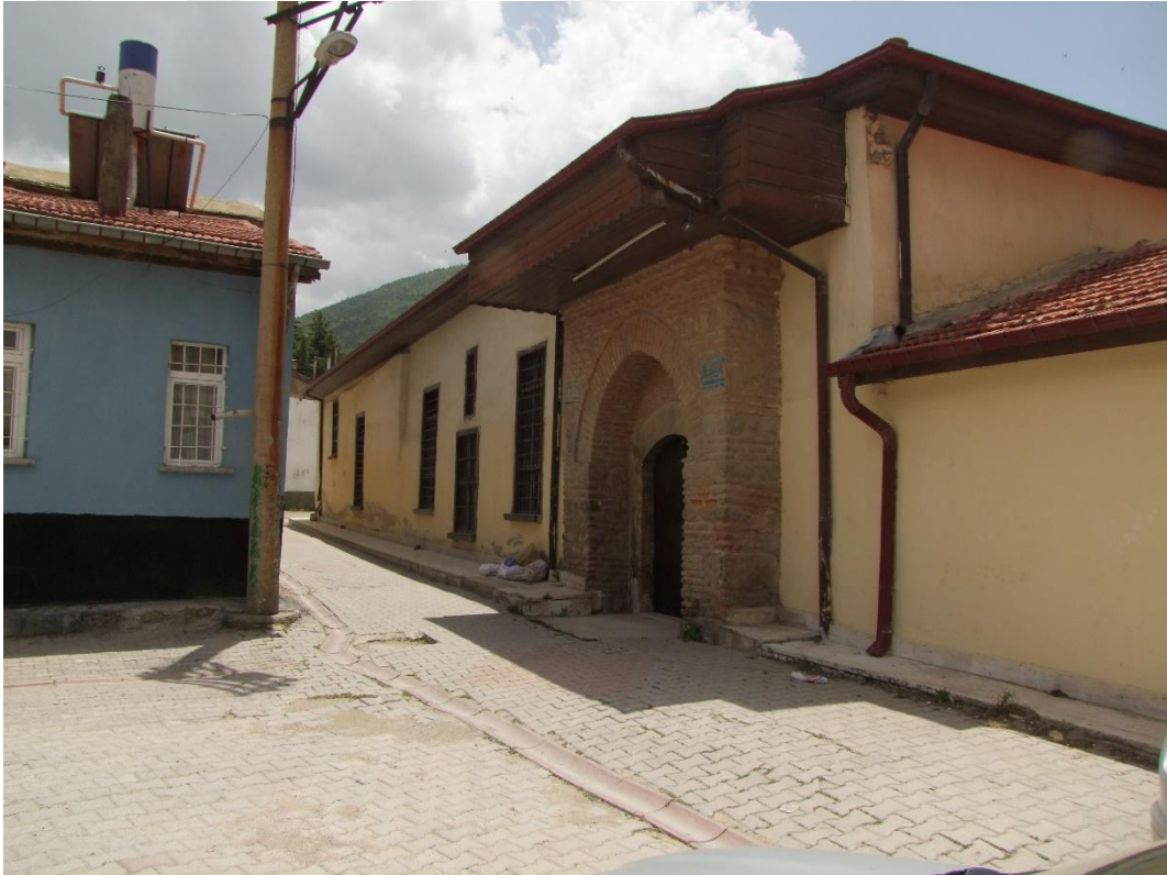
Şekil 4. 42. Akşehir Ulu Camii doğu cephe
