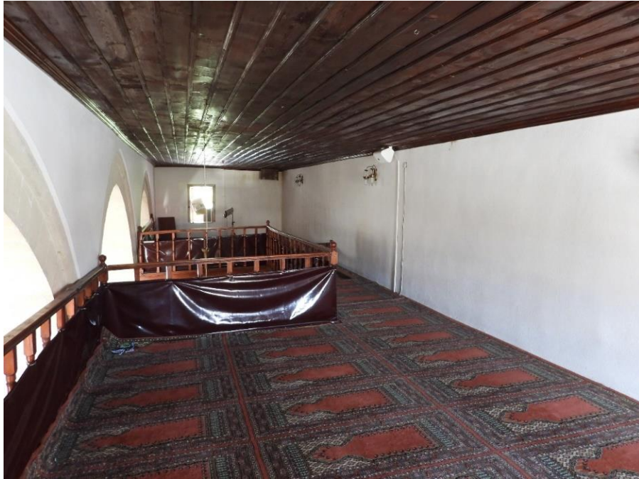
Şekil 4. 142. Kazım Karabekir Ulu Camii mahfil katı
