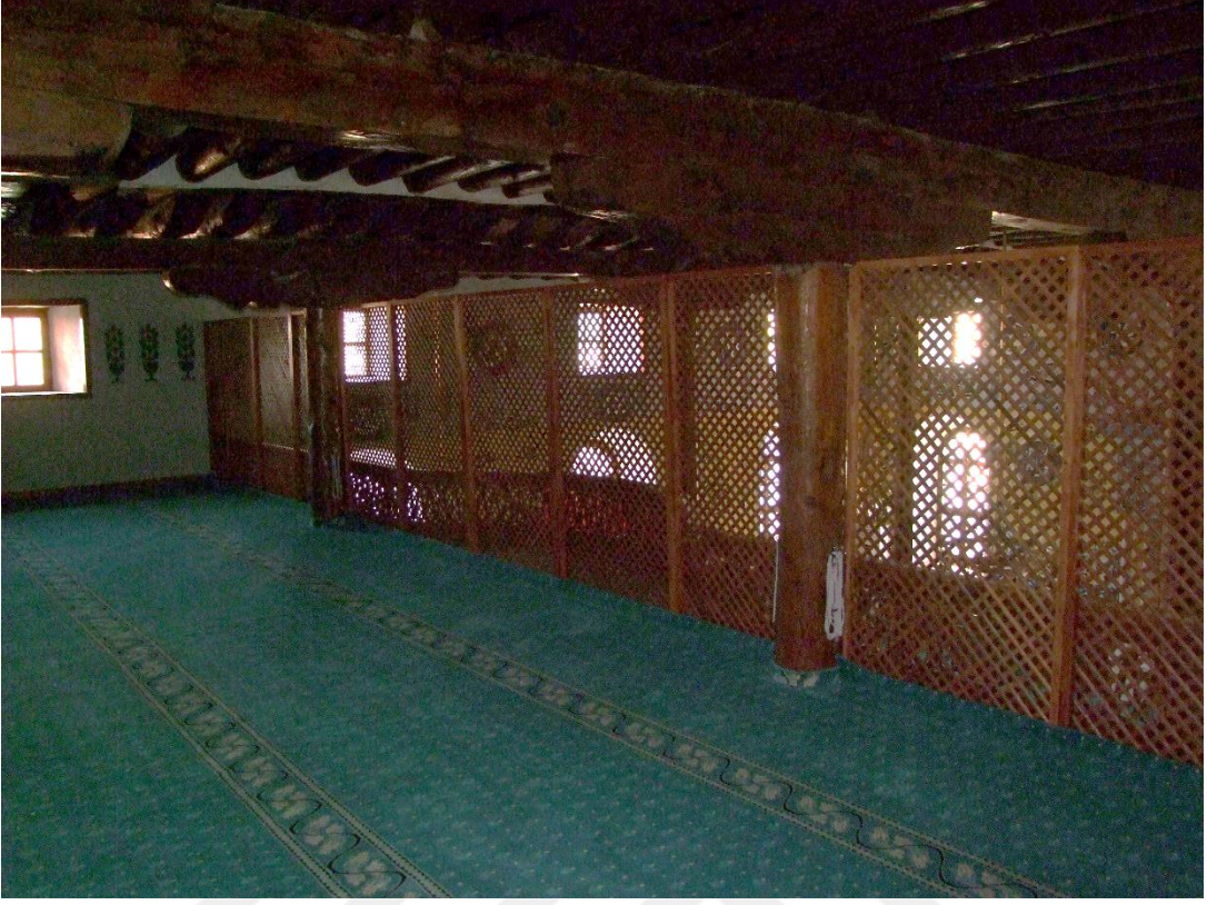
Şekil 4. 278. Karaağa Ulu Camii mahfil katı genel görünüşü
