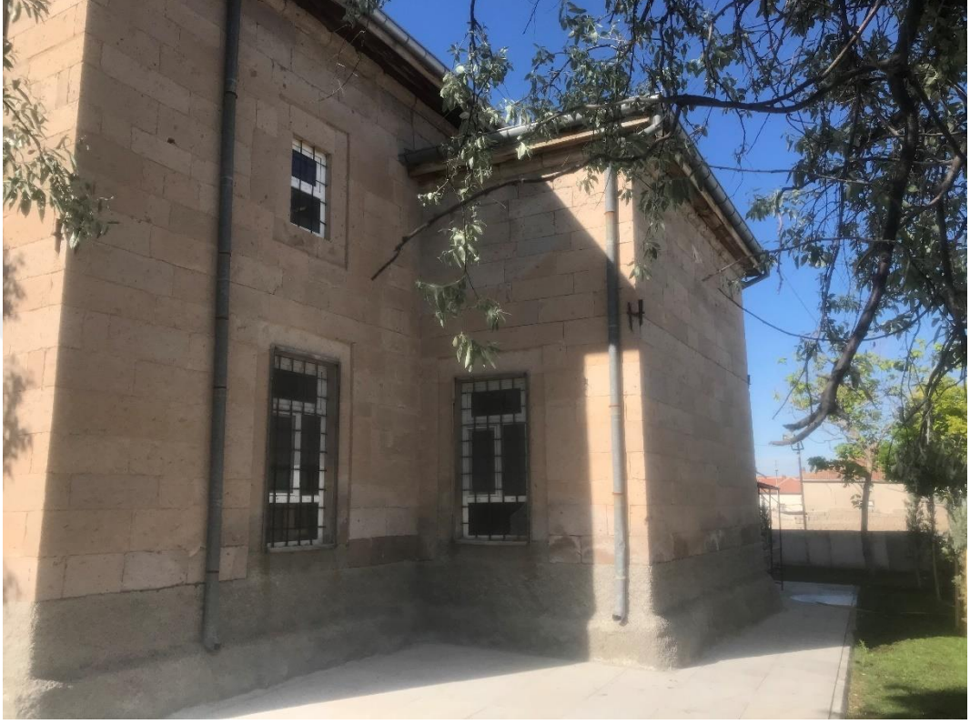
Şekil 4. 353. Yeşiltepe Ulu Camii güney cephe
