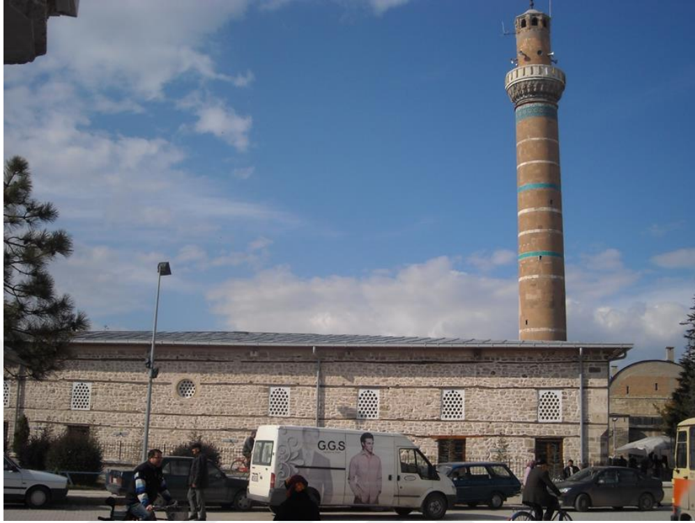
Şekil 4. 158. Ereğli Ulu Camii güney cephe
