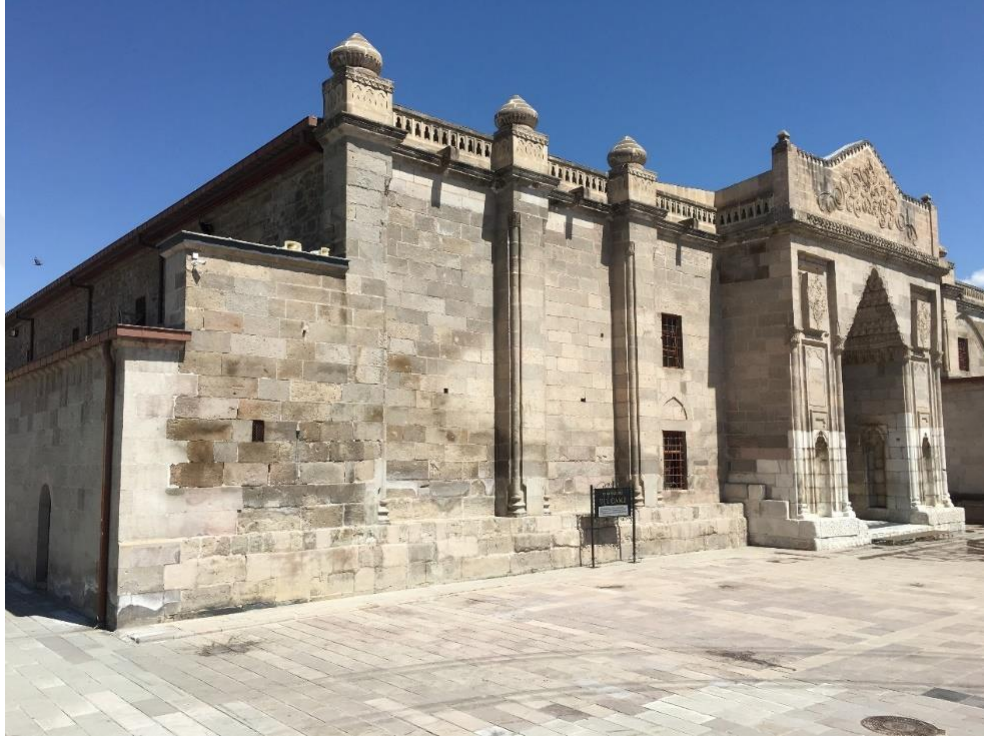
Şekil 4. 88. Aksaray Ulu Camii batı cephenin kuzey bölümü
