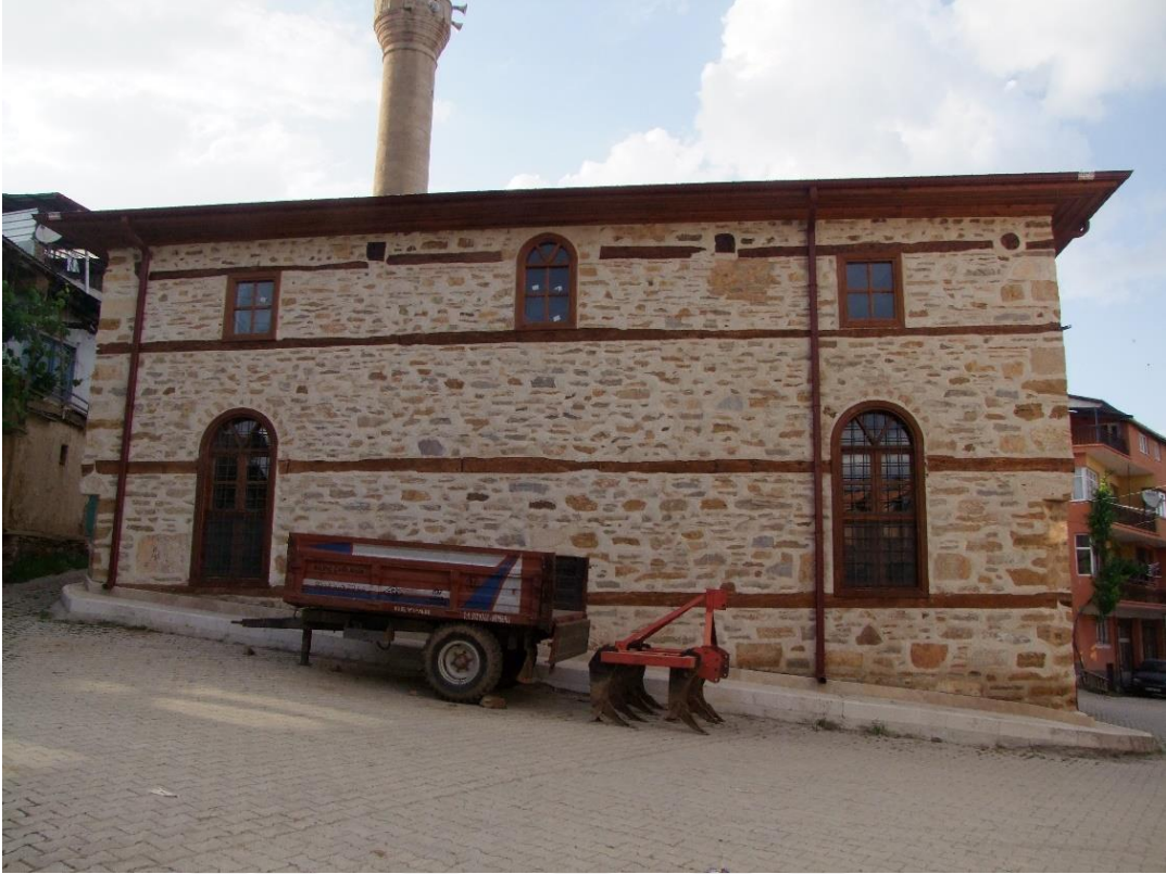
Şekil 4. 273. Karaağa Ulu Camii güney cephe
