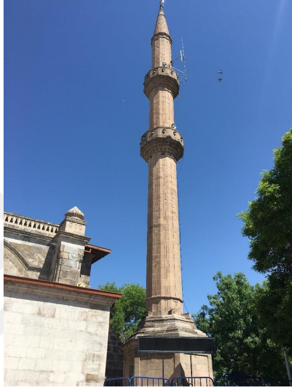
Şekil 4. 110. Aksaray Ulu Camii'nin minaresi
