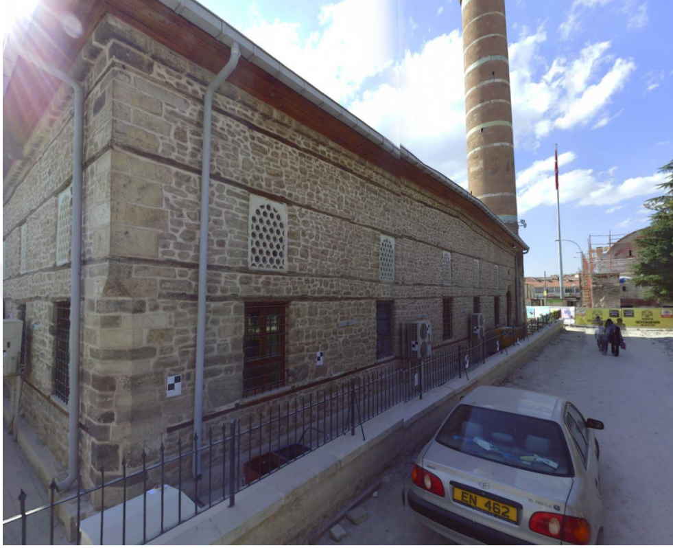
Şekil 4. 150. Ereğli Ulu Camii doğu cephe güney köşeden bakış
