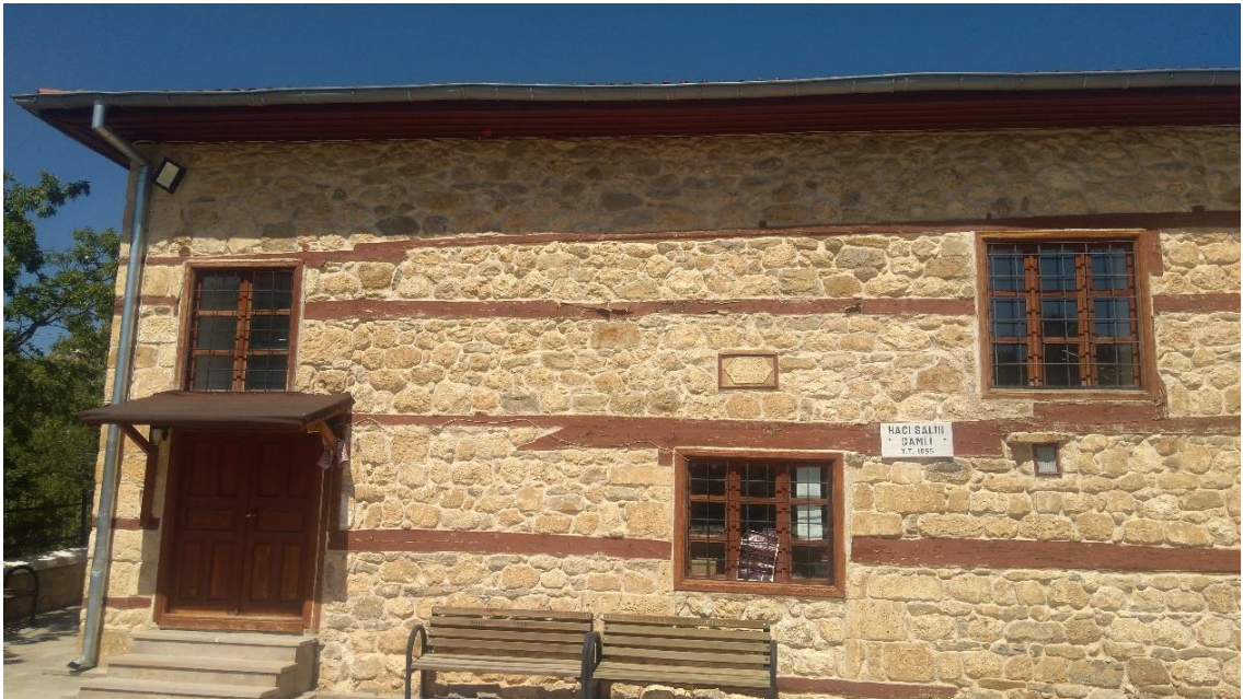
Şekil 4. 186. Sarıveliler Hacısalih Ulu Camii batı cephe
