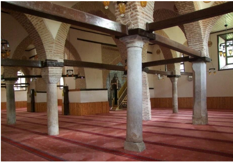
Şekil 4. 46. Akşehir Ulu Camii harim içindeki tuğla ve mermer ayakların görünüşü
