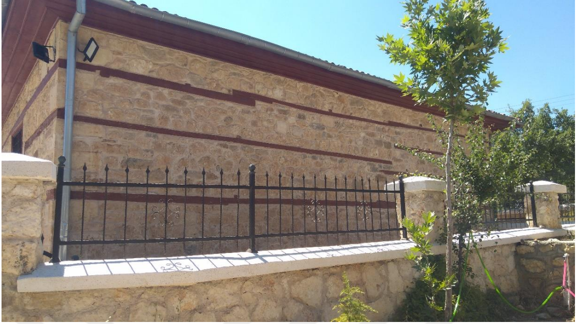
Şekil 4. 185. Sarıveliler Hacısalih Ulu Camii doğu cephe
