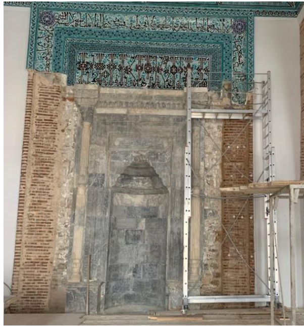
Şekil 4. 32. Konya (Alaeddin) Ulu Camii çini mihrabı (onarım sırasında çekilmiş olup orijinal olmayan bölümler sökülüştür.)
