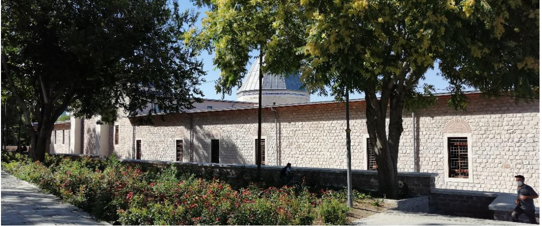
Şekil 4. 19. Konya (Alaeddin) Ulu Camii güney cephenin doğu kısmı
