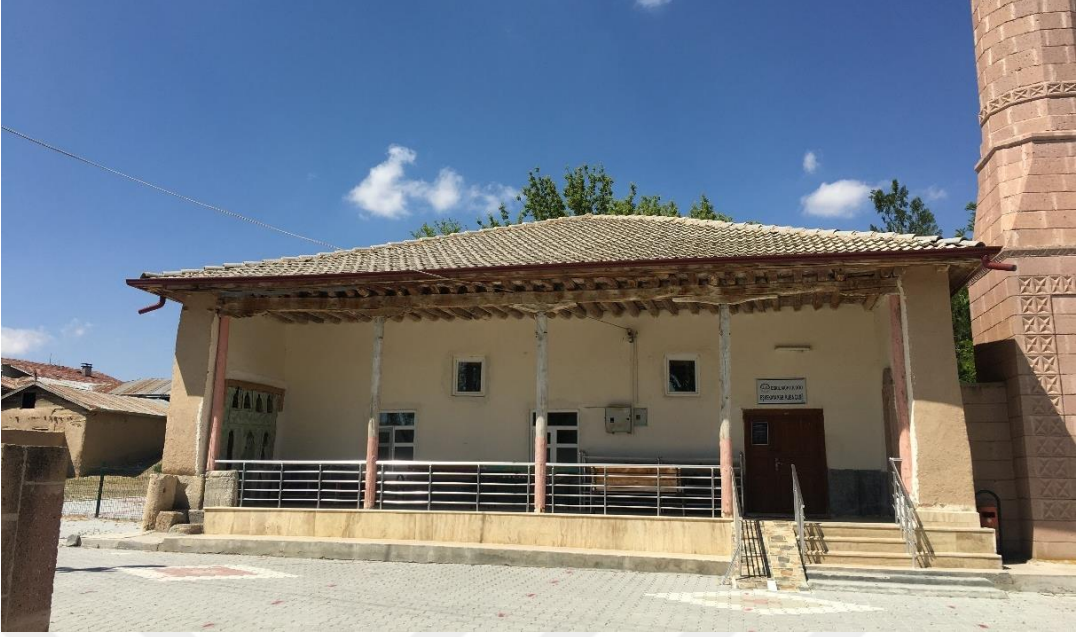
Şekil 4. 288. Eşmekaya Ulu Camii doğu cephe
