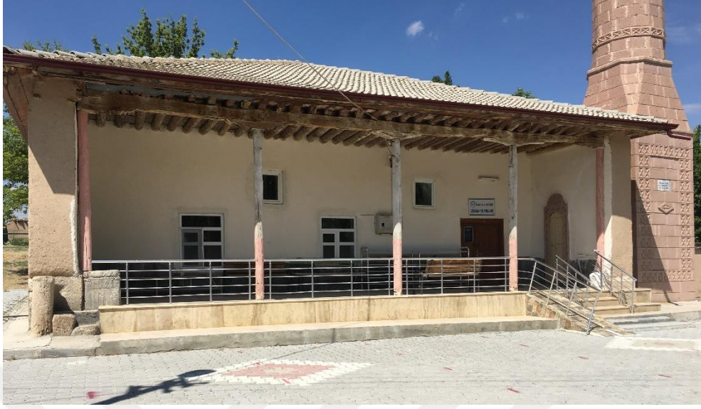
Şekil 4. 286. Eşmekaya Ulu Camii doğu cephe
