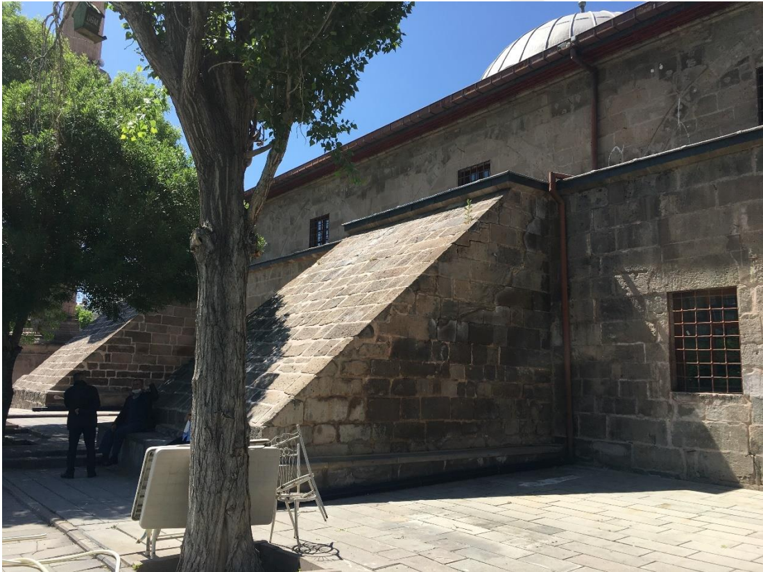
Şekil 4. 99. Aksaray Ulu Camii güney cepheye yer alan taş payandalar
