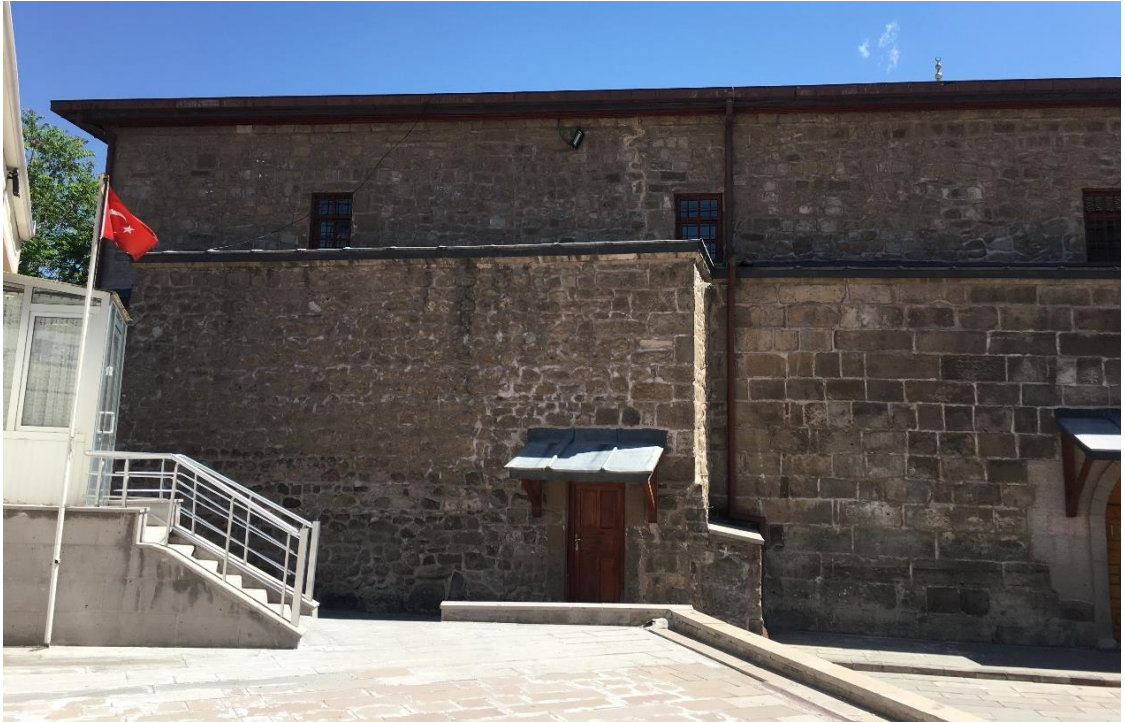
Şekil 4. 93. Aksaray Ulu Camii kuzey cephenin doğu kısmı
