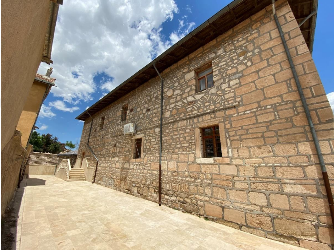
Şekil 4. 119. Yollarbaşı Ulu Camii batı cephe
