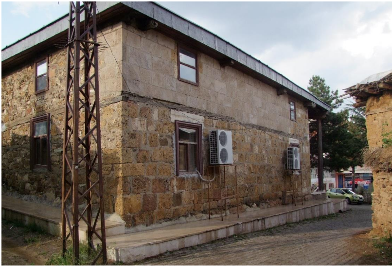
Şekil 4. 322. Deşdiğin Ulu Camii güney cephe
