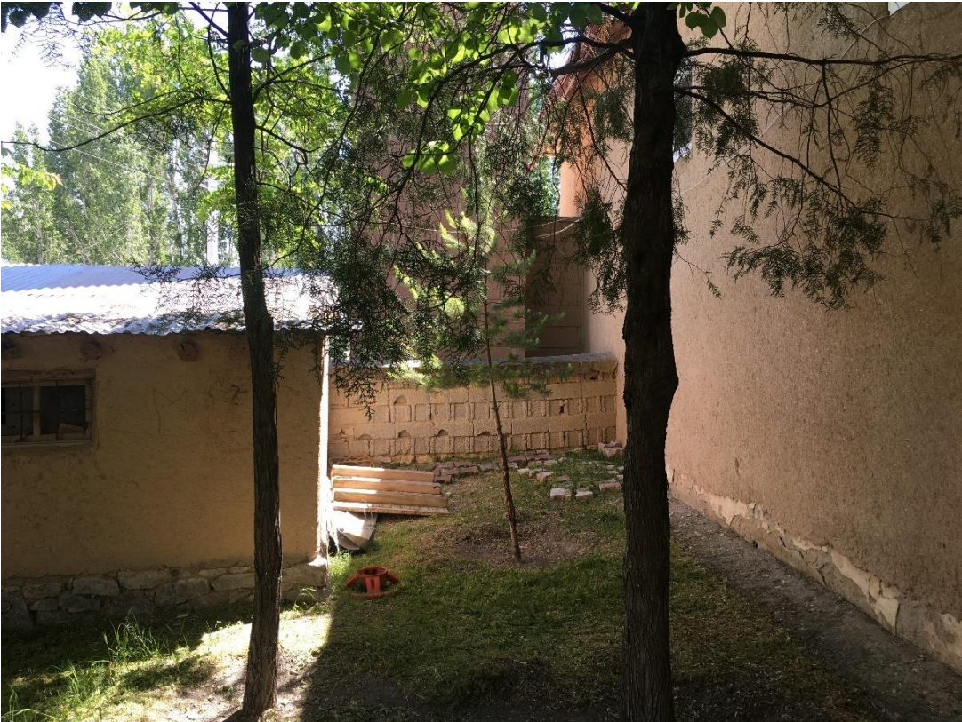
Şekil 4. 289. Eşmekaya Ulu Camii kuzey cephe
