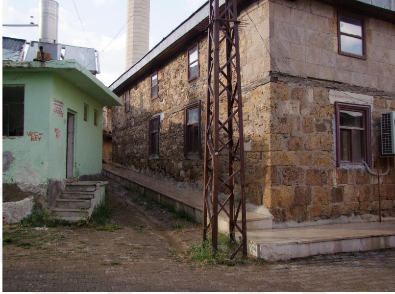
Şekil 4. 321. Deşdiğin Ulu Camii batı cephe
