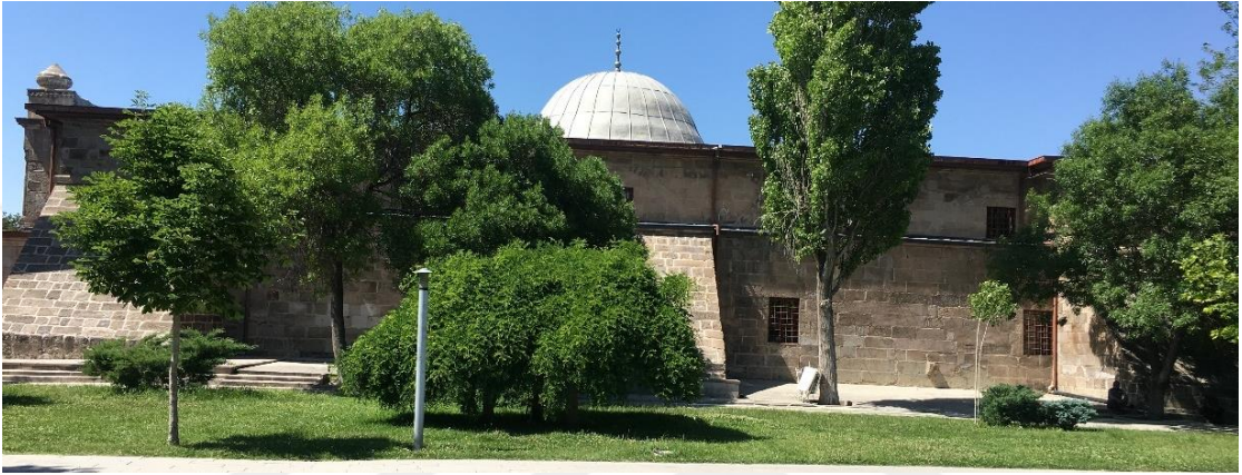
Şekil 4. 98. Aksaray Ulu Camii güney cephe genel görünüş
