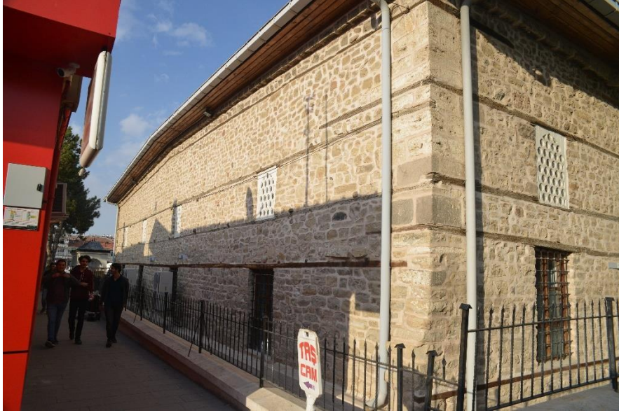
Şekil 4. 156. Ereğli Ulu Camii batı cephe güney köşeden bakış
