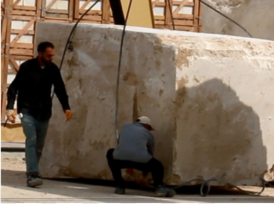
Şekil 3.5. Mermer bloklarının vinç halatlarına bağlanması
